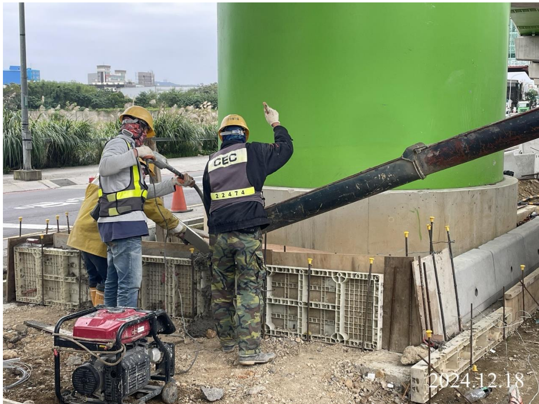
北段_道路復舊 M29 路緣石背填澆置
