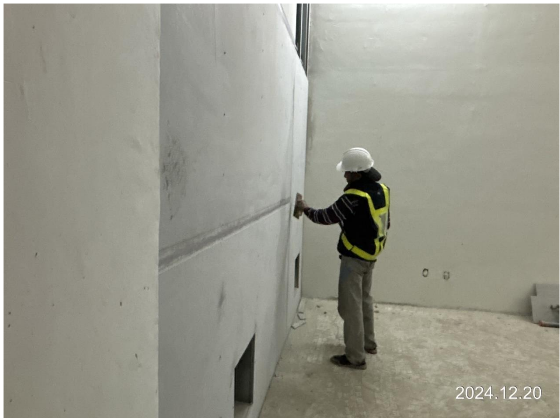
G31 車站出入口 B1F 復壁輕隔間封板批土
