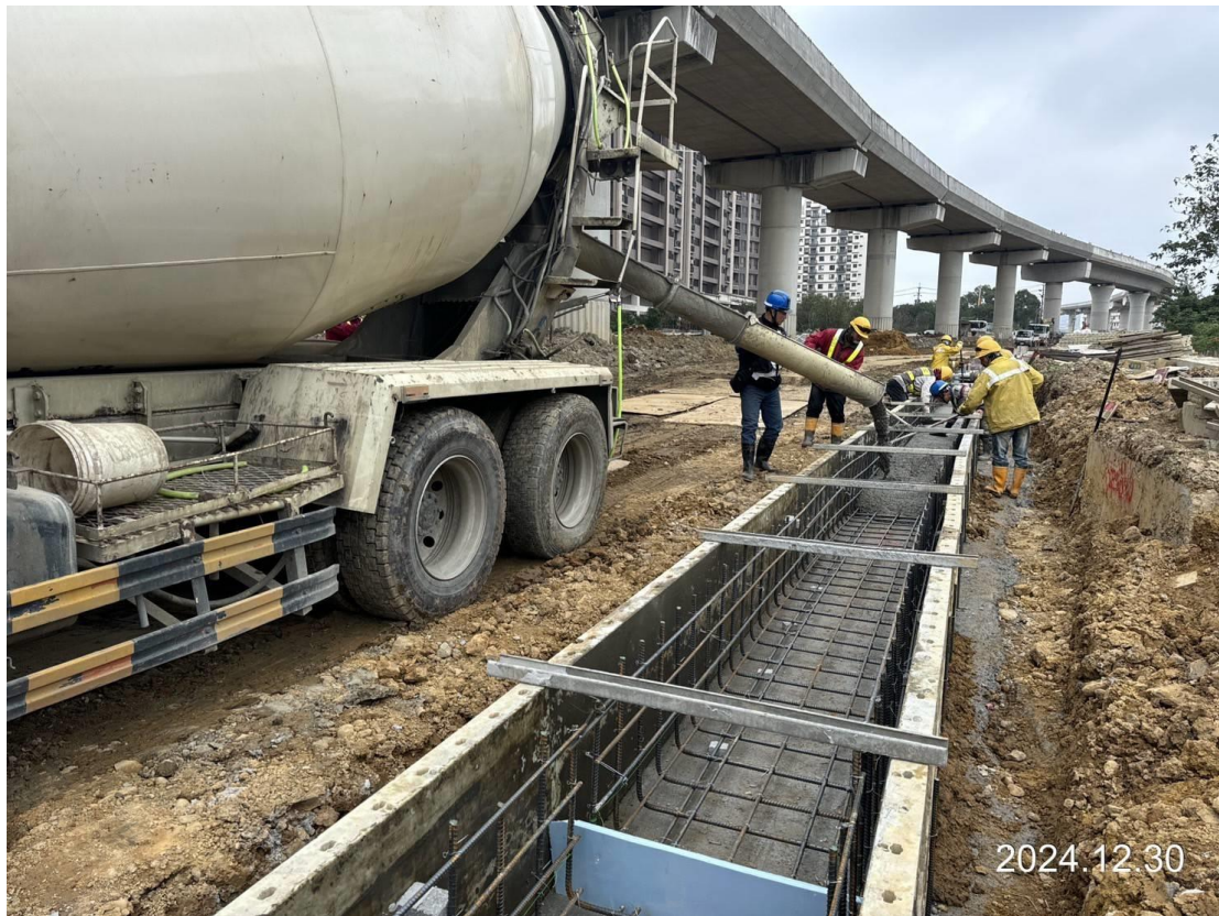
南段_出流管制 SCN-05 側溝(4k+720~731)澆置
