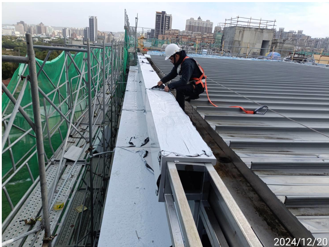
北段_G13 車站站體外牆鋁帷幕骨架及鋁板安裝
