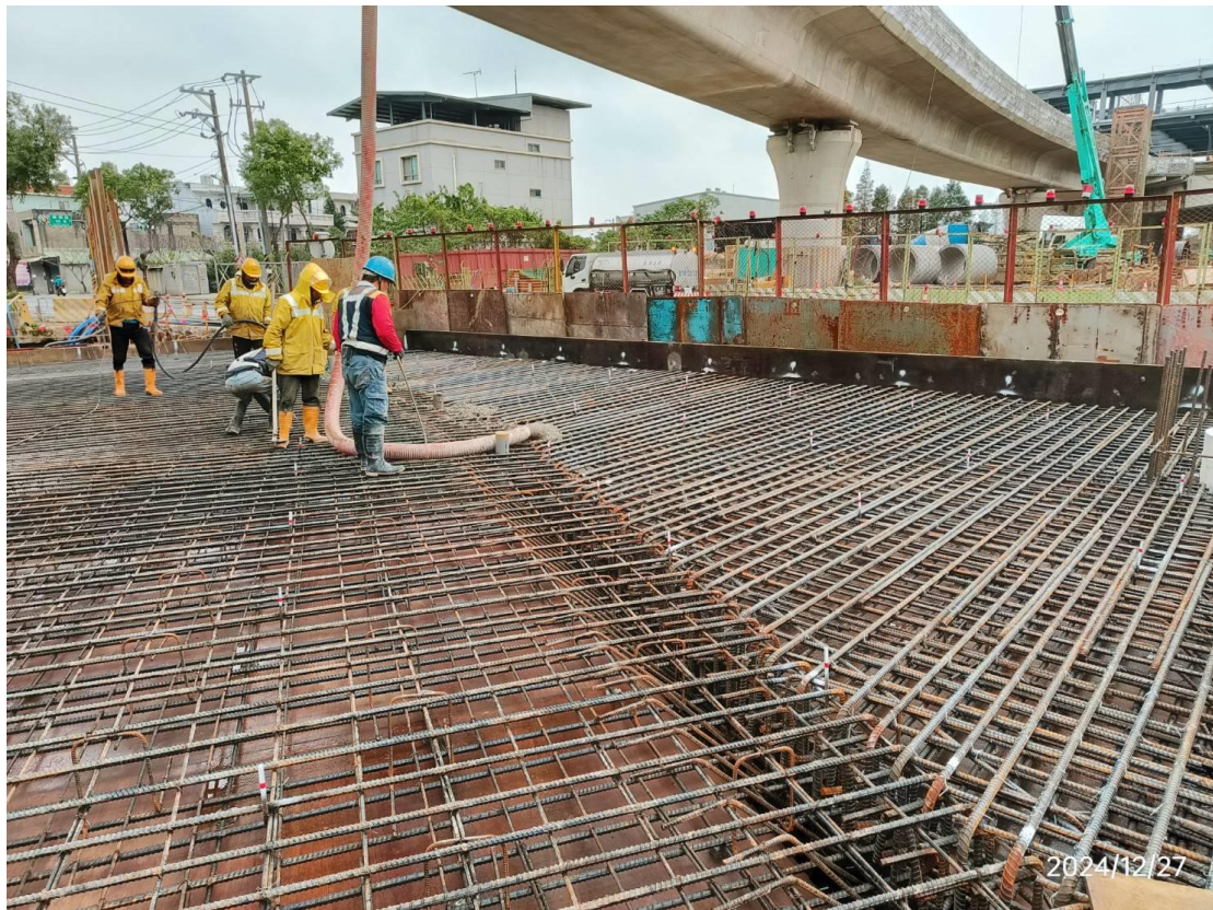
南段_皮寮溪箱涵第一階段牆身第二昇層、頂版完成面高程檢測、模板、鋼筋查驗及混凝土澆置
