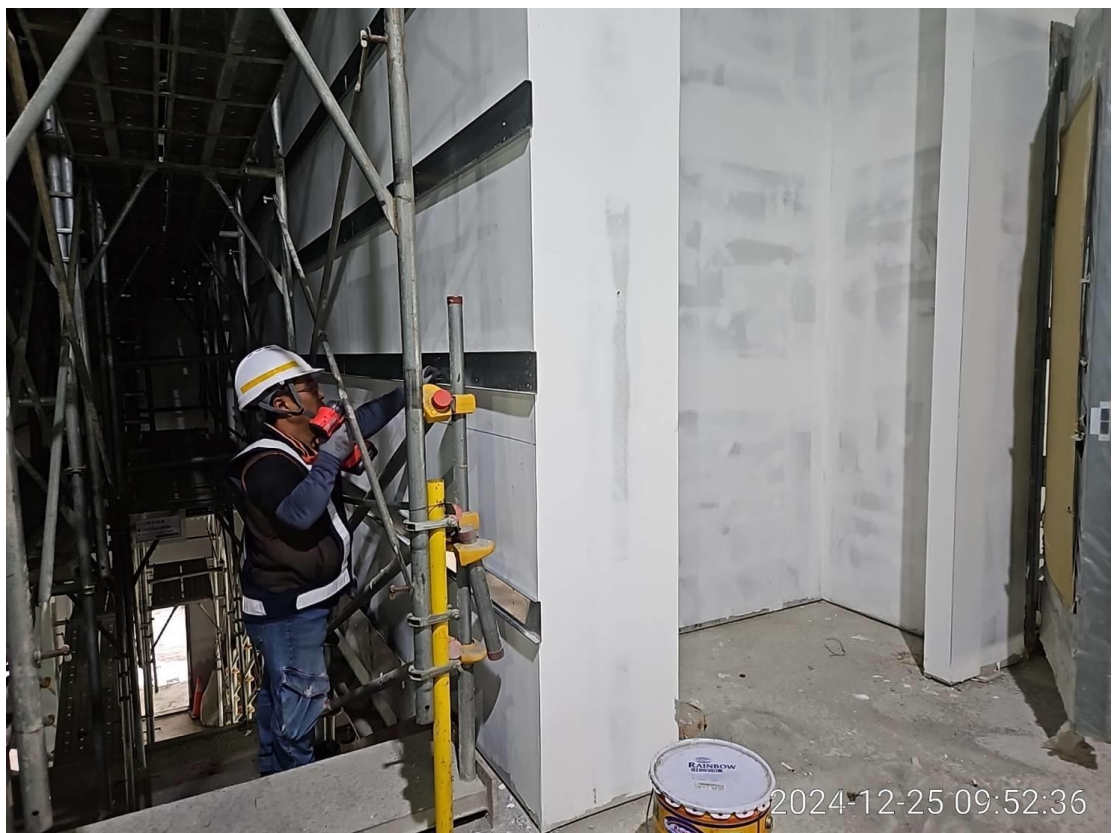
G14 車站站體金屬內牆板骨架放樣
