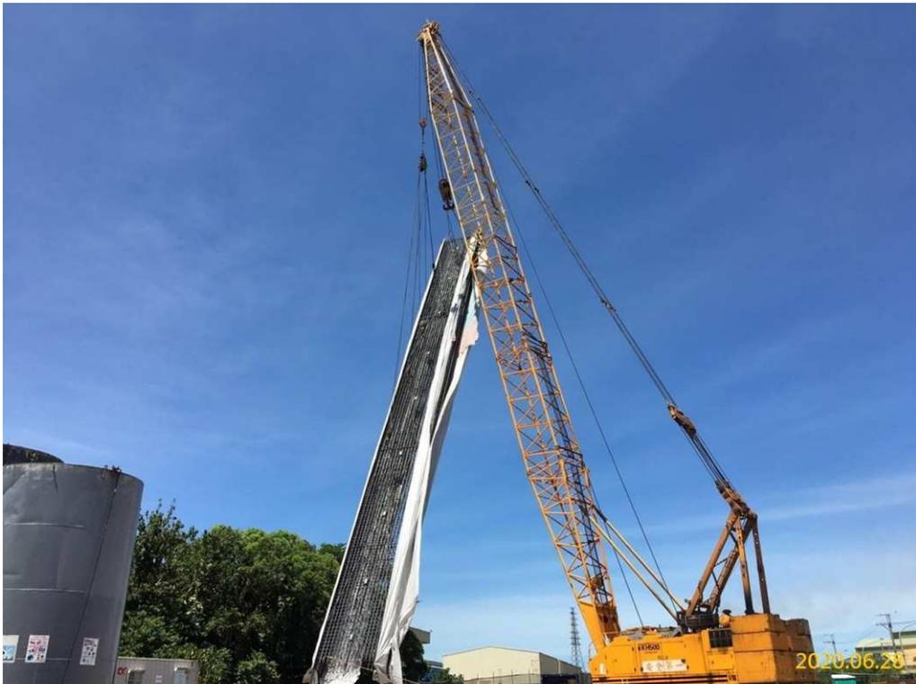
G03 站(巧克力街附近)連續壁單元鋼筋籠吊運
