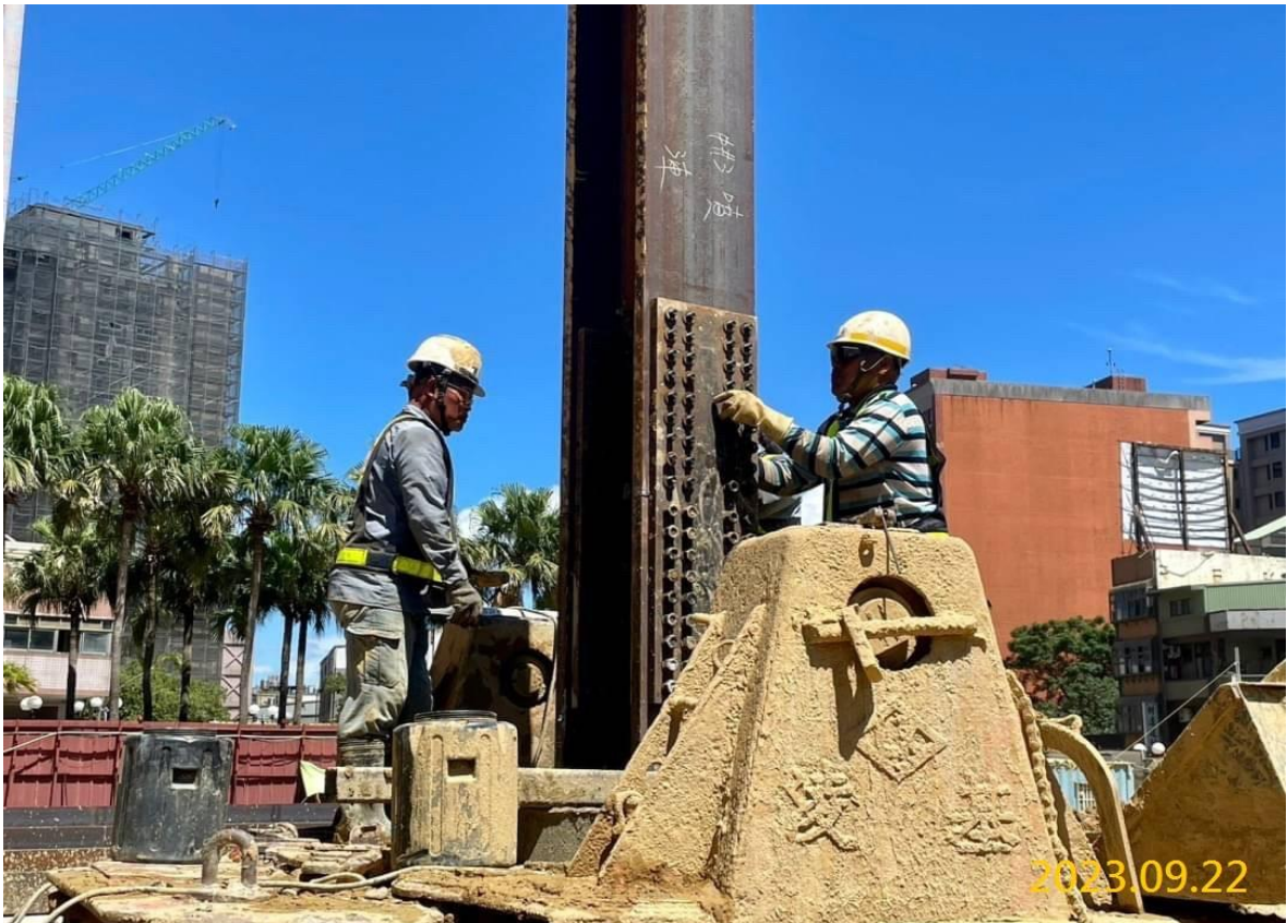
G04 站中間柱施作
