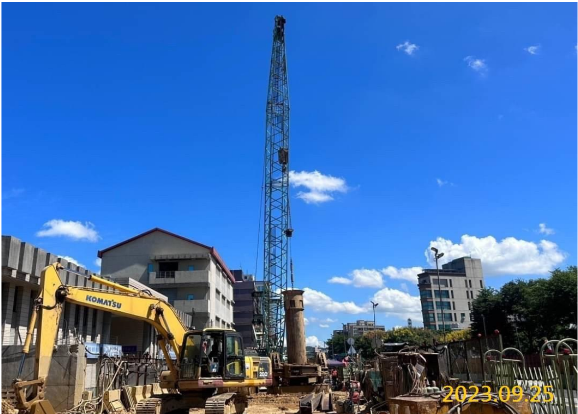
G06 站中間柱施作
