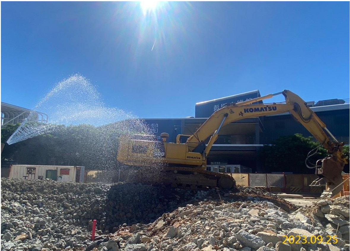
VS4 通風豎井開挖施作
