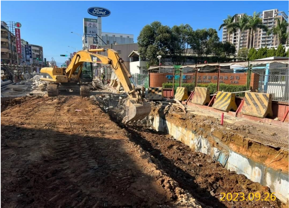
G05 站開挖施作
