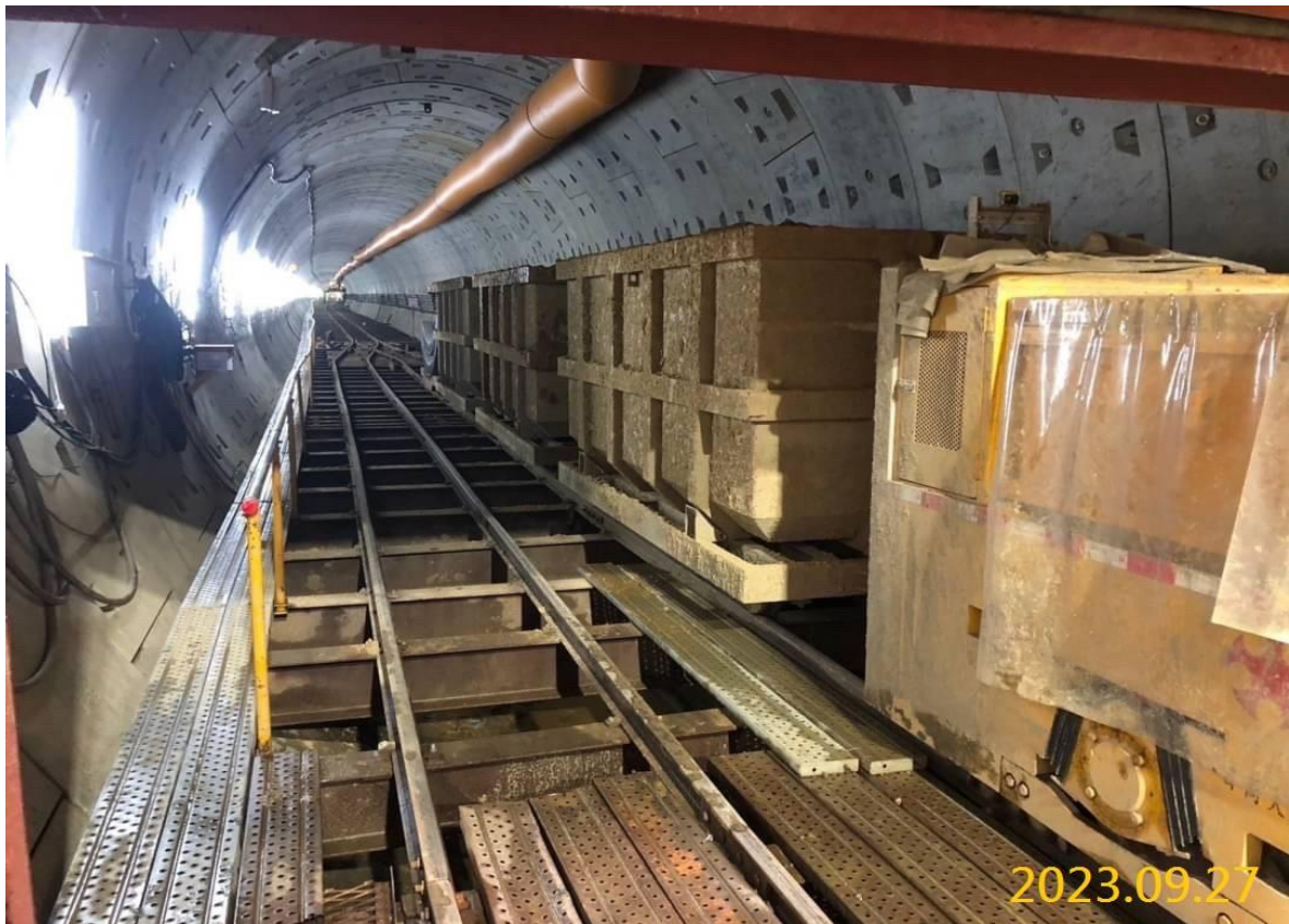
G03 站潛盾隧道掘進作業
