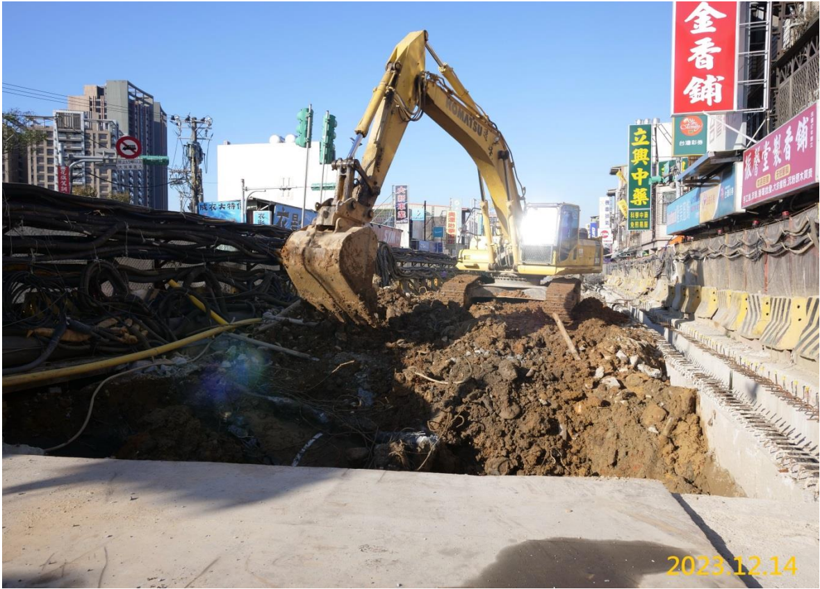
VS4 通風豎井開挖施作
