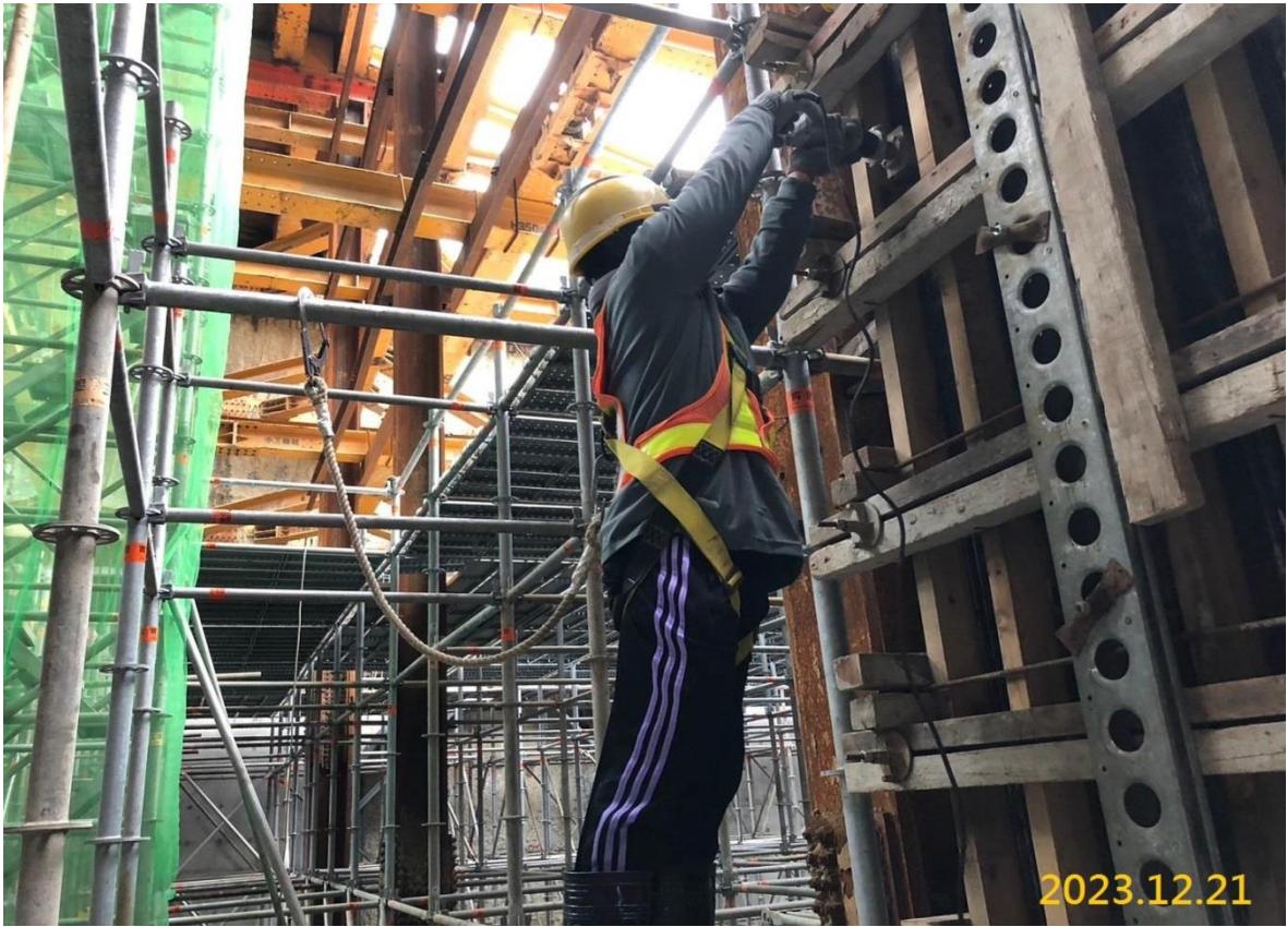
VS6 通風豎井結構施作
