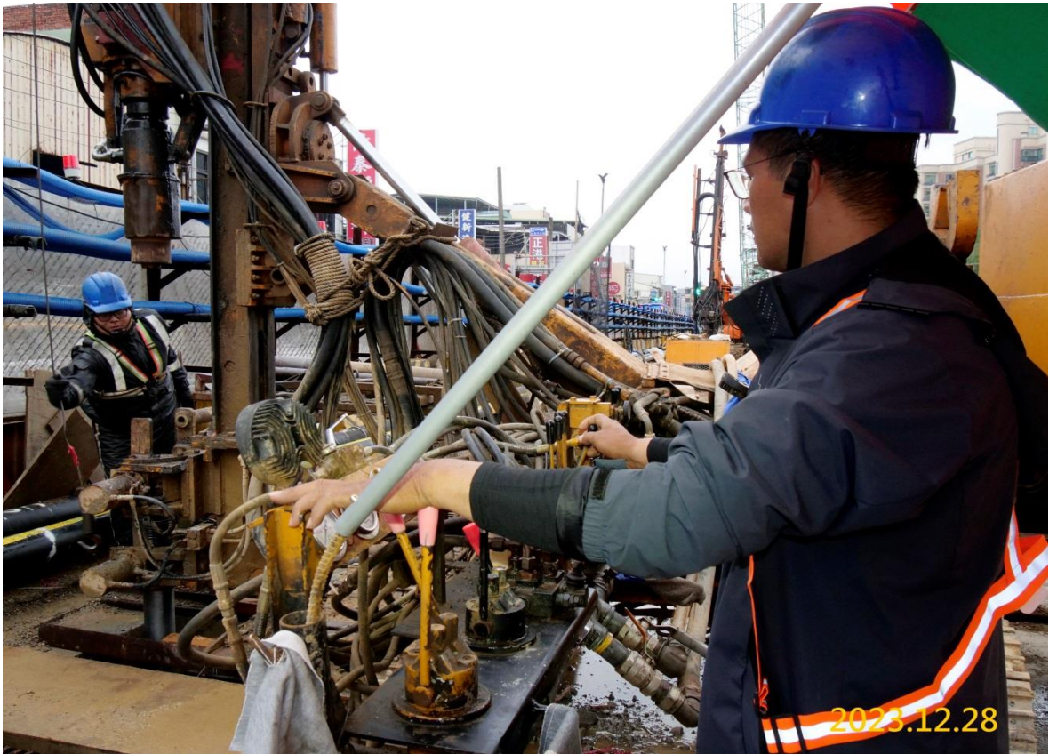
棕線維修軌明挖覆蓋段建物保護工程
