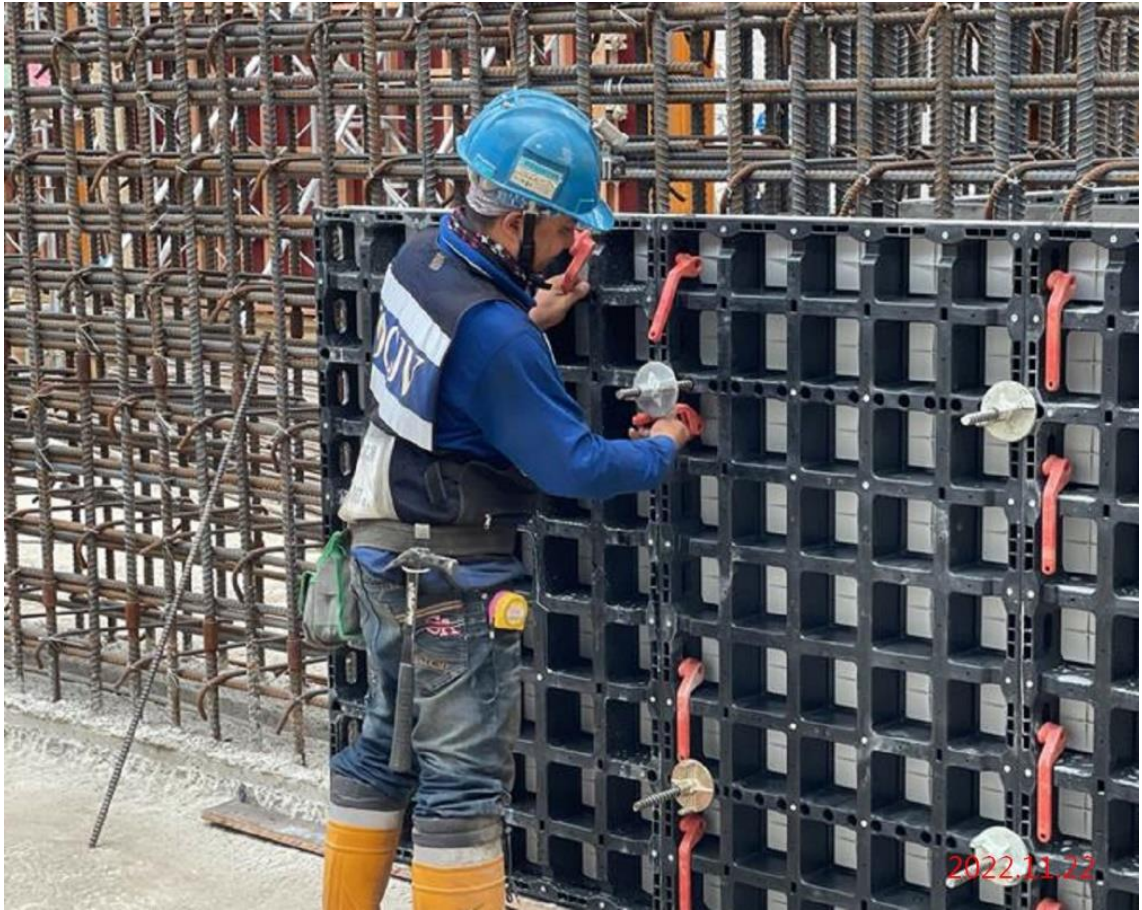
G12 站_承重牆模板組立
