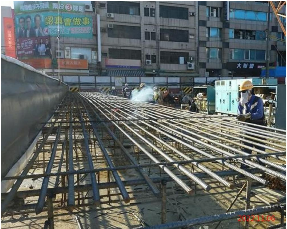
G09 站_連續壁鋼筋籠組立
