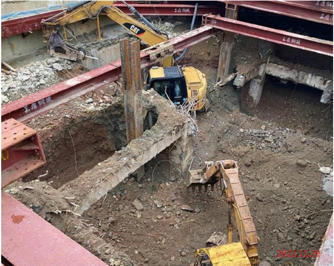
G08 站_站體開挖
