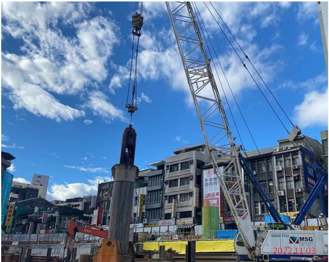
G08 站_中間柱抓掘
