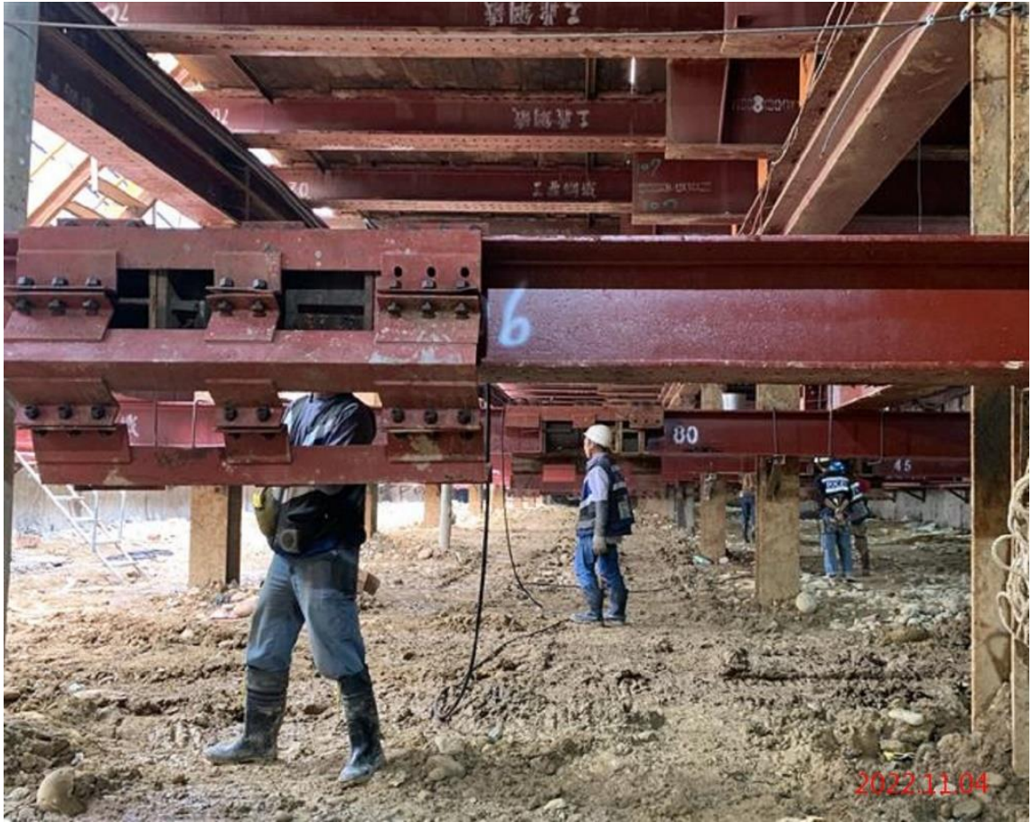
G11 站_出入口支撐系統施作
