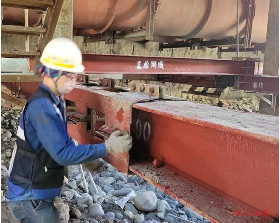
G10 站_擋土支撐施作
