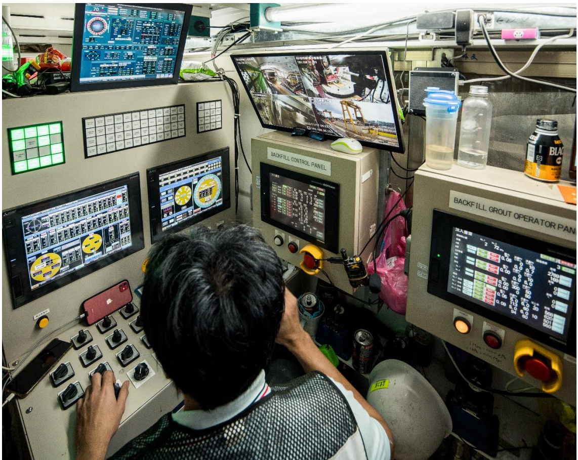
潛盾隧道_掘進
