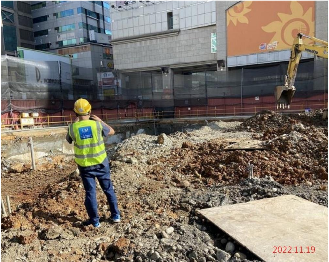
G07 站_站體結構開挖
