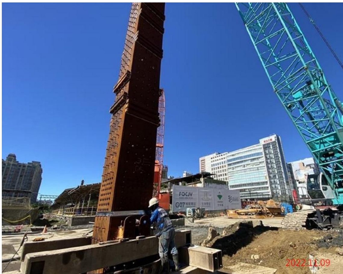
G07 站_逆打鋼柱吊放
