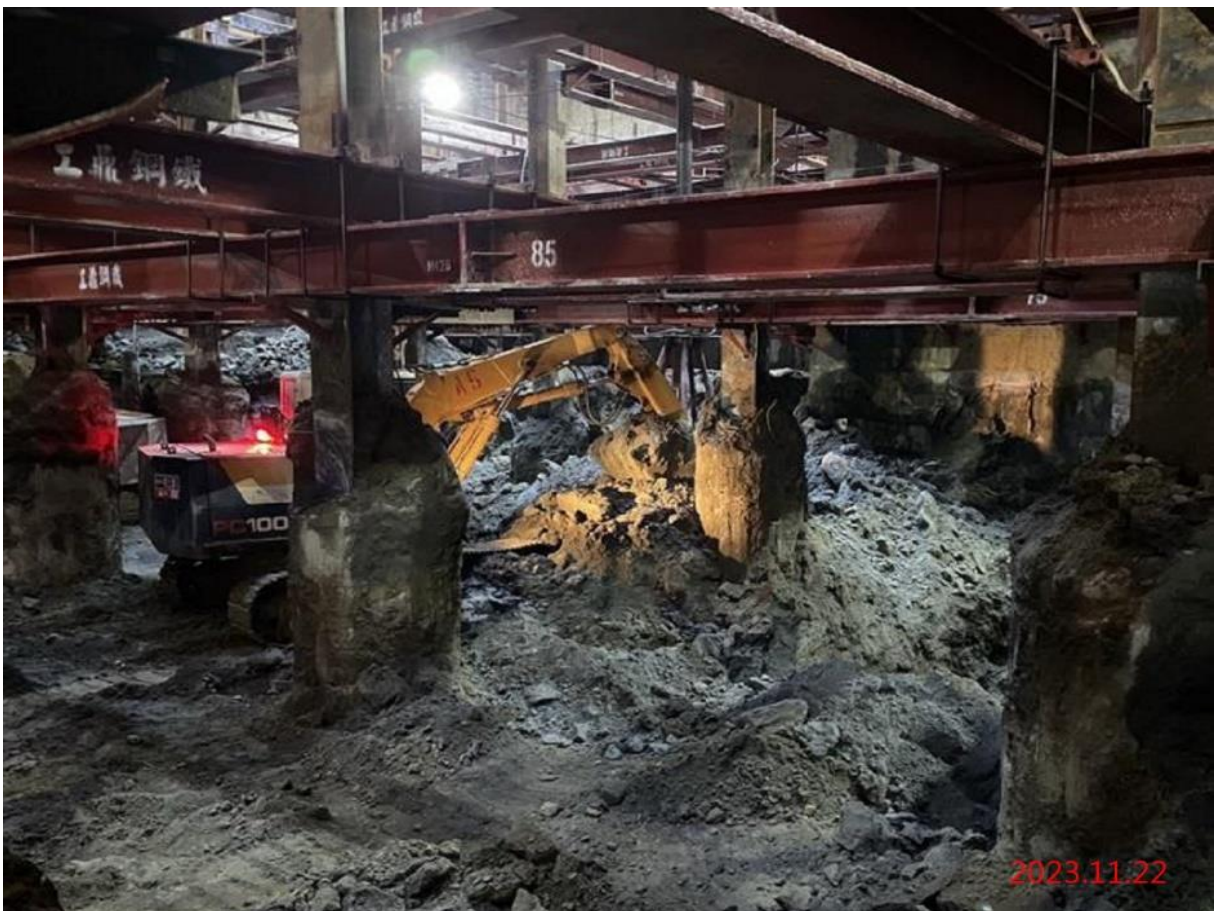
G09_第八層開挖
