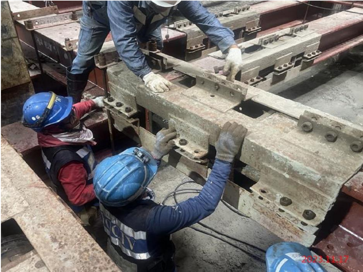
G09_第七層支撐系統螺栓鎖固
