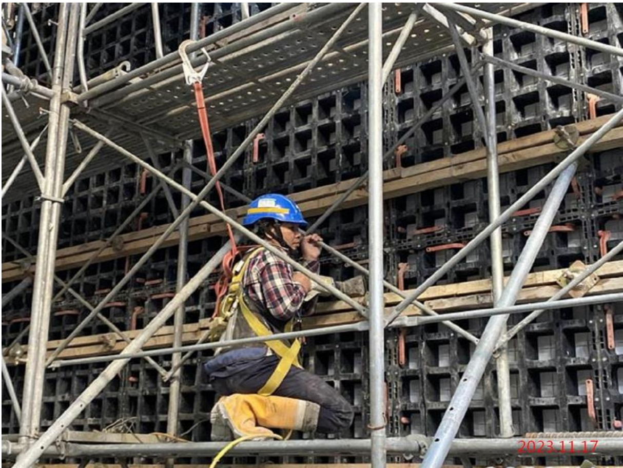
G11_出入口穿堂層承重牆澆置
