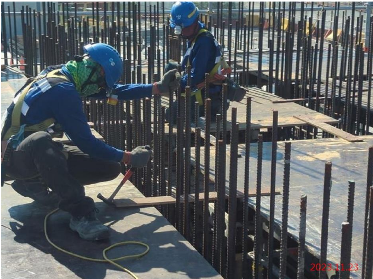
G12_通風井(X)2F 樓板模板施作
