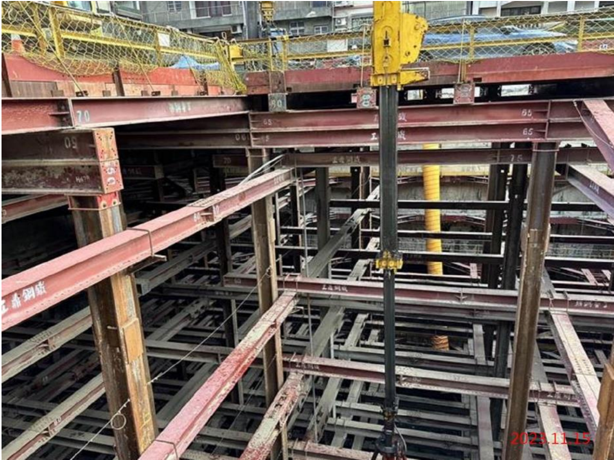
G08_第八層開挖
