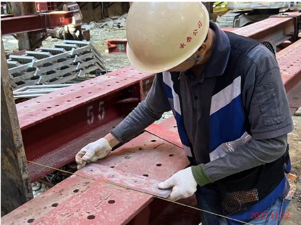
G08_第八層支撐系統施作
