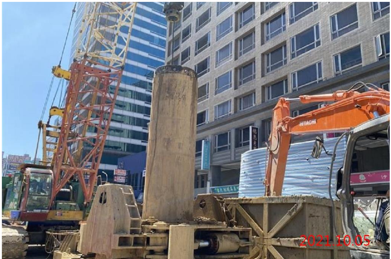
G11 站_站體中間柱施作
