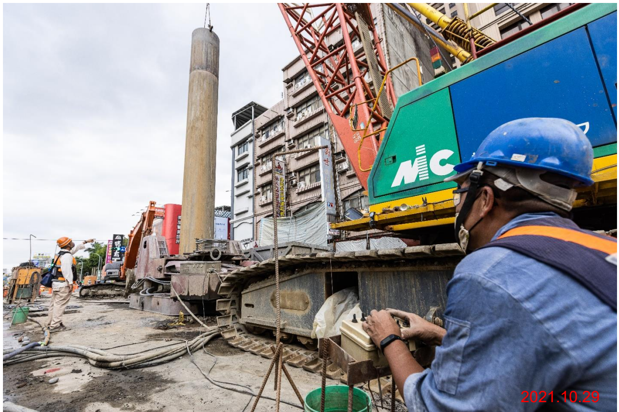
G10 站_站體中間柱施作
