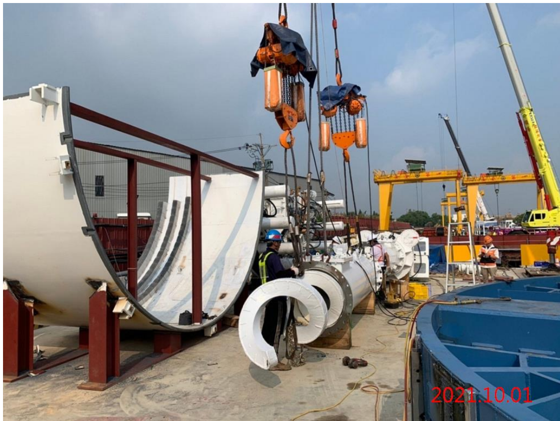
潛盾隧道_潛盾機組裝
