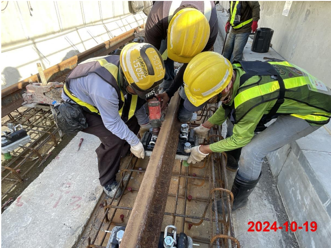
G13a-G14 站間軌道施工
