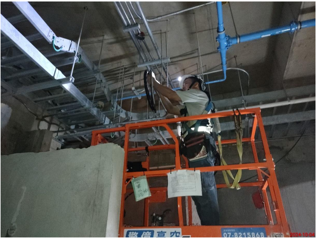
G13 站通訊系統施工
