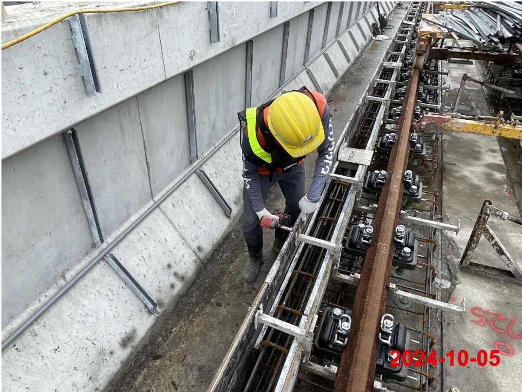
G13a-G14 站間軌道施工
