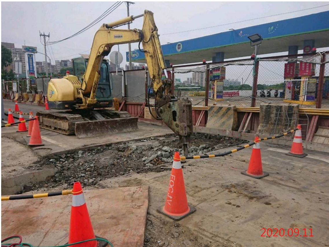
G12 站_南橫置連續壁管線探挖
