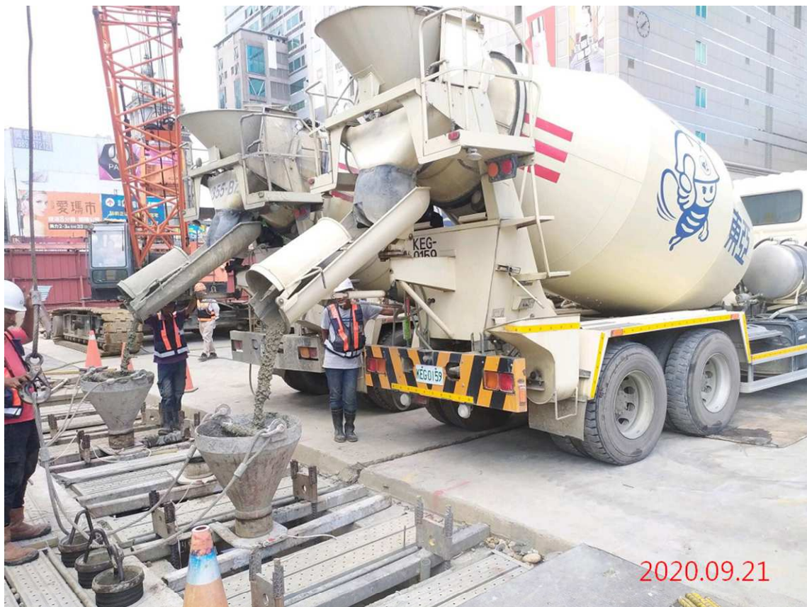
G07 站_連續壁單元澆置混凝土
