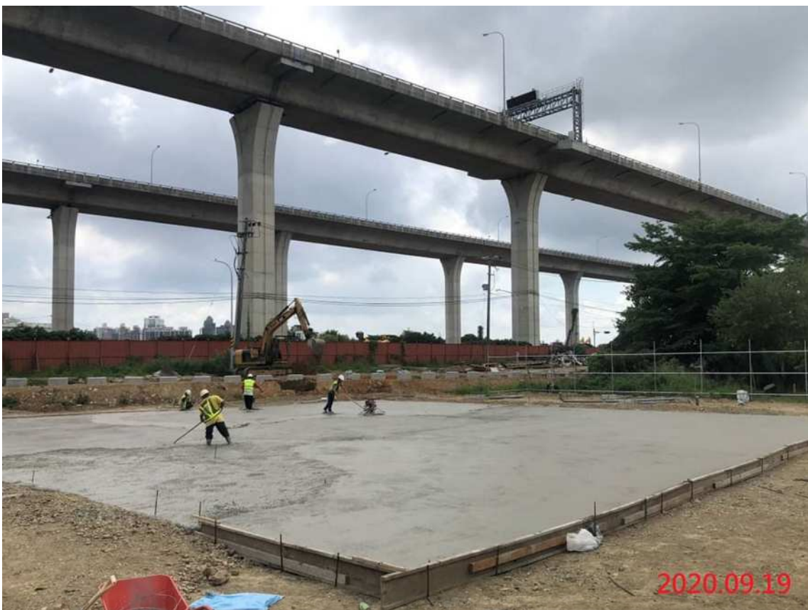
北出土段_工區臨時鋪面地坪澆置及粉光施工
