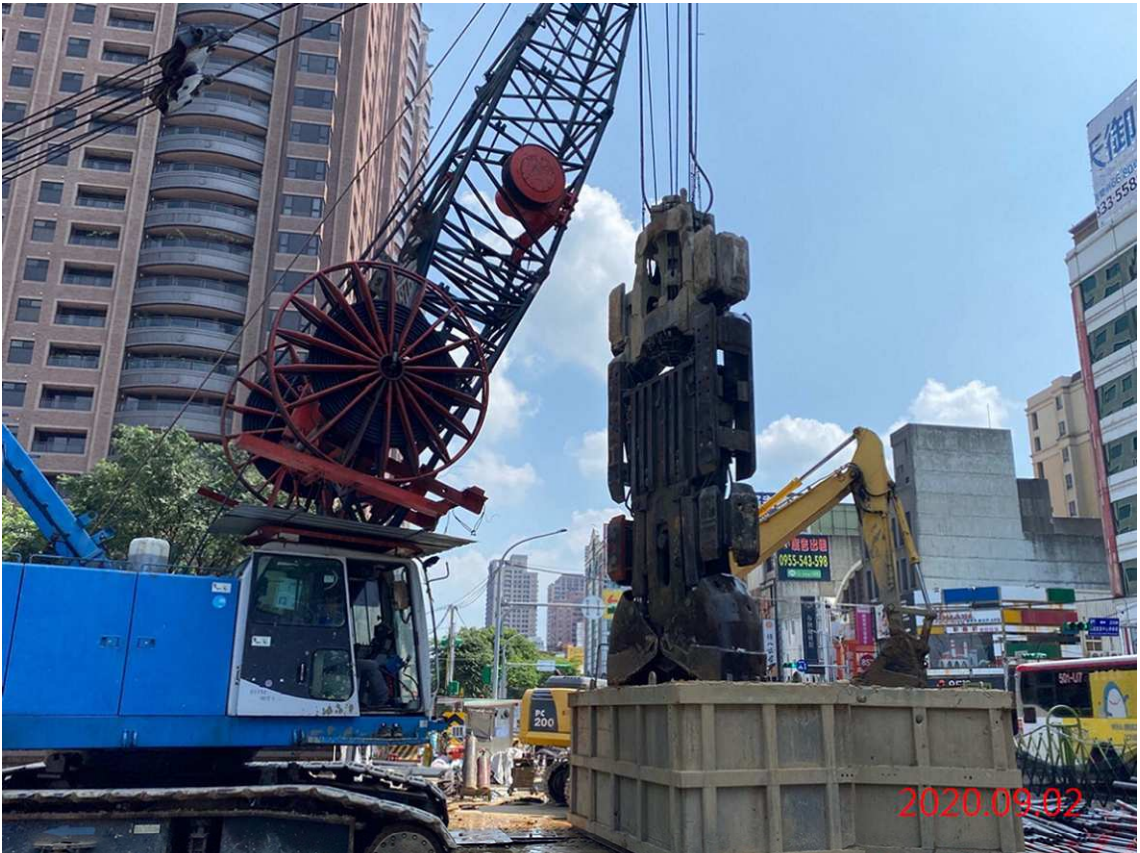
G11 站_AB 出入口連續壁單元抓掘
