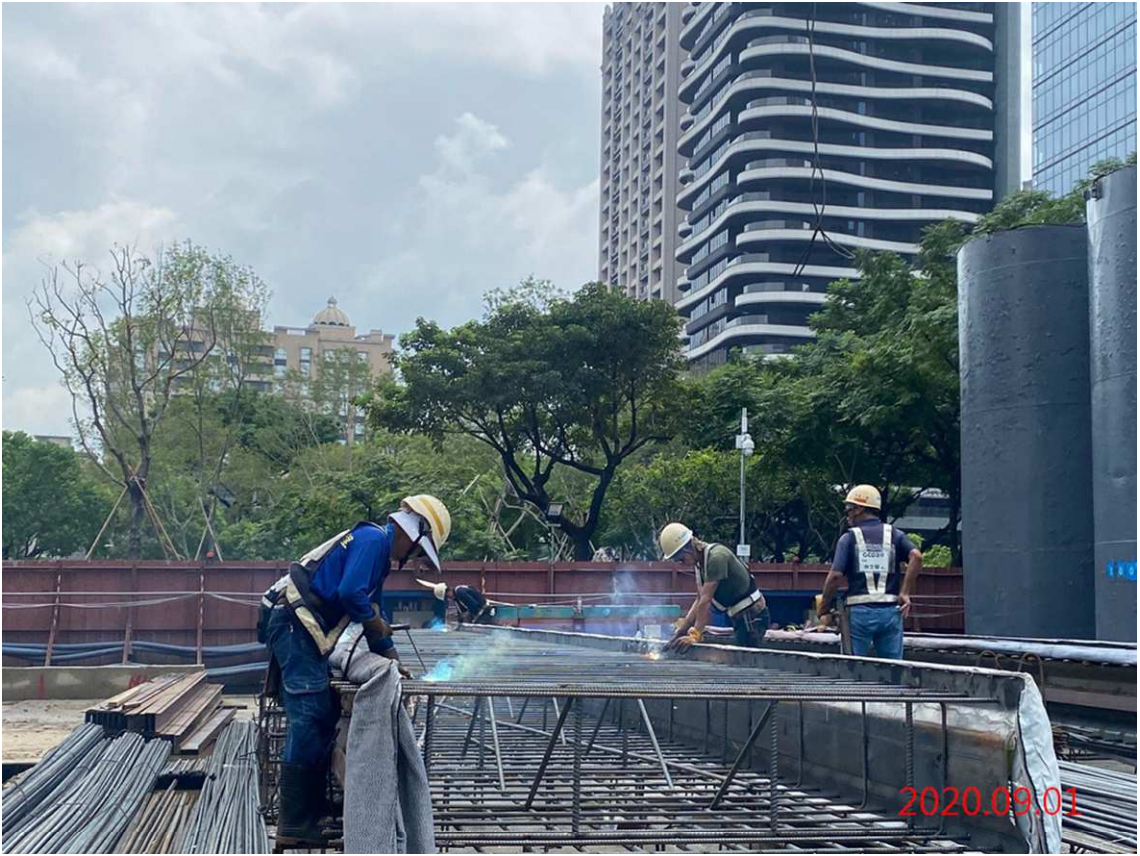
G11 站_鋼筋籠組立
