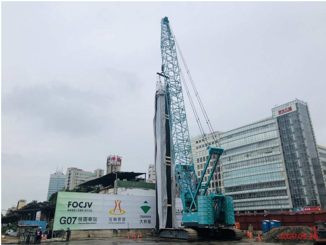
G07 站_連續壁鋼筋籠吊放
