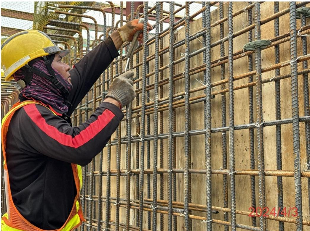
北機廠駐車區月台牆身鋼筋綁紮作業
