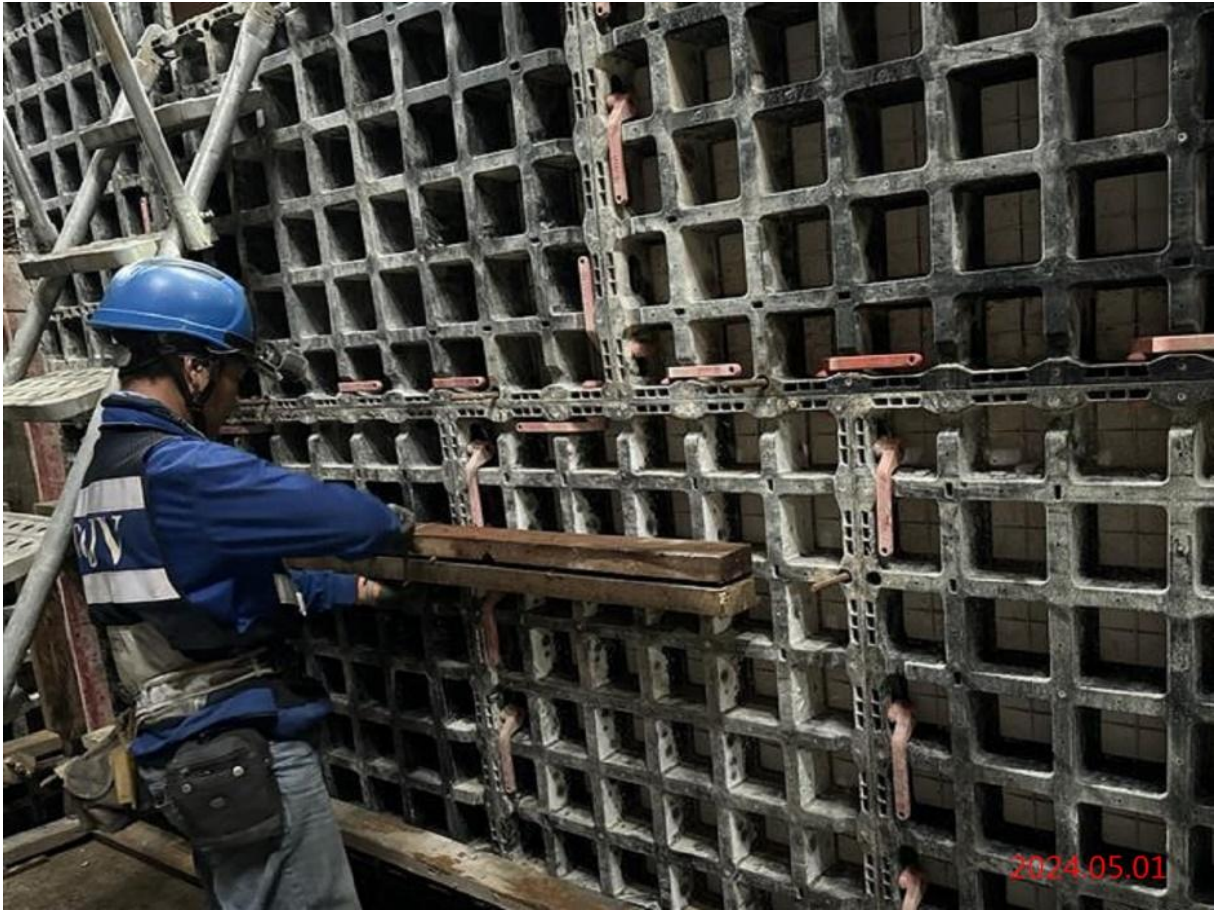
G08_地樑模板施作
