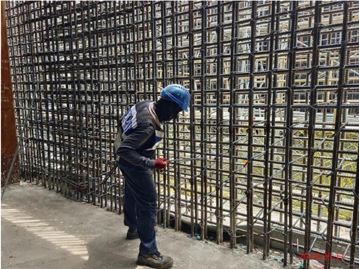
G11_出入口夾層牆鋼筋綁紮
