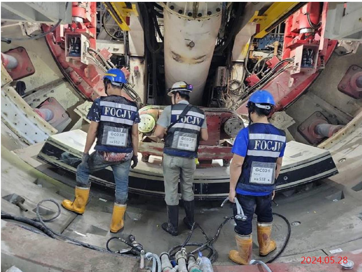
潛盾隧道_中圓上行線掘進(G10~G09)
