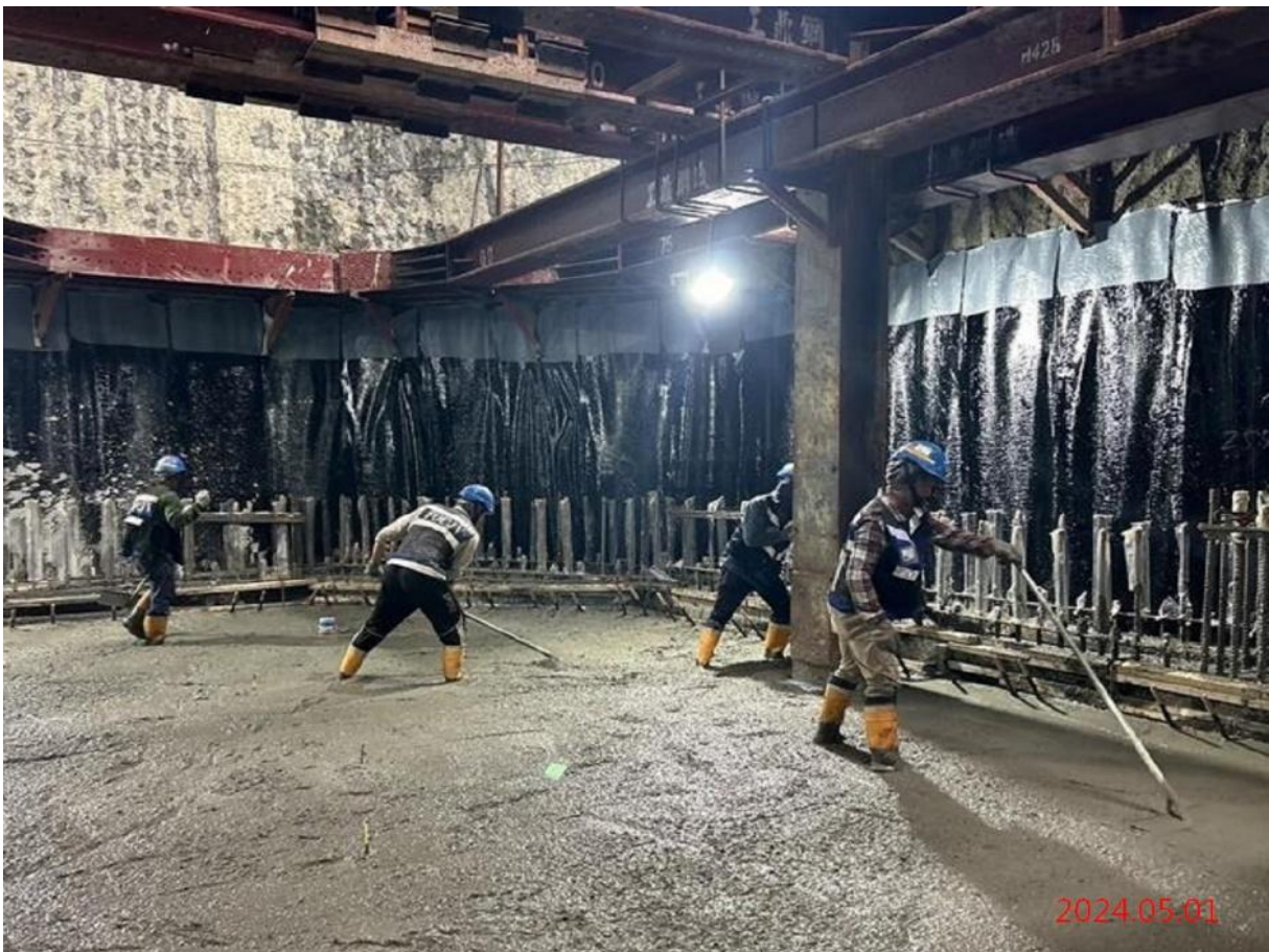
G09_B4F 版混凝土澆置
