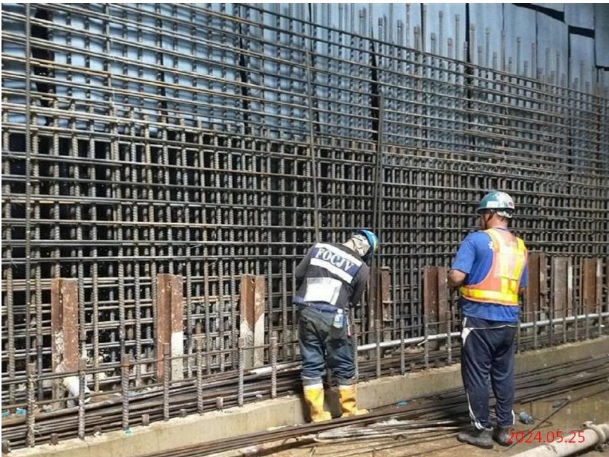
G12_站體月台層側牆鋼筋加工綁紮
