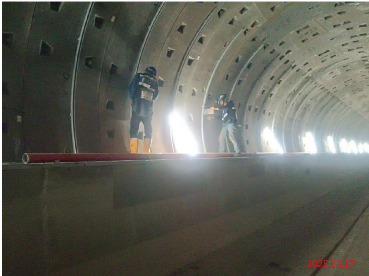
潛盾隧道_排水系統-配管施作
