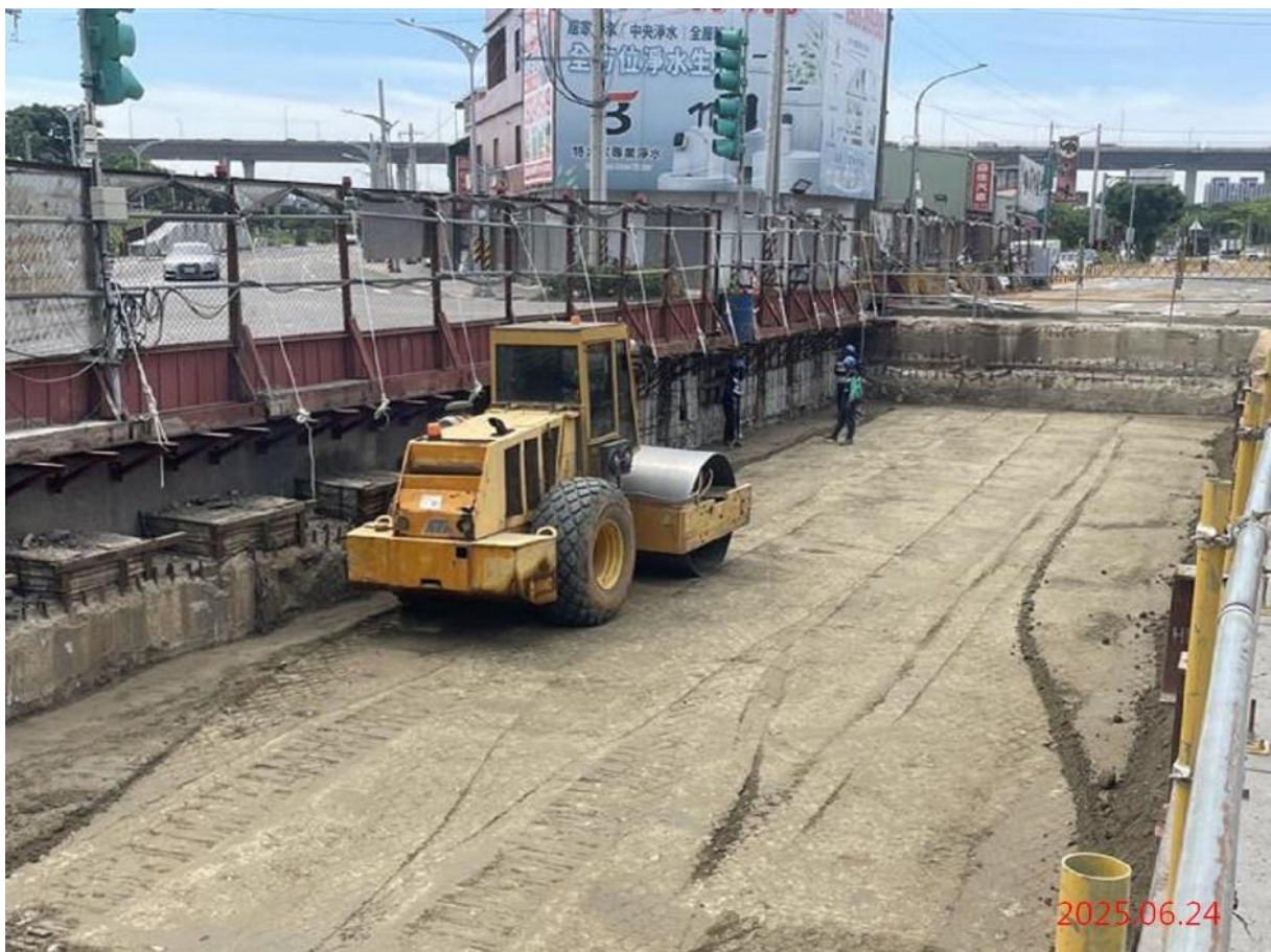
G12_站體地面層復舊回填作業
