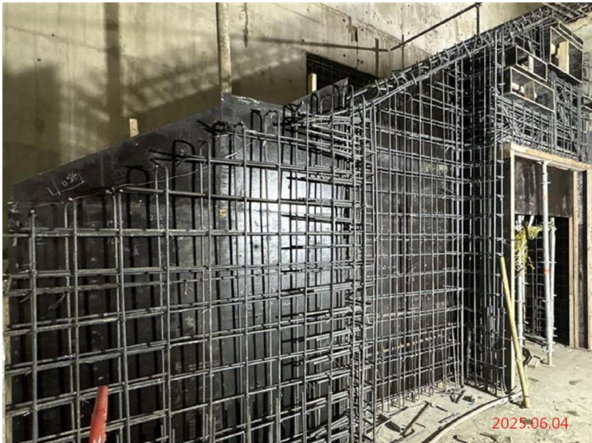
G11_出入口電扶梯斜版施作
