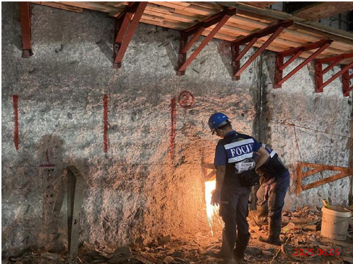
G07_結構 B5F 軌道層支撐架施作
