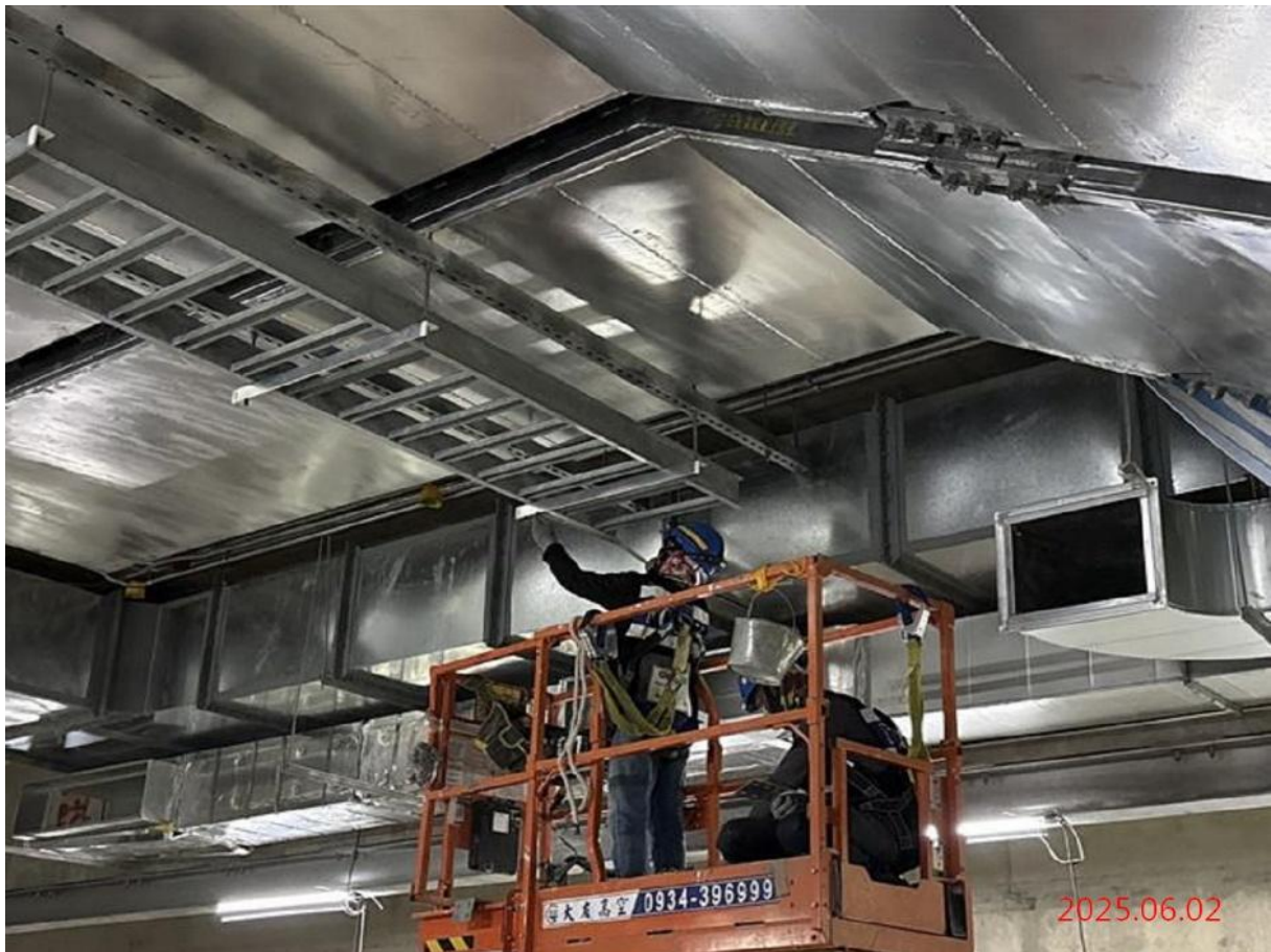
G12_B2F 公共區 電氣系統施作
