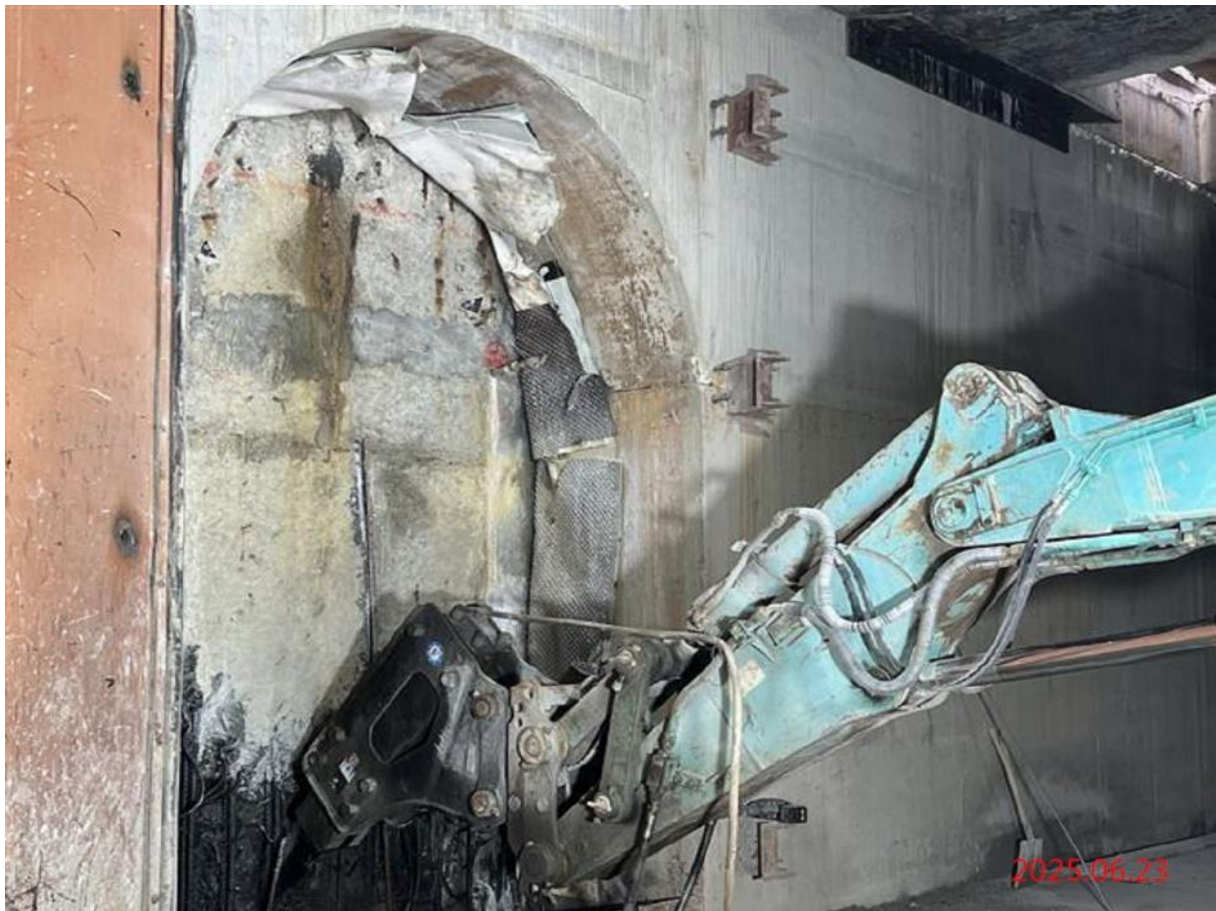
G08_站體區 B4F 連通道施作
