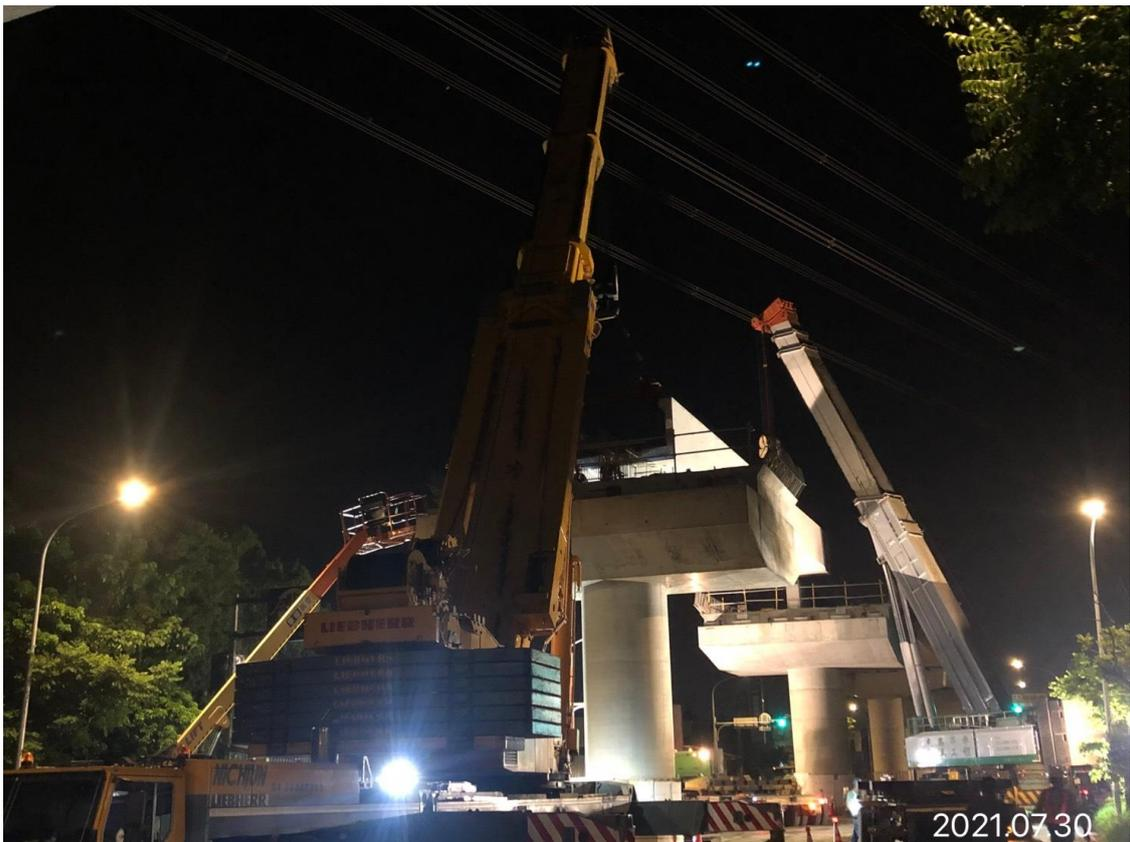
蘆竹中正北路 預鑄混凝土 U 型梁吊裝
