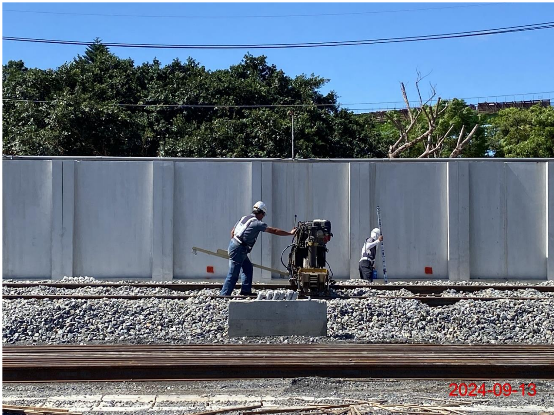
北機廠道碴鋪設
