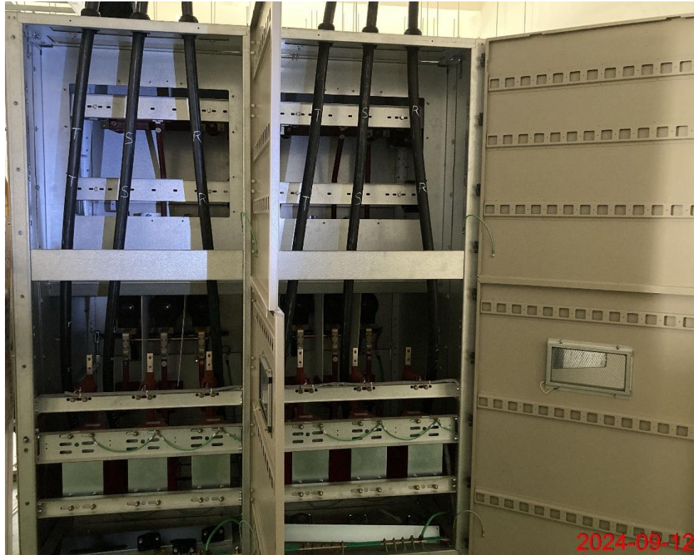
22kV 電纜佈設
