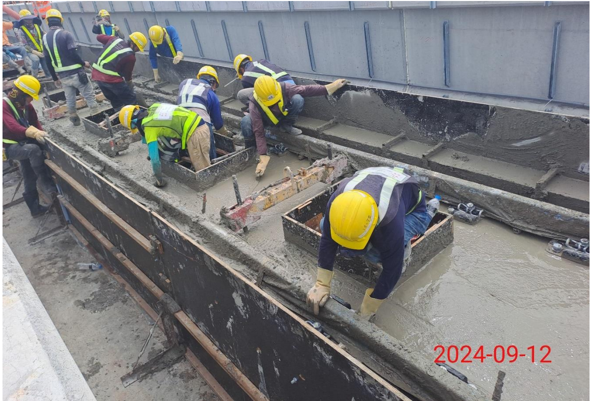
G13a-G14 站間軌道施工
