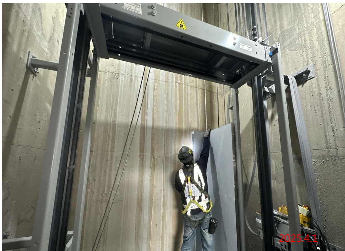
G13 站 1 號電梯車廂安裝作業
