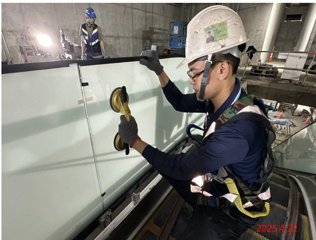
G12 站 1-2 號電扶梯扶手玻璃安裝作業
