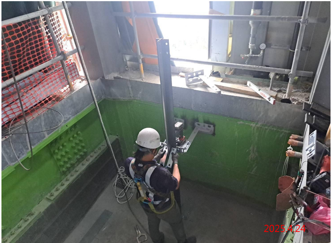
G13 站 3 號電梯導軌安裝作業
