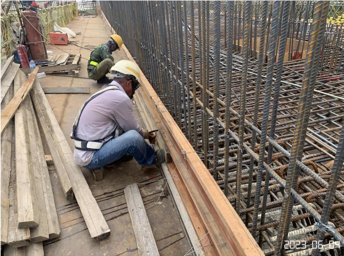
DU31-10 上行線頂版中央走道及胸牆預留鋼筋組立、頂版側模組立、洩水孔安裝
