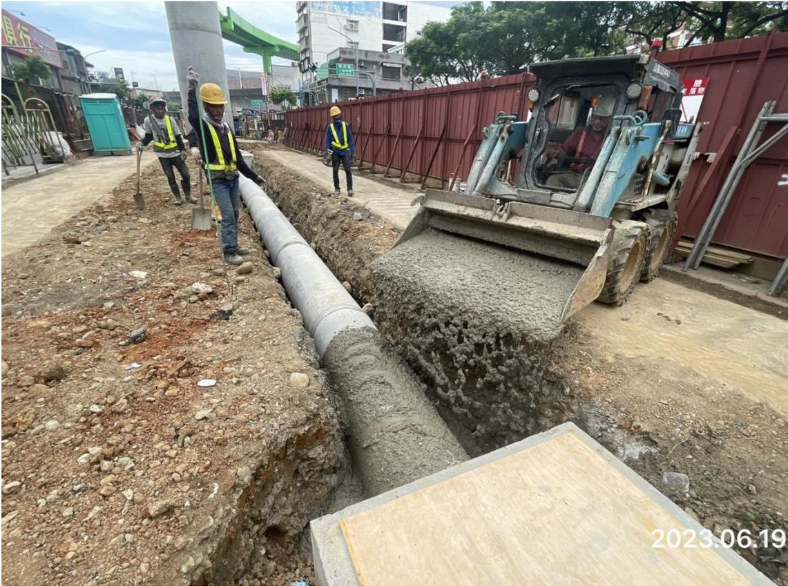
橋墩排水 P13a-P19B 集水井及串連段管涵埋設混凝土澆置
