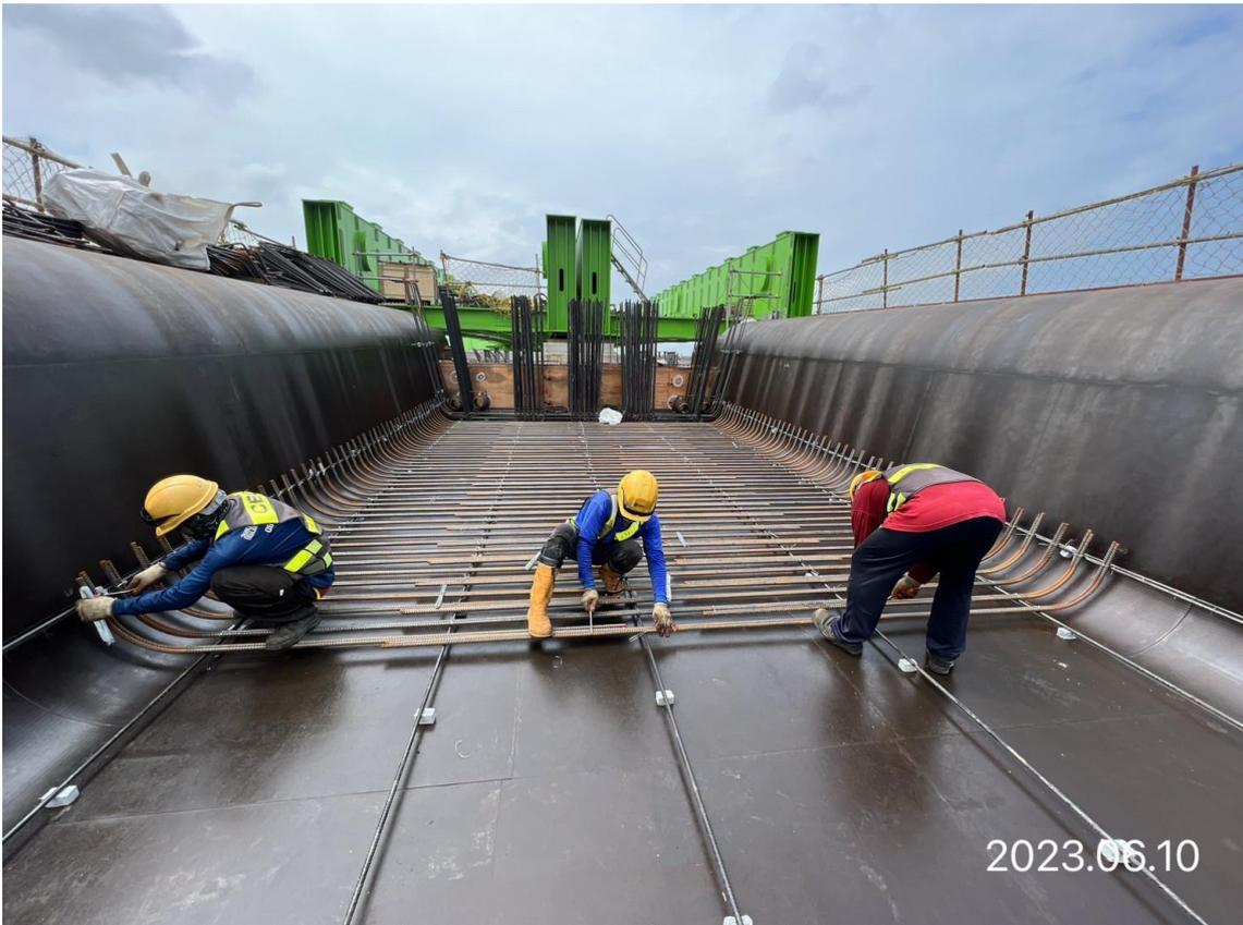
DU13a-10 場撐箱型梁端隔梁鋼筋綁紮
