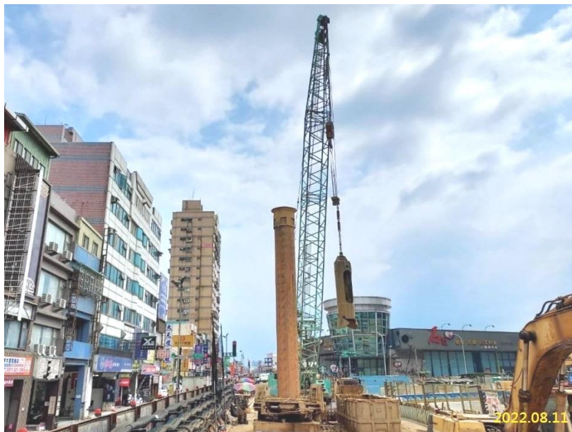
G04 站中間柱施作
