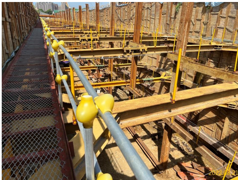
南出土段支撐系統施作
