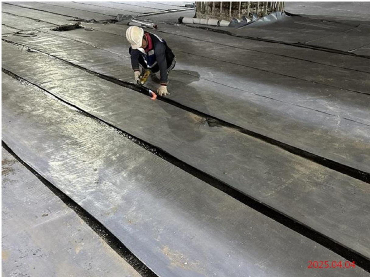
G07_結構 B5F 防水膜施作
