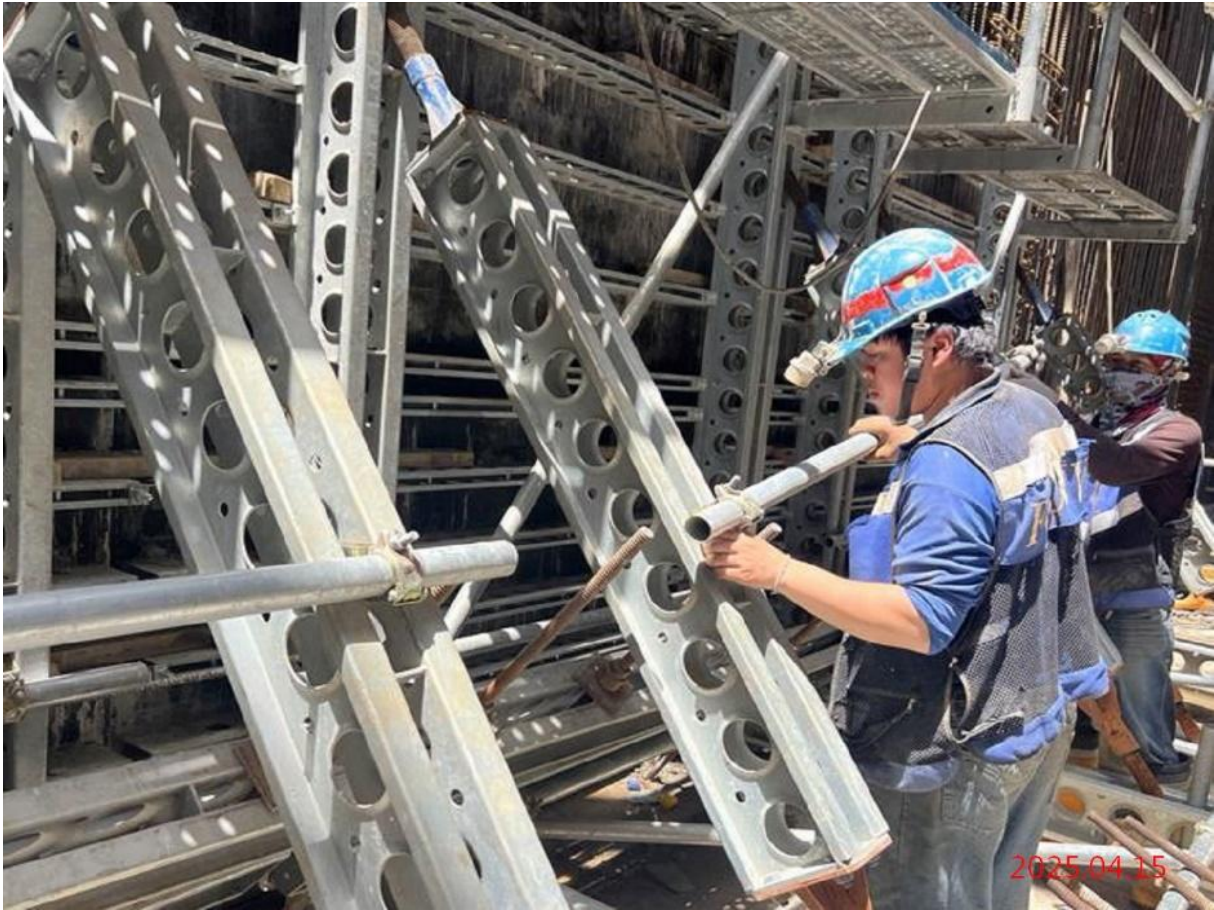
G08_土開區 B6F 外牆模板施作
