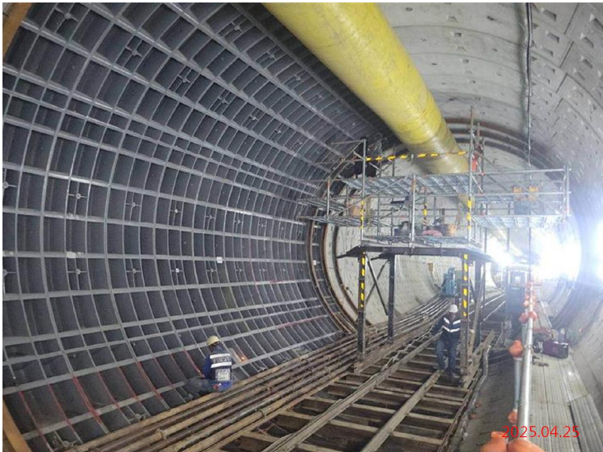
潛盾隧道_下行線 G08 銜接段環撐施作
