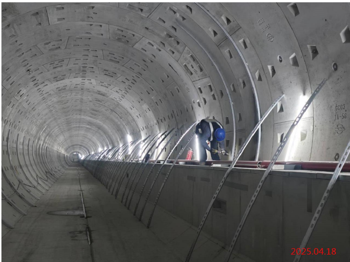
潛盾隧道_G11~G12 下行線滾邊槽鋼安裝
