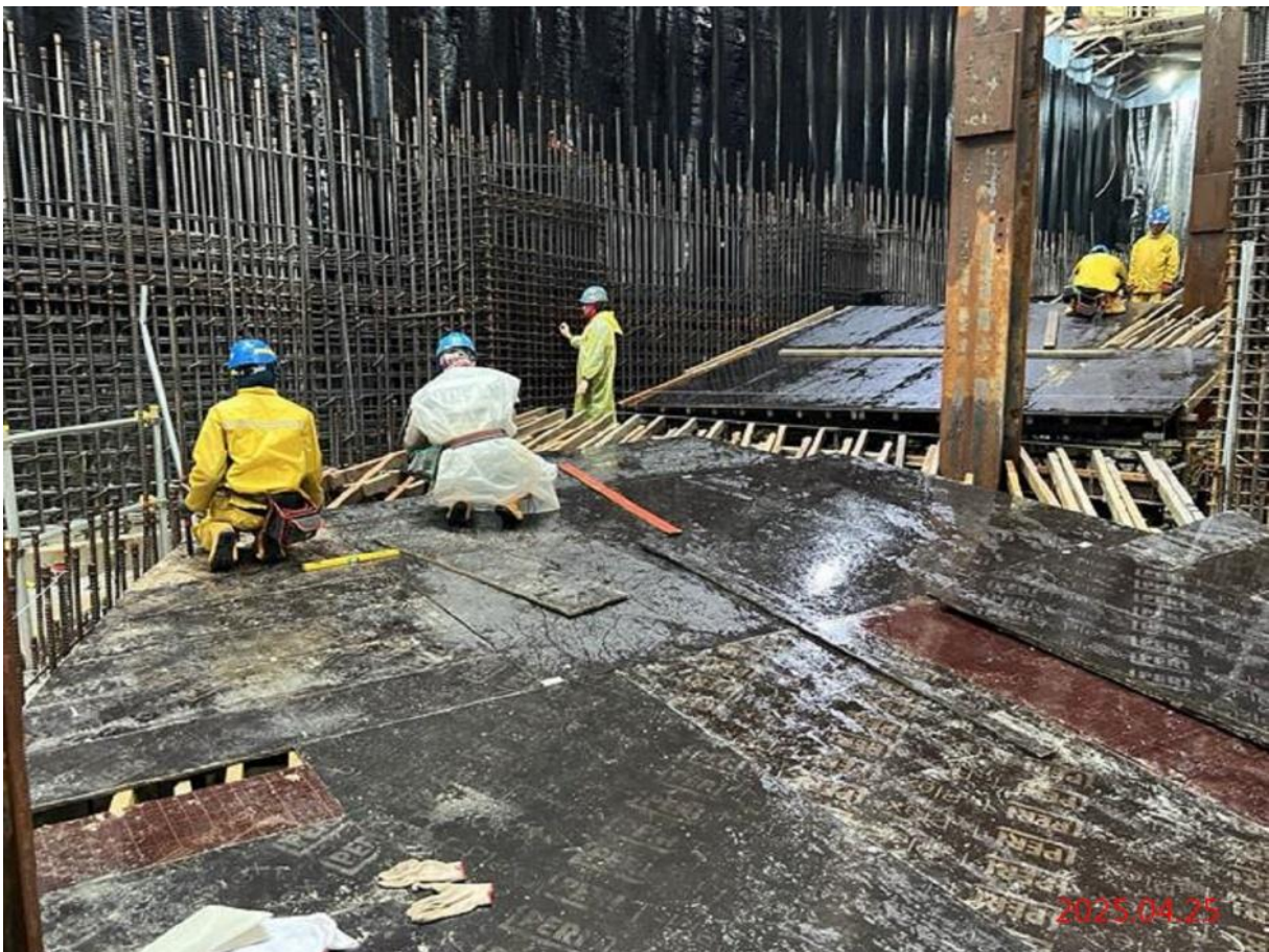
G08_土開區 B6F 車道重架模板施作
