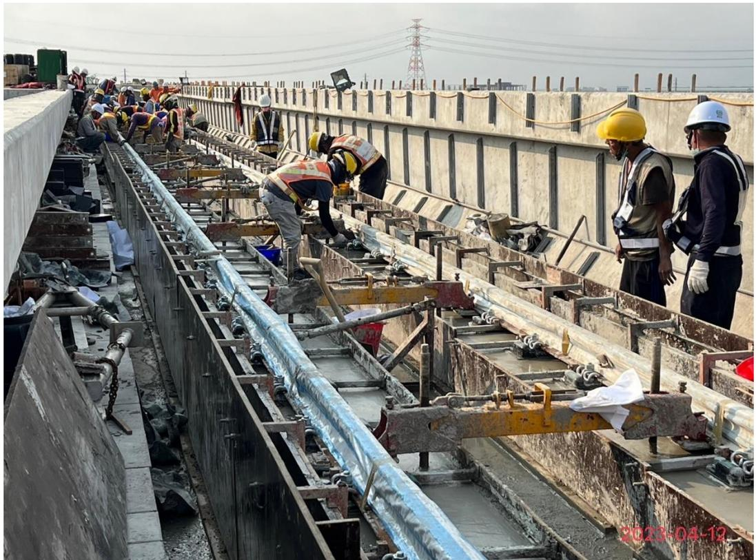
G13~G13a 上行線道床混凝土澆置(U17-U28)
