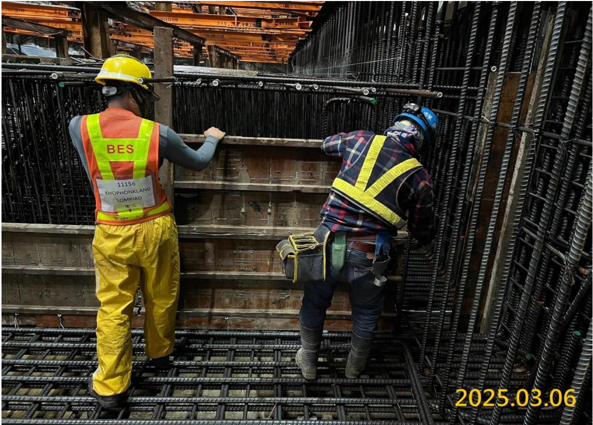
G05 站結構底板施作
