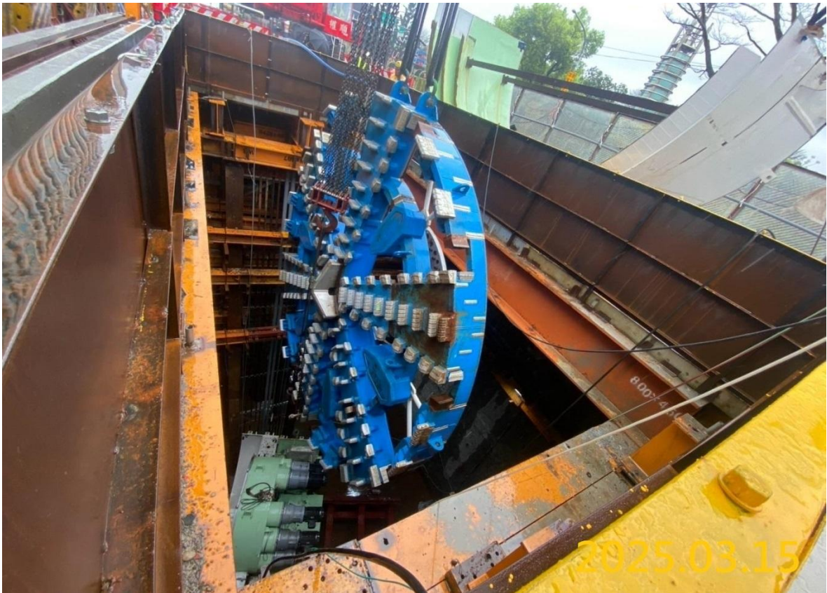
G06 站潛盾隧道發進前置作業-潛盾機組裝
