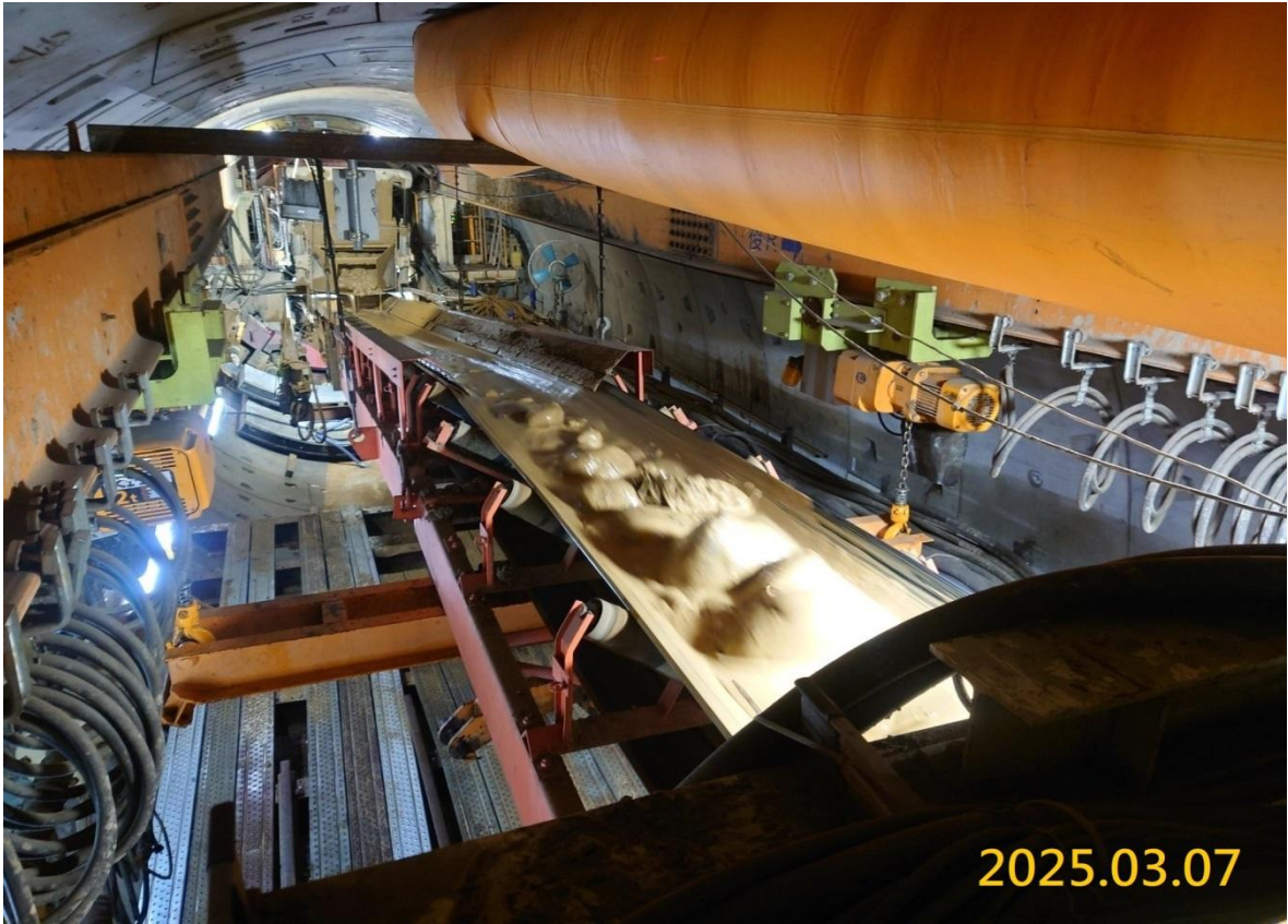
G03 站潛盾隧道掘進施作
