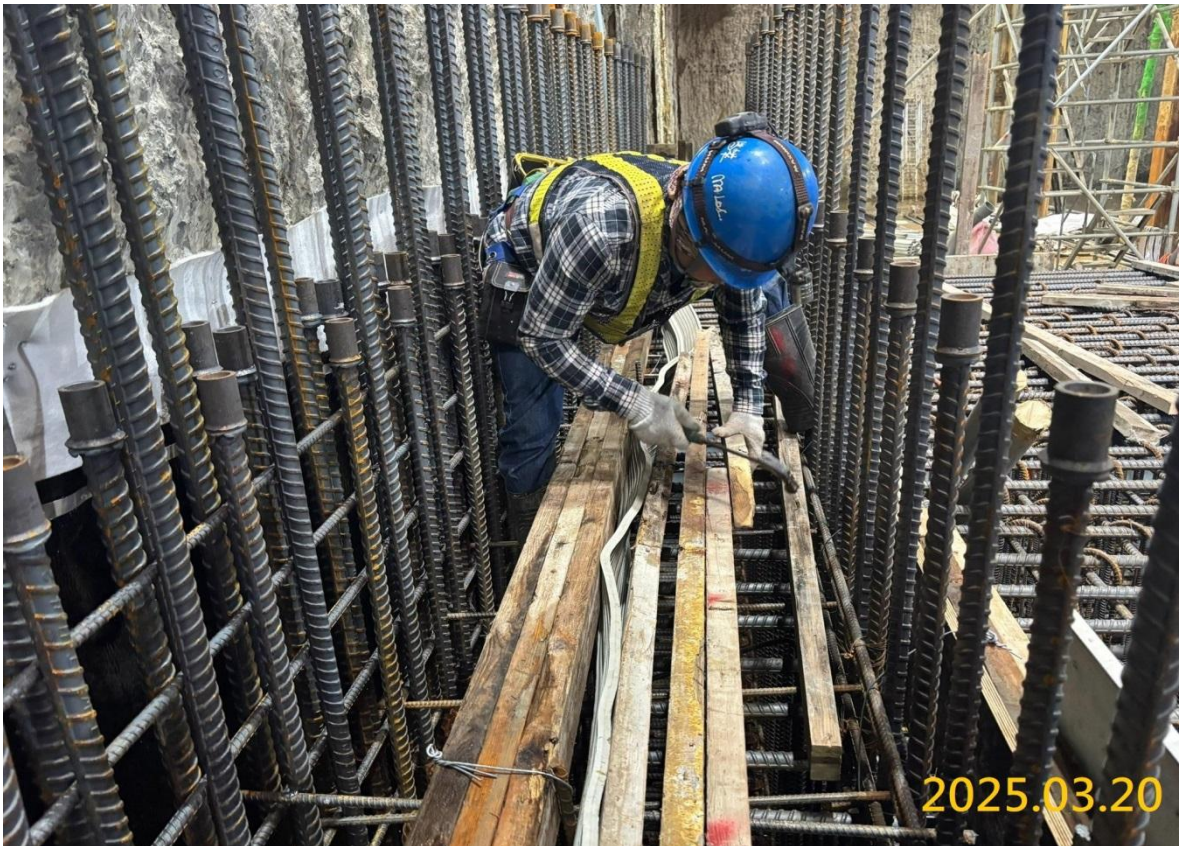
VS4 通風豎井結構底版施作
