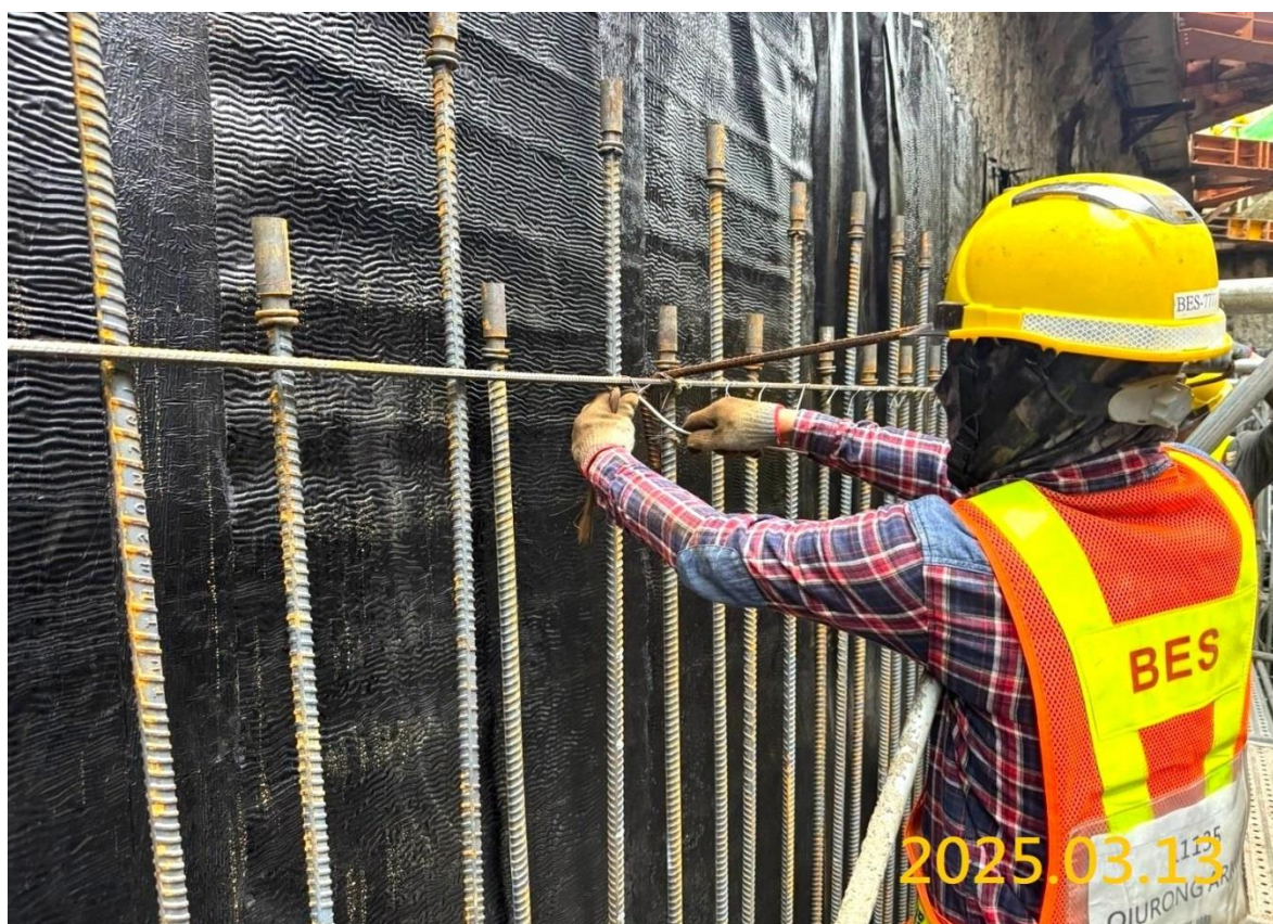
G03 緊急出入口 B2F 結構牆施作
