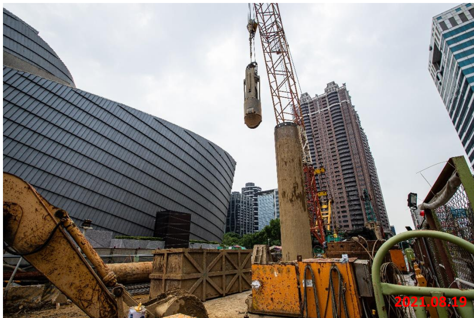
G11 站_中間柱施作
