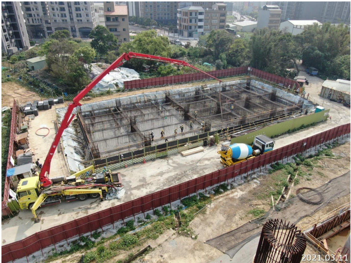
八德建德路 G02 車站出入口筏基混凝土澆置
