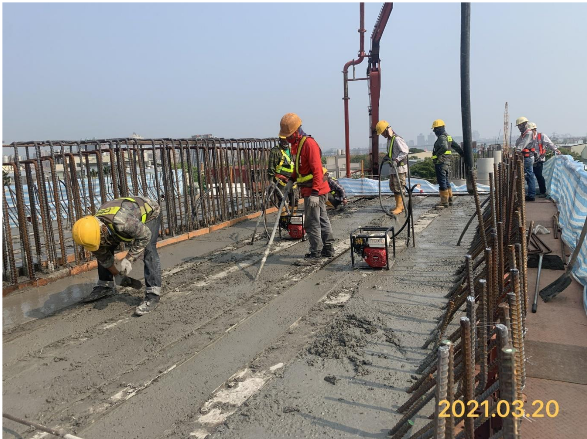
蘆竹南崁路二段 帽梁混凝土澆置
