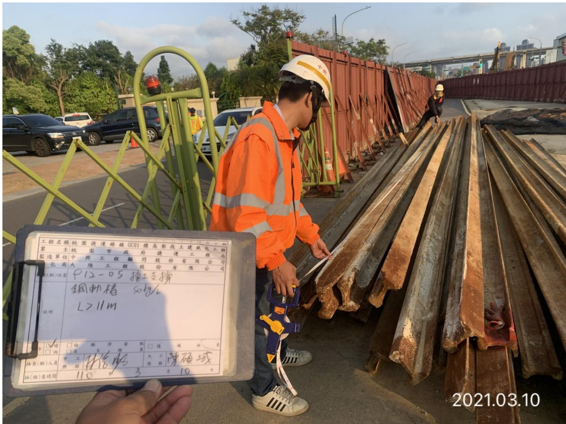
蘆竹中正北路 樁帽鋼軌樁查驗
