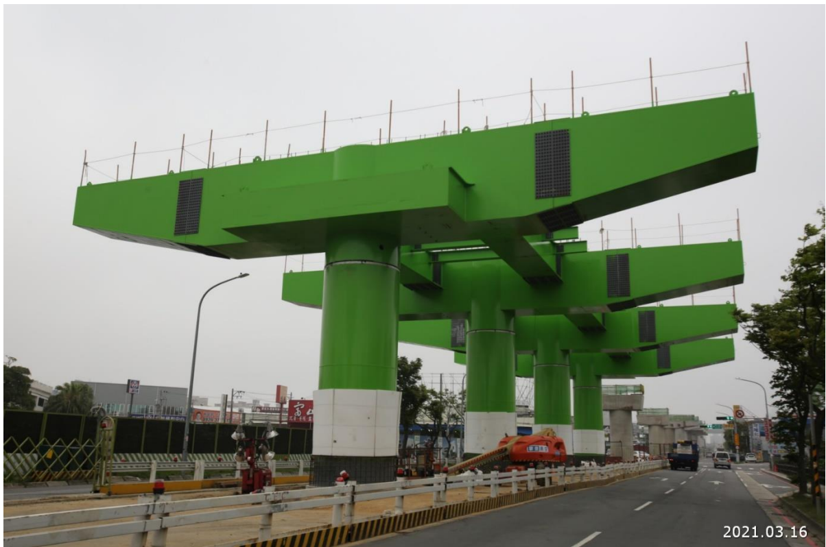
蘆竹中正北路 G13 車站鋼帽梁及軌道梁施作情形
