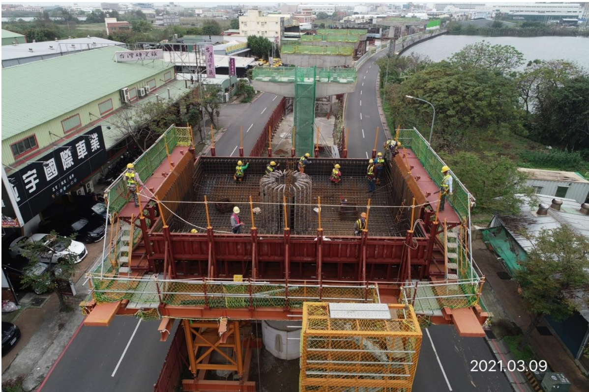
蘆竹中正北路 帽梁施作情形
