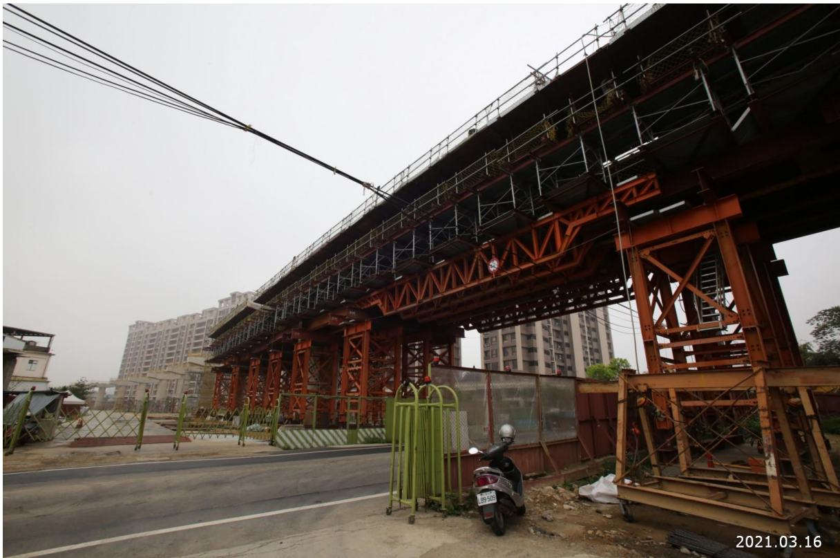
八德新闢道路 場鑄箱型梁橋面版施作情形
