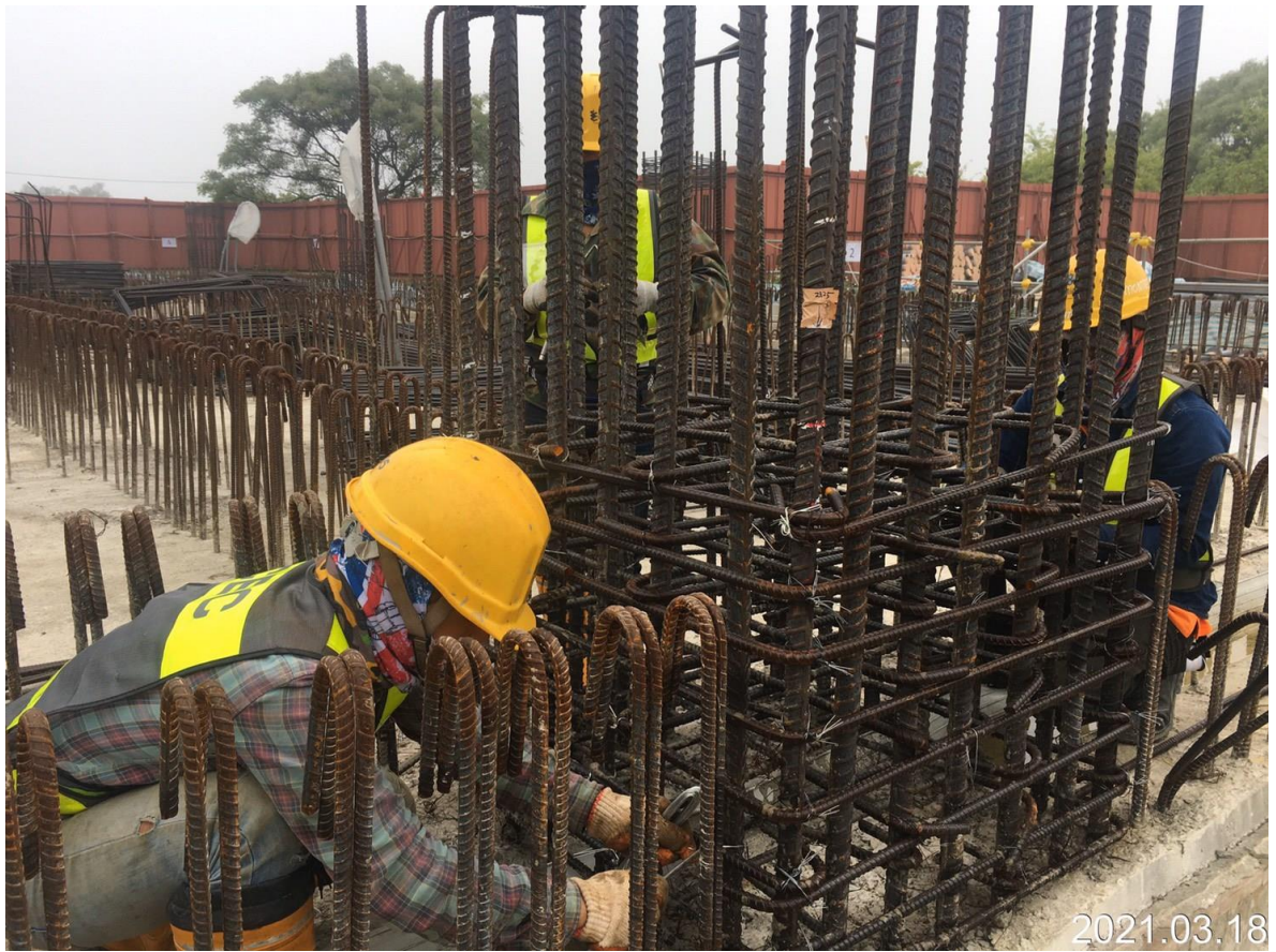
大園坑菓路 G32 車站筏基鋼筋綁紮
