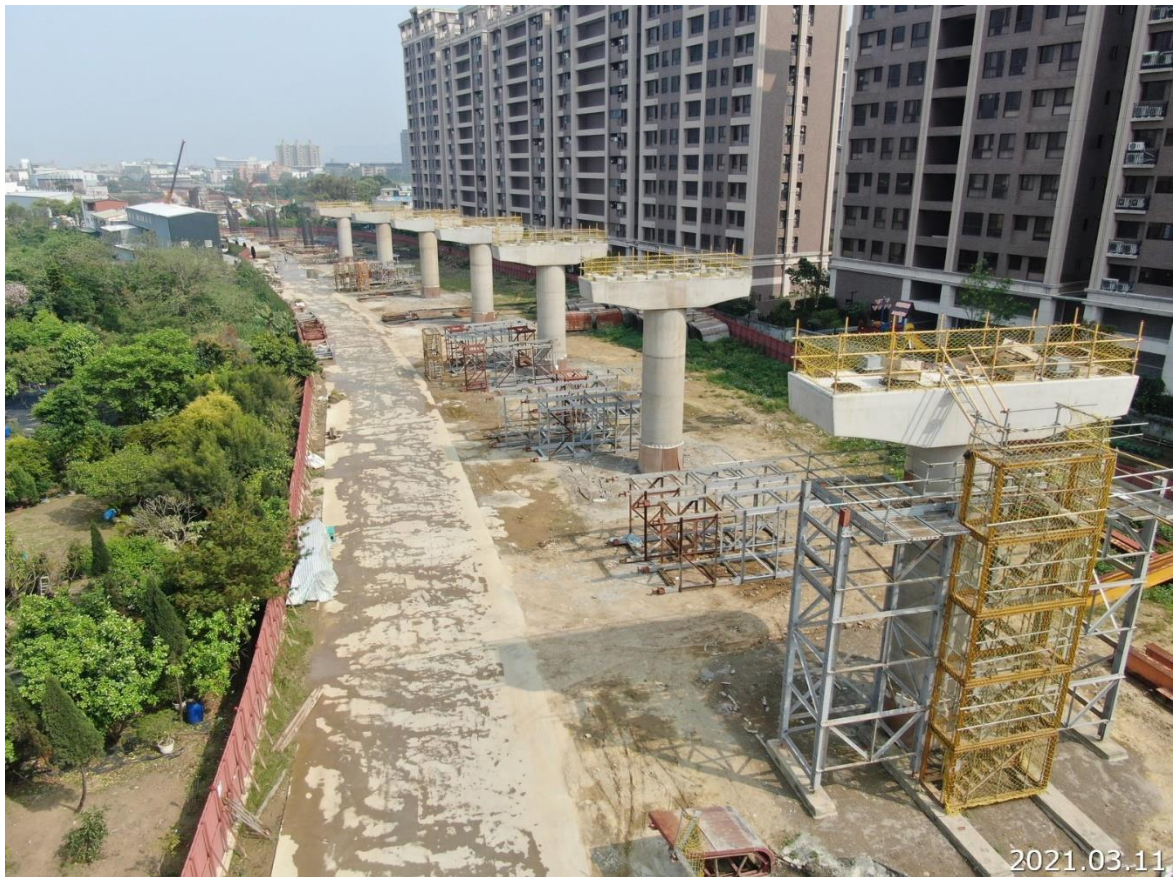
八德新闢道路 墩柱施作情形
