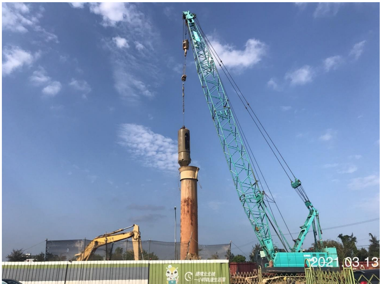
蘆竹南崙路二段 基樁鑽掘
