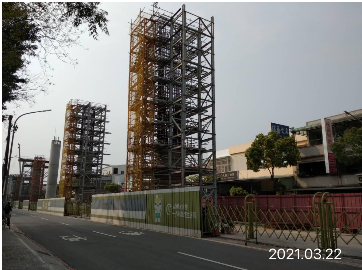
蘆竹南崁路二段 墩柱模板組立
