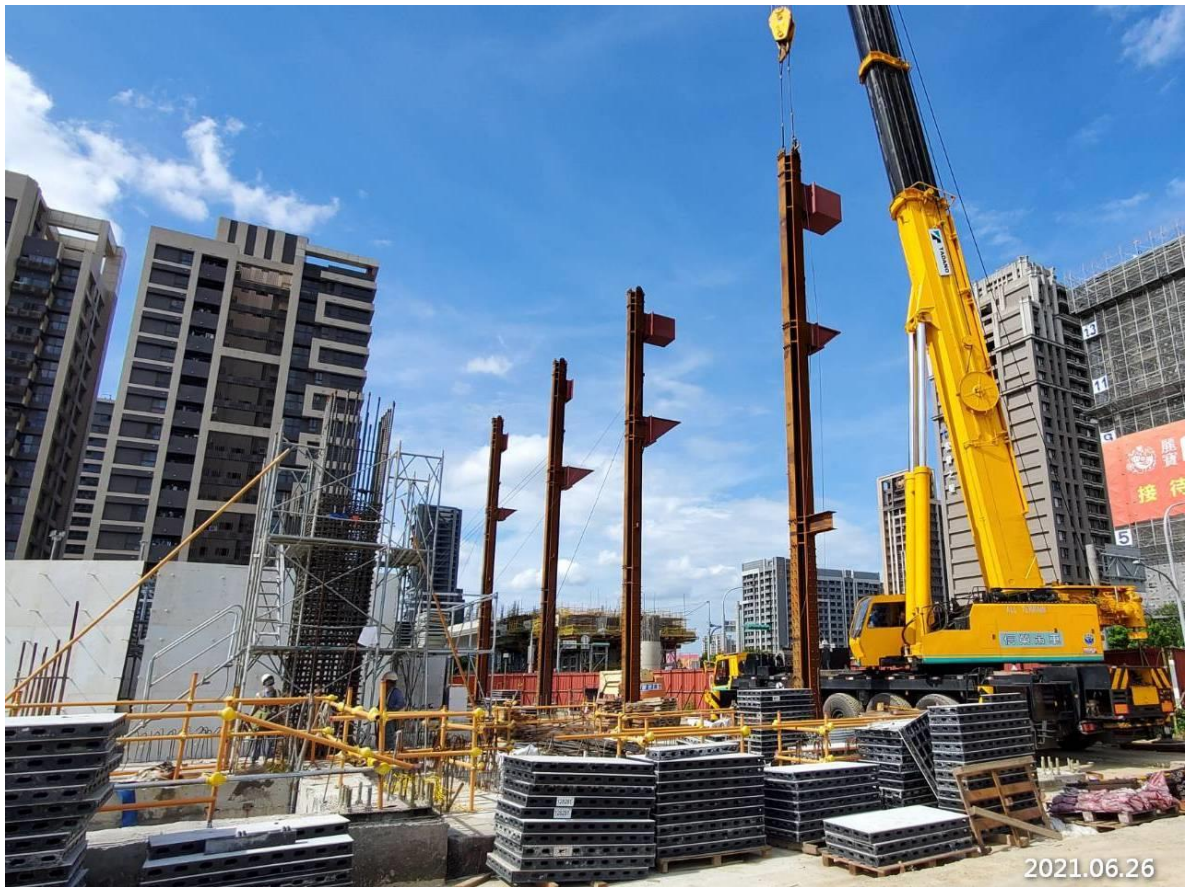
八德建德路 G01 車站出入口連通道鋼柱吊裝
