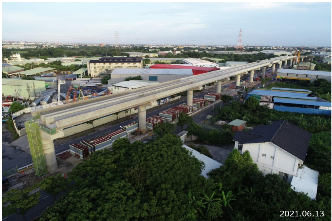
蘆竹中正北路 部分預鑄混凝土 U 型梁吊裝完成
