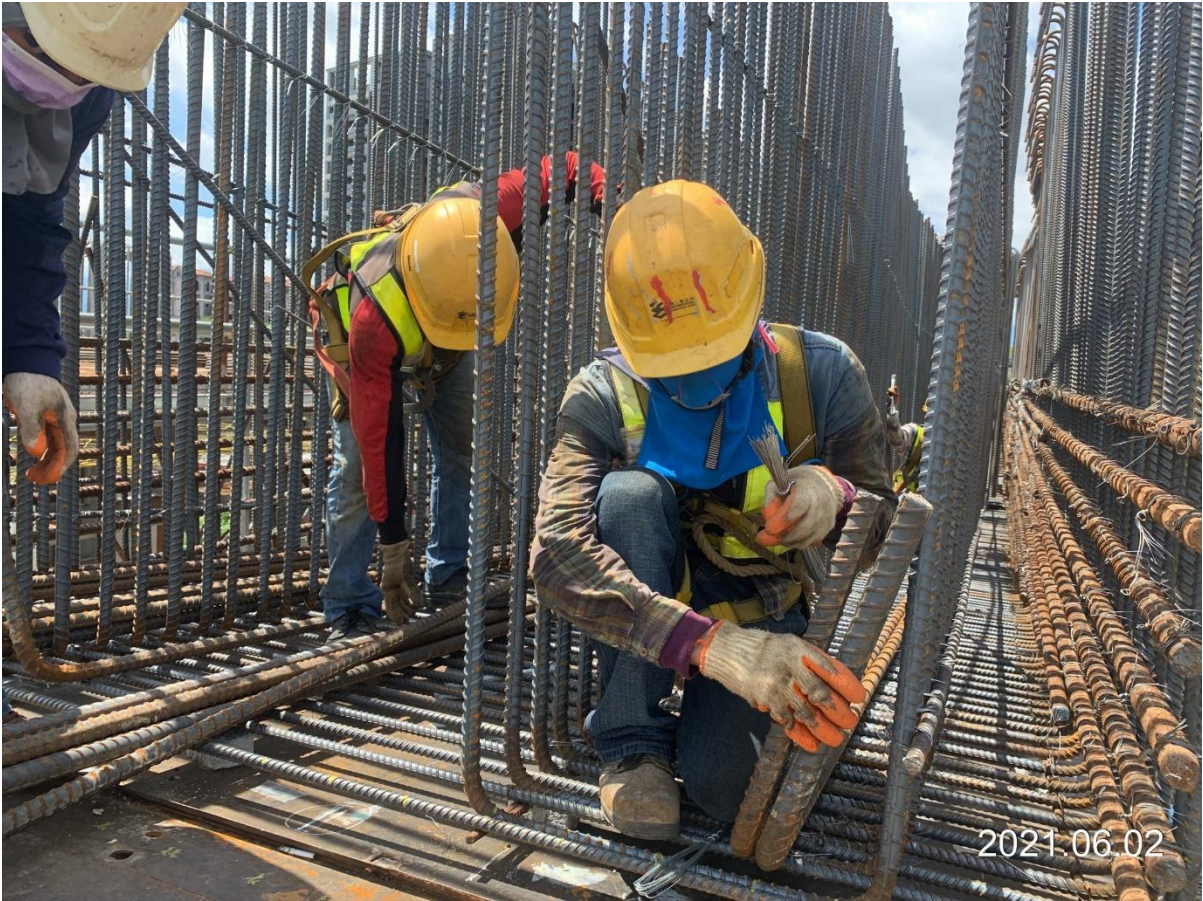
八德新關道路 帽梁鋼筋綁紮
