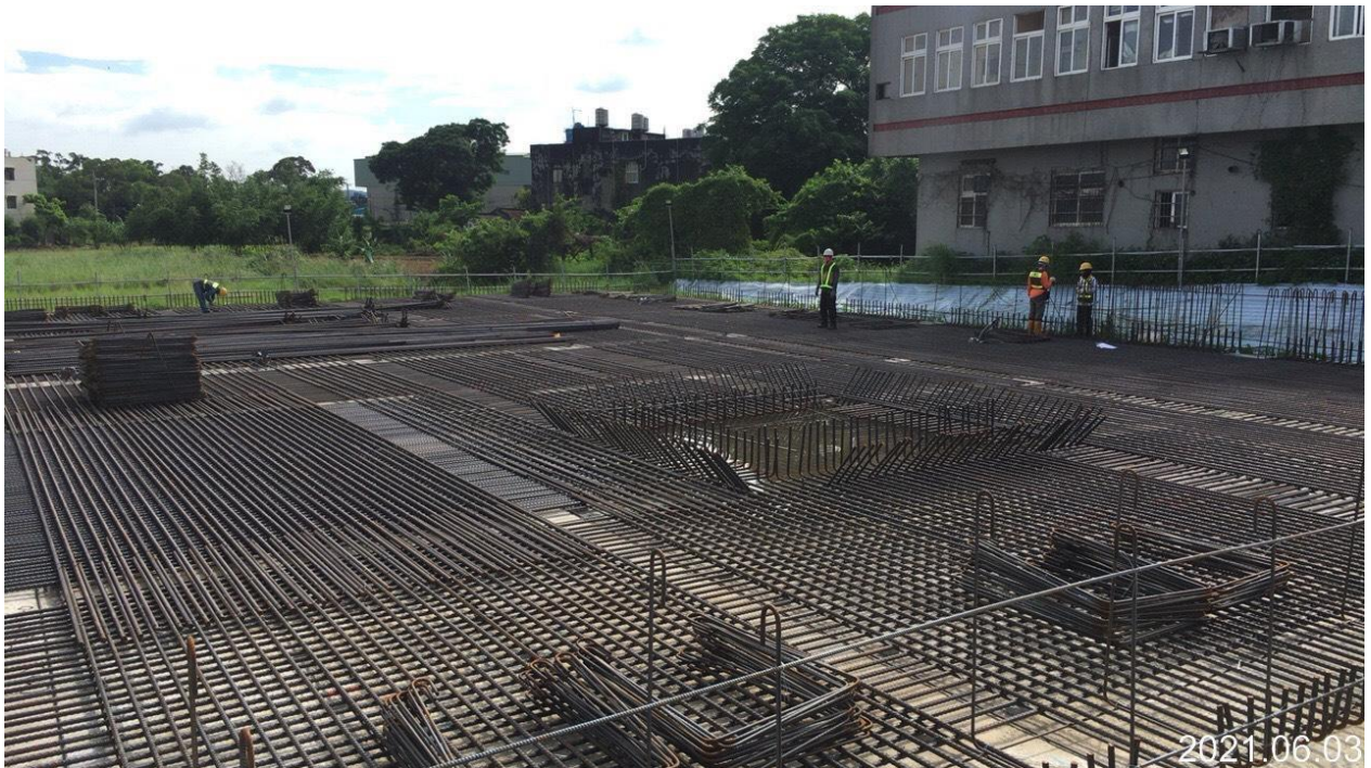
蘆竹南崁路二段 G14 車站出入口筏基基礎鋼筋綁紮
