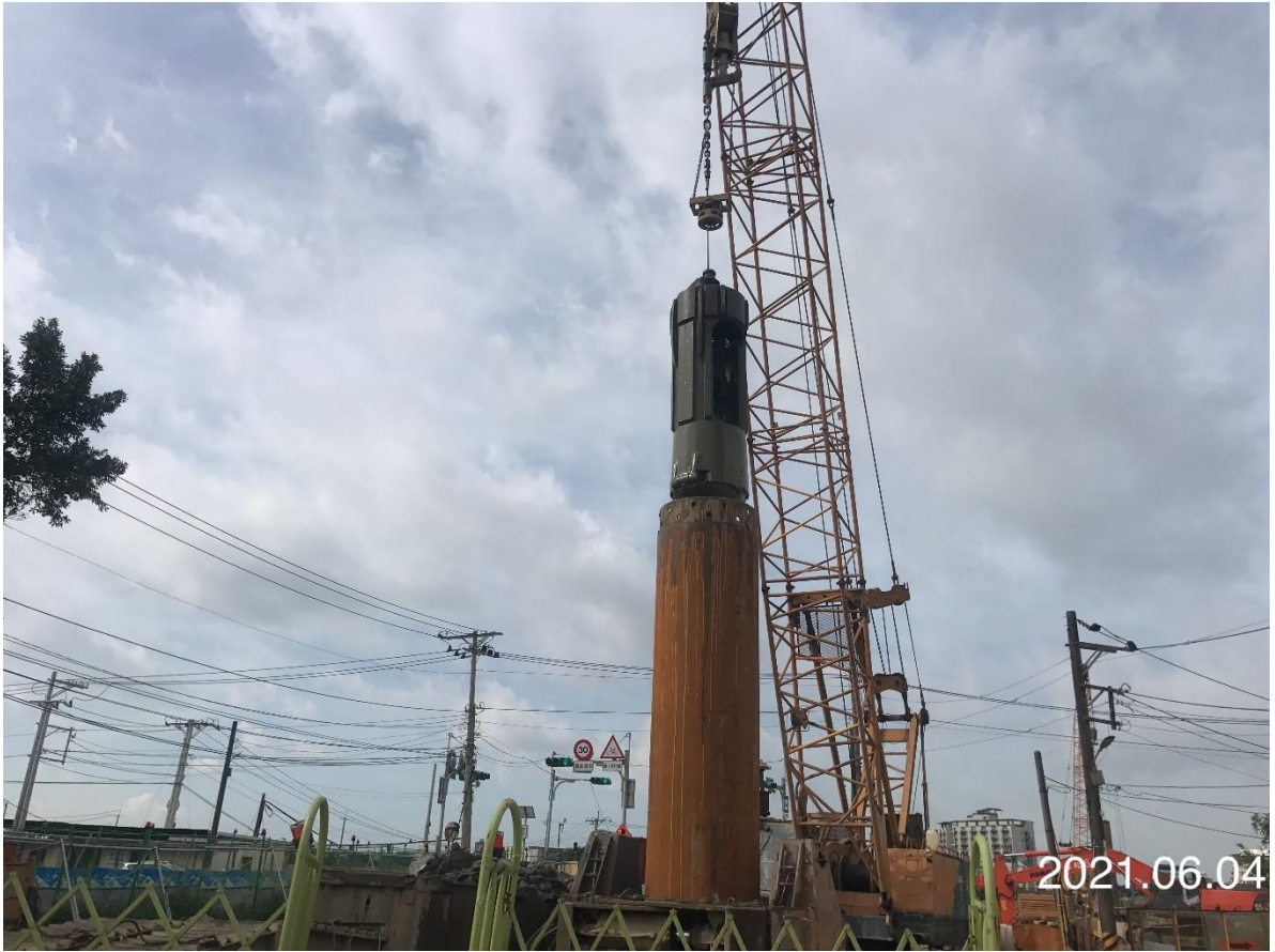
大園坑菓路 基樁鑽掘
