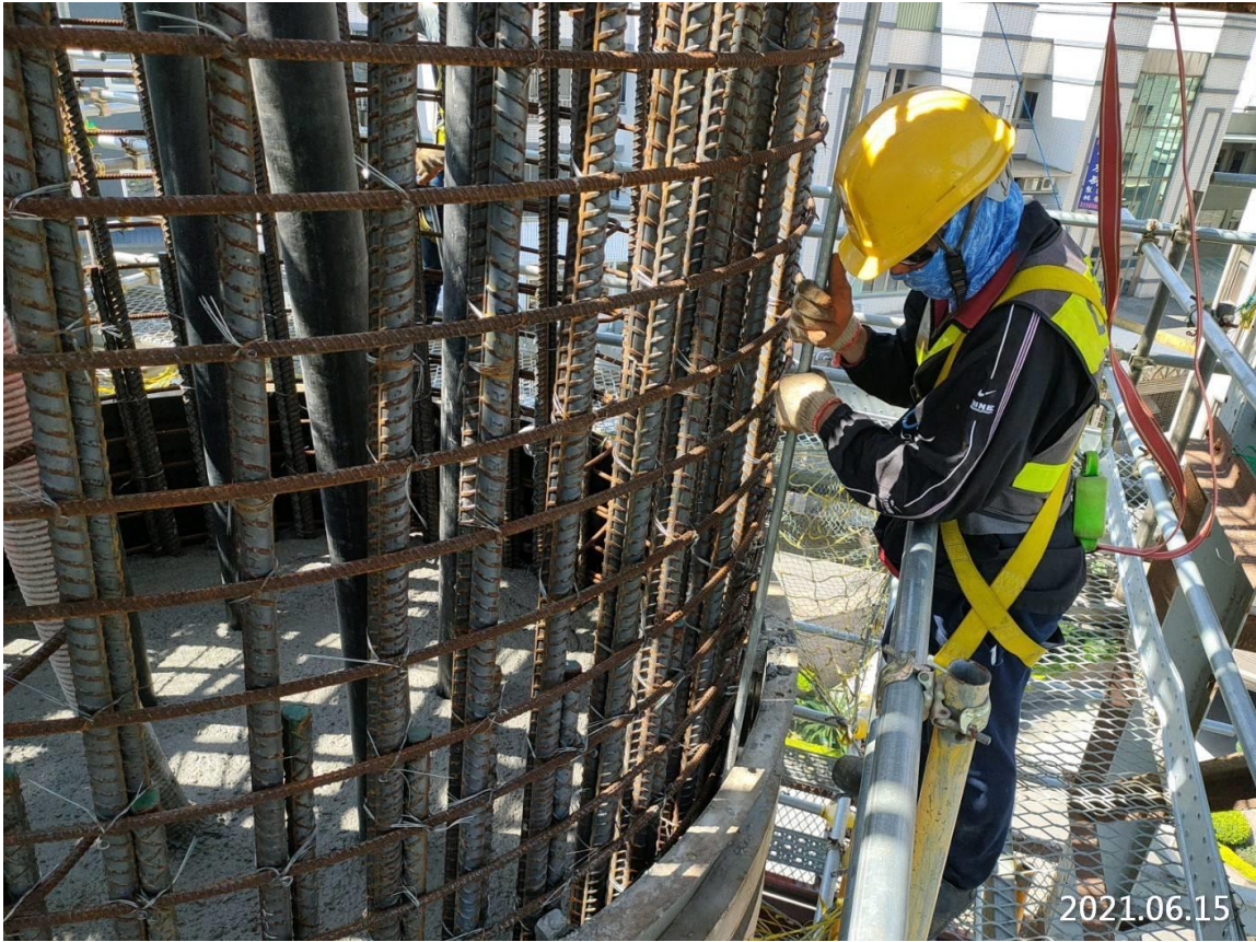
蘆竹南崁路二段 墩柱混凝土澆置搗實
