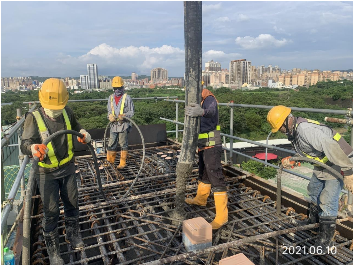
蘆竹中正北路 帽梁混凝土澆置
