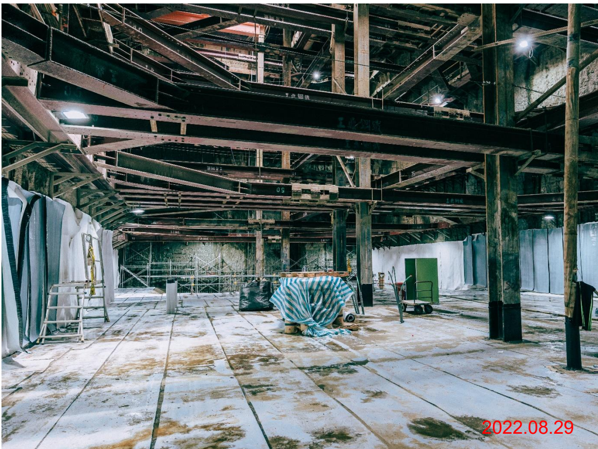
G11 站_站體結構底版防水膜施作
