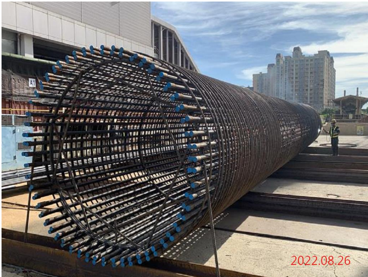
G07 站_基樁鋼筋籠組立
