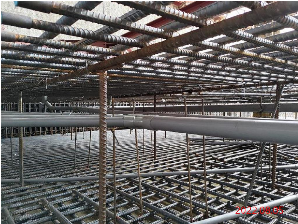
G12 站_結構體水環預埋管配管
