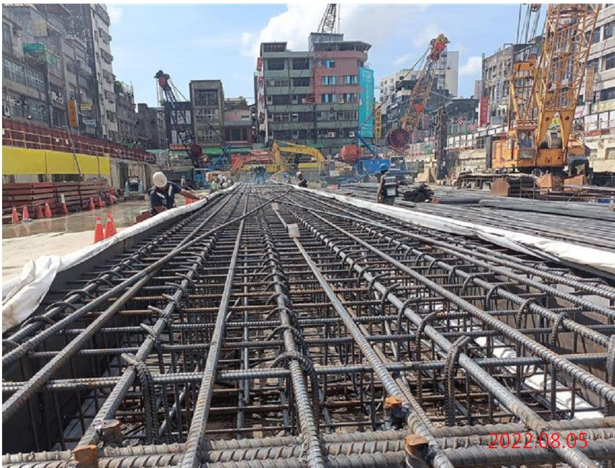
G08 站_連續壁鋼筋籠組立
