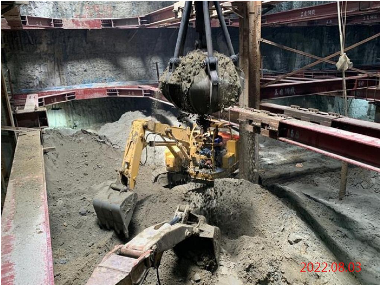
G11 站_站體開挖
