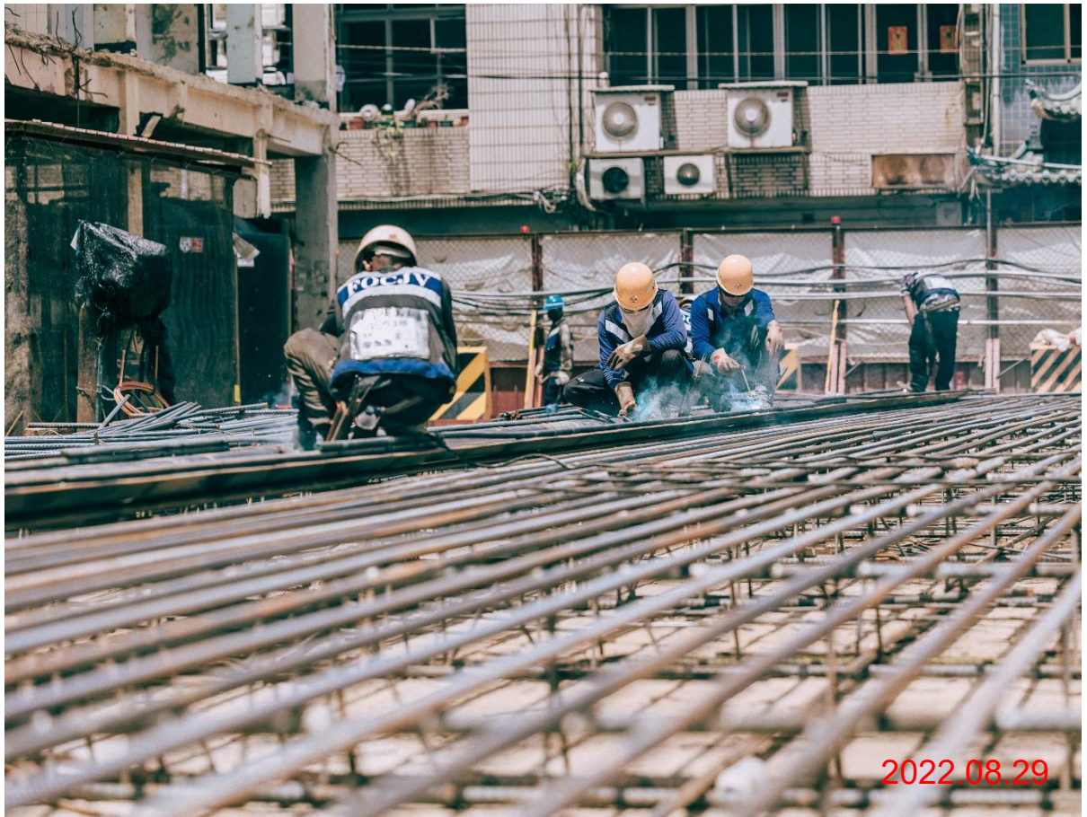
G09 站_連續壁鋼筋籠組立
