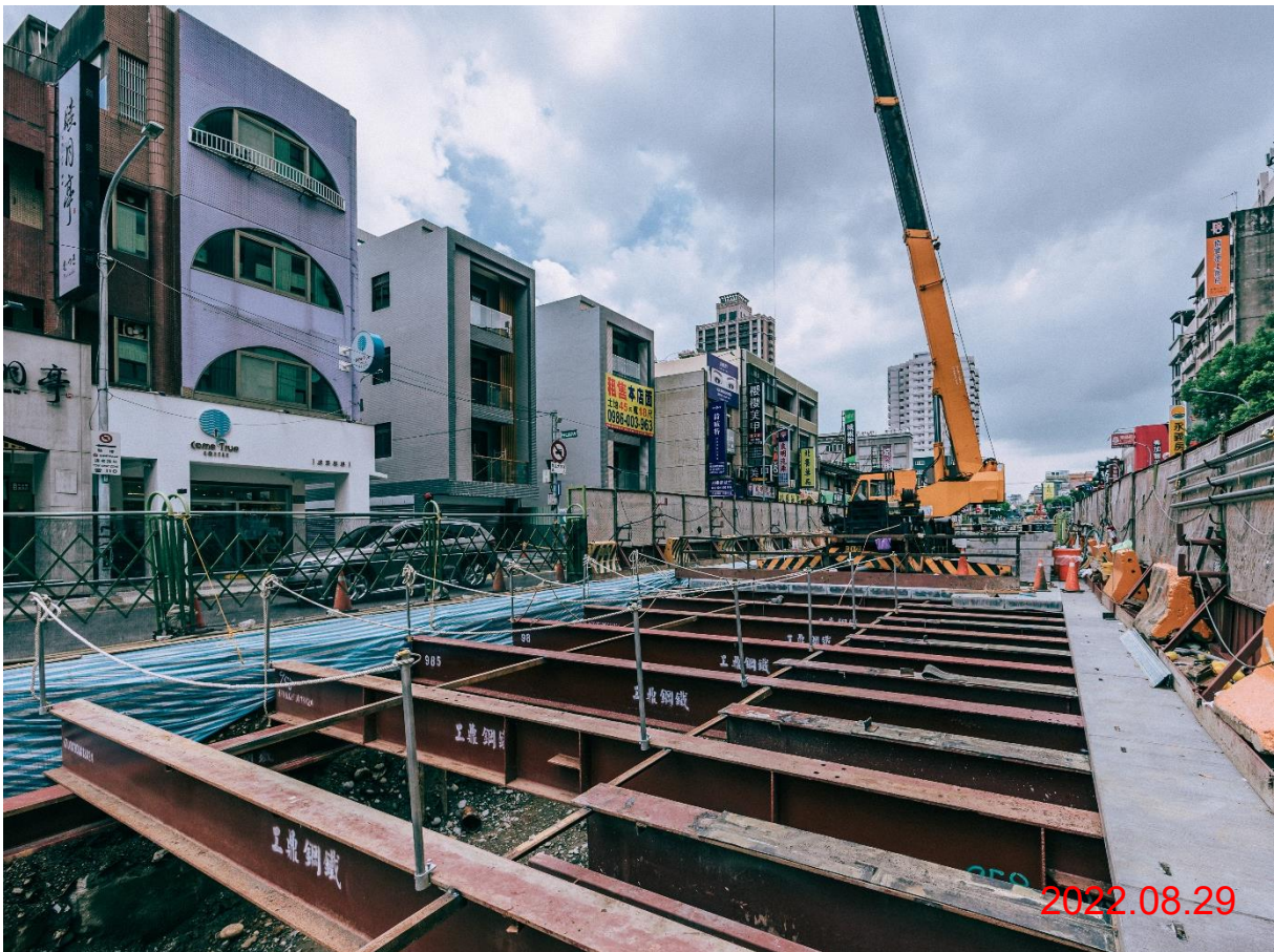
G10 站_覆工系統施作
