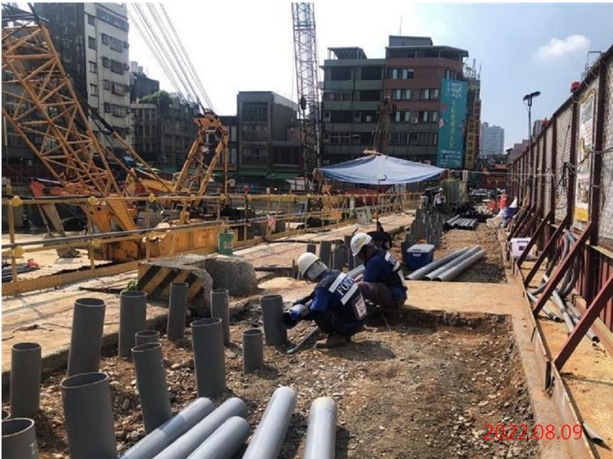
潛盾隧道_G08 站銜接段地改施作
