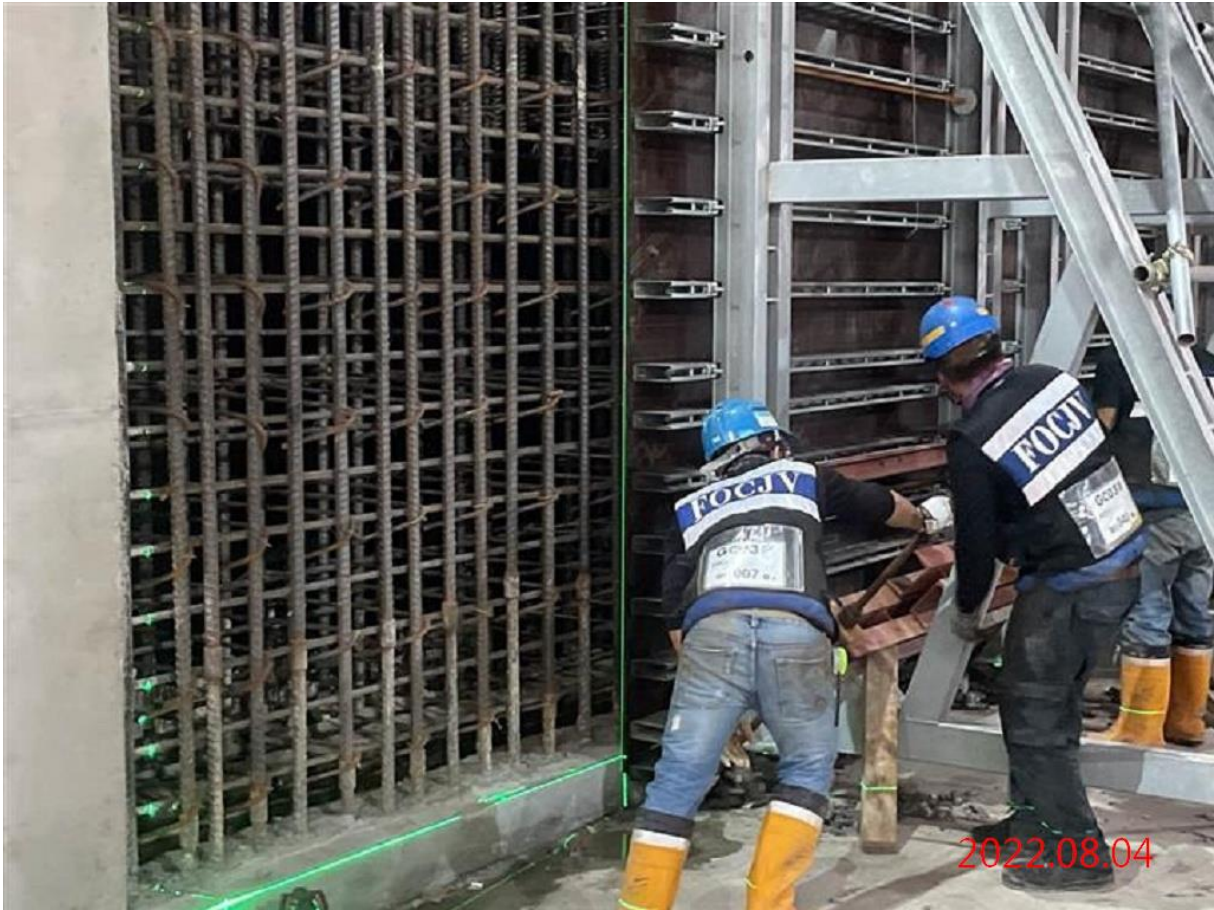
G12 站_站體模板組立
