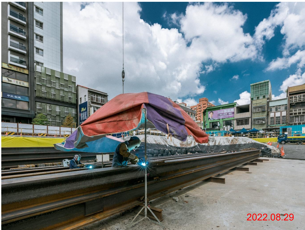
G08 站_中間柱材料加工
