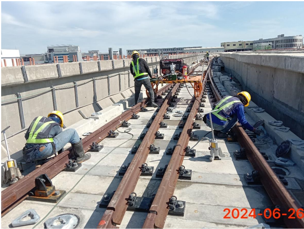
G13a-G14 站間軌道施工
