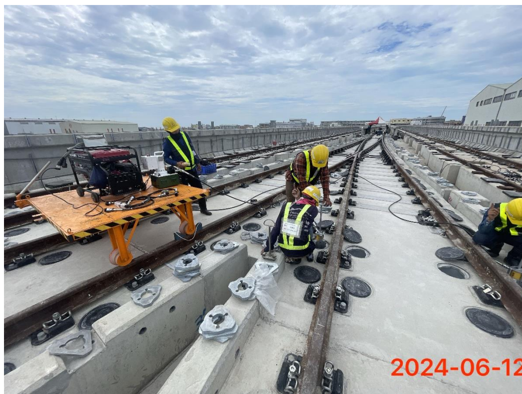
G13a-G14 站間軌道施工
