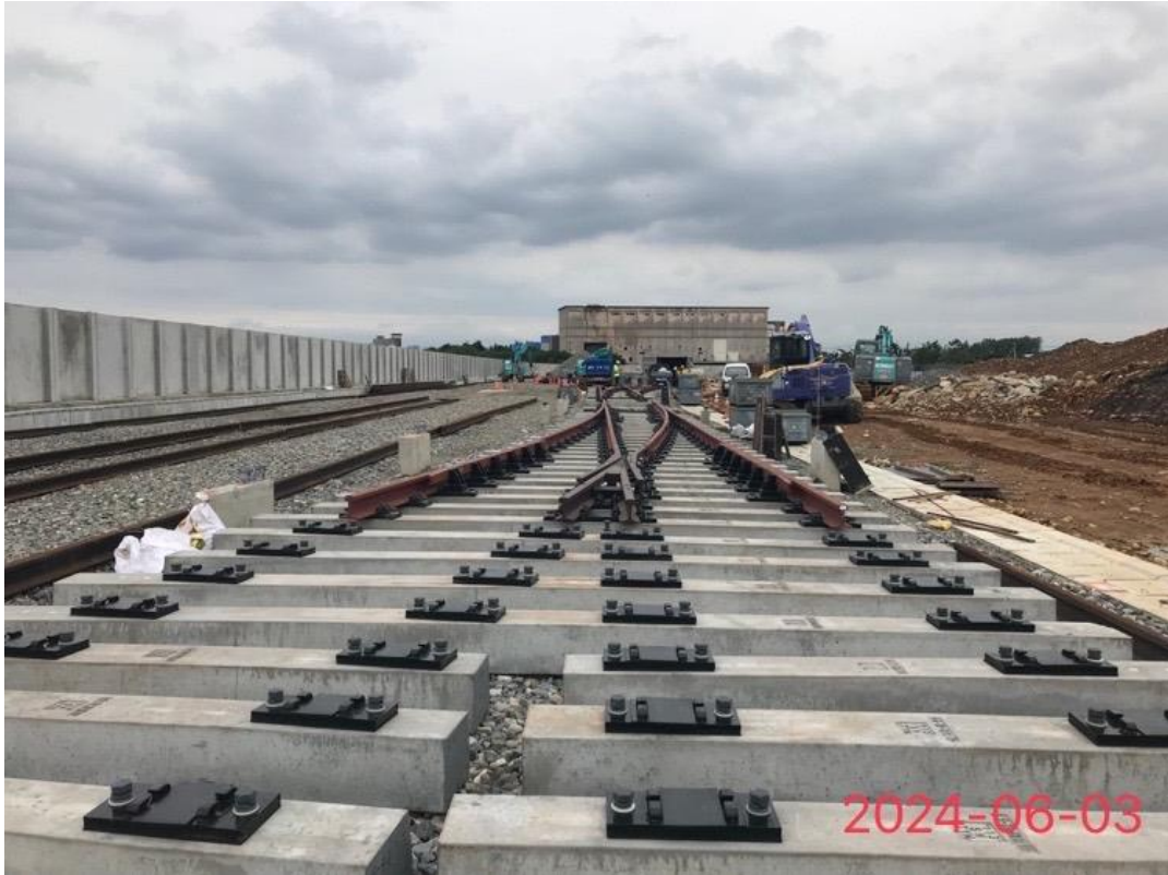
北機廠軌道施工
