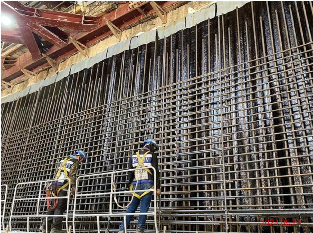
G11 站\_ 出入口穿堂側牆鋼筋綁紮
