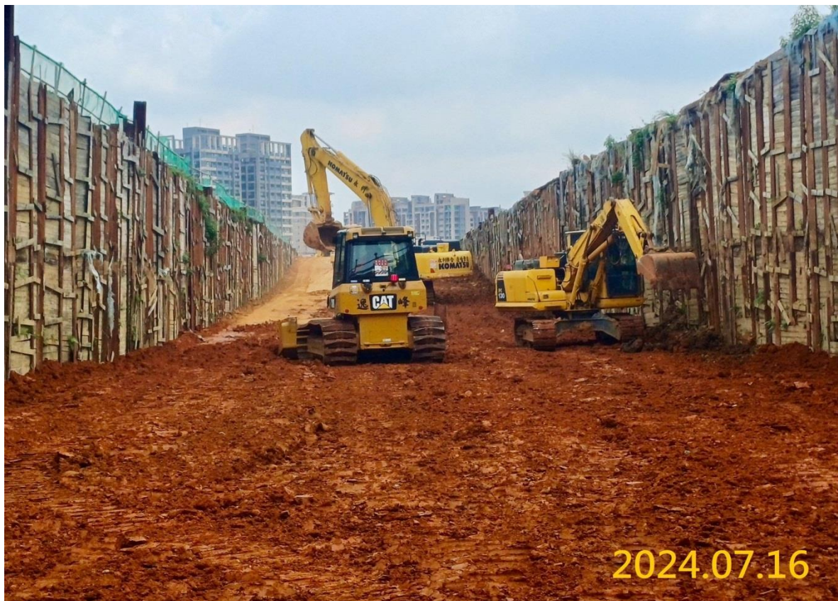
南出土段結構回填
