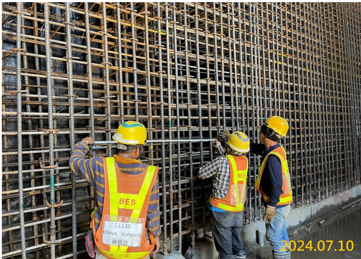
G03 站結構牆施作
