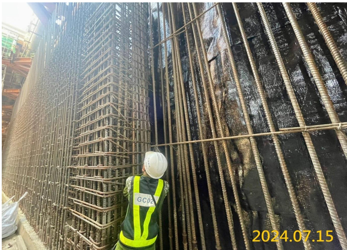
VS5 通風豎井結構牆(柱)鋼筋綁紮
