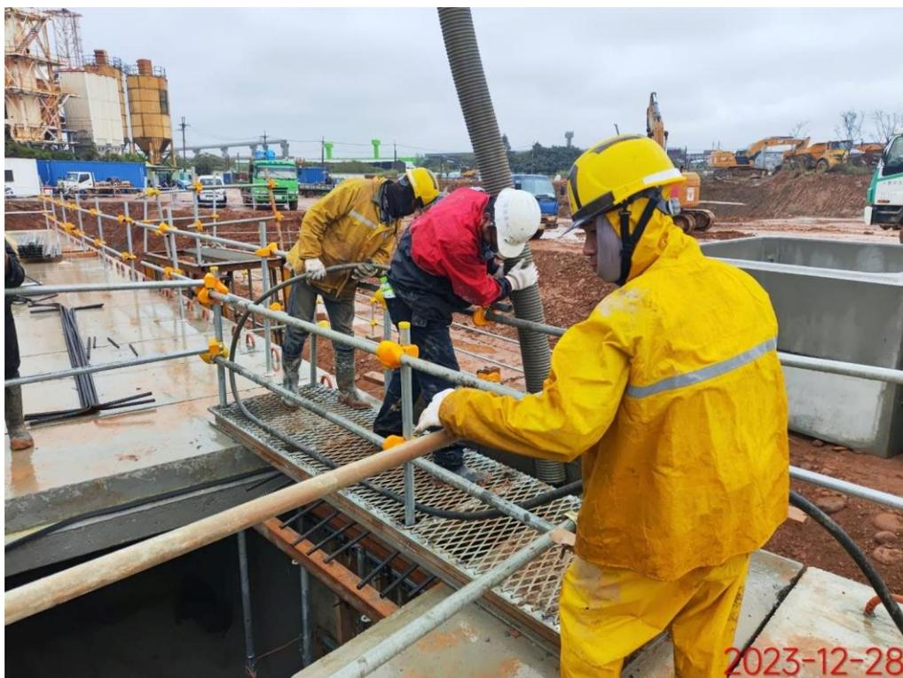
B0 箱涵底腹版混凝土澆置
