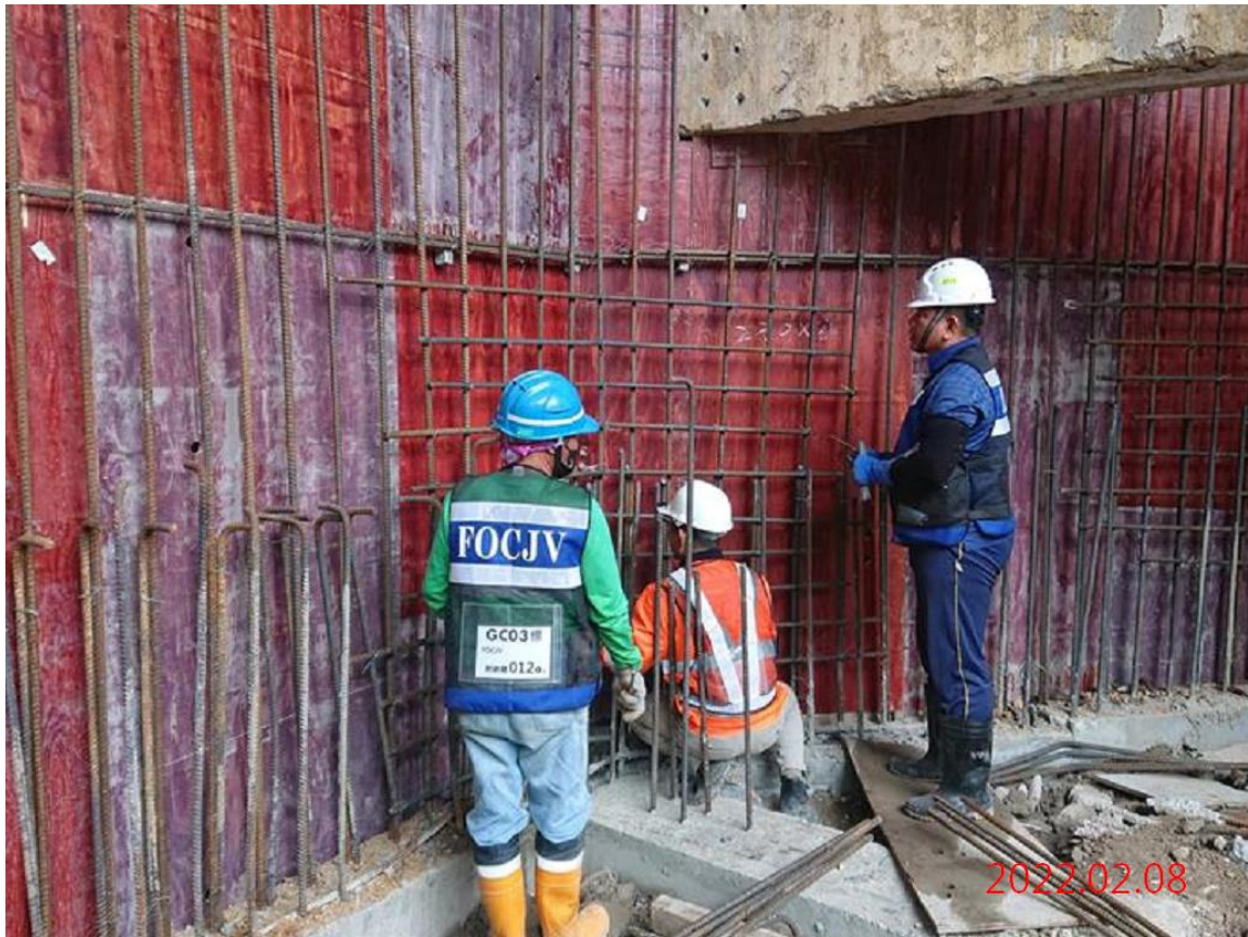
G08 站_深導溝施作
