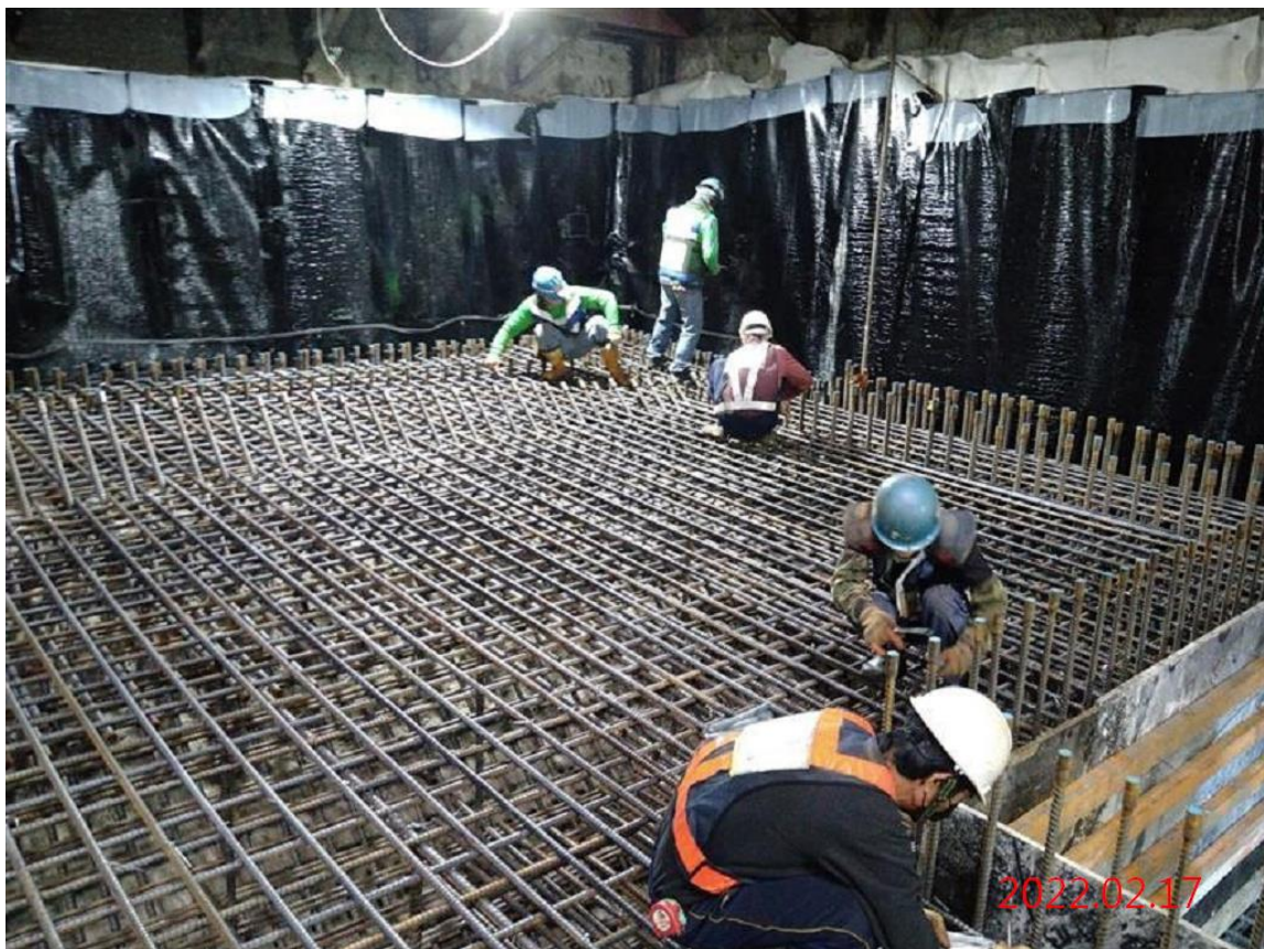
G12 站_站體結構底板鋼筋綁紮
