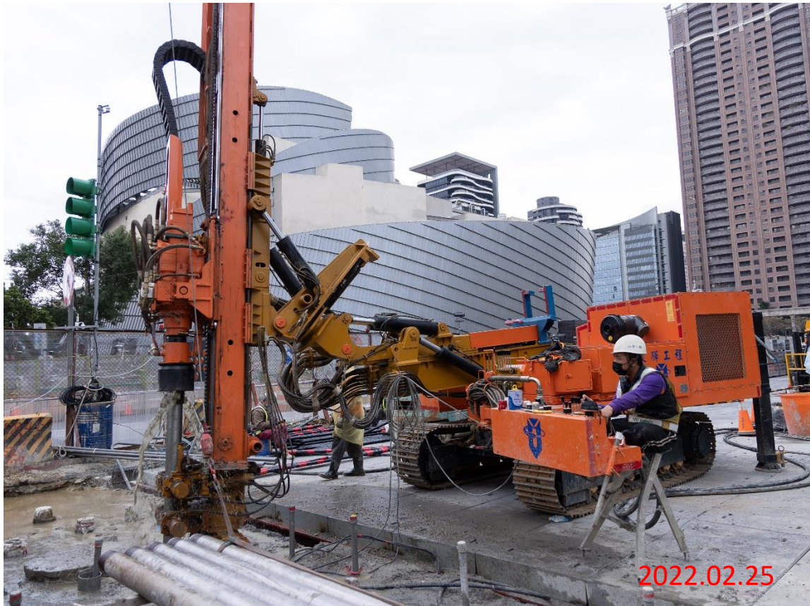
潛盾隧道_G11 站發進端地盤改良施作
