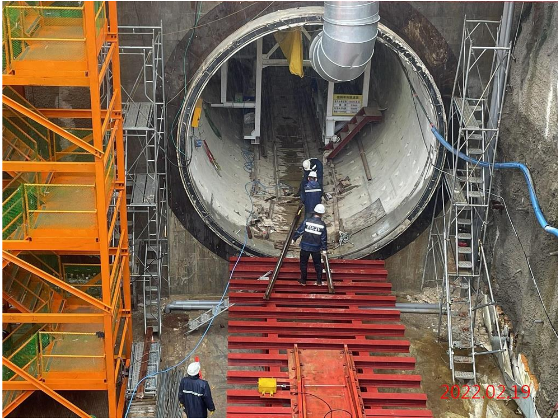
潛盾隧道_潛盾設備轉換作業
