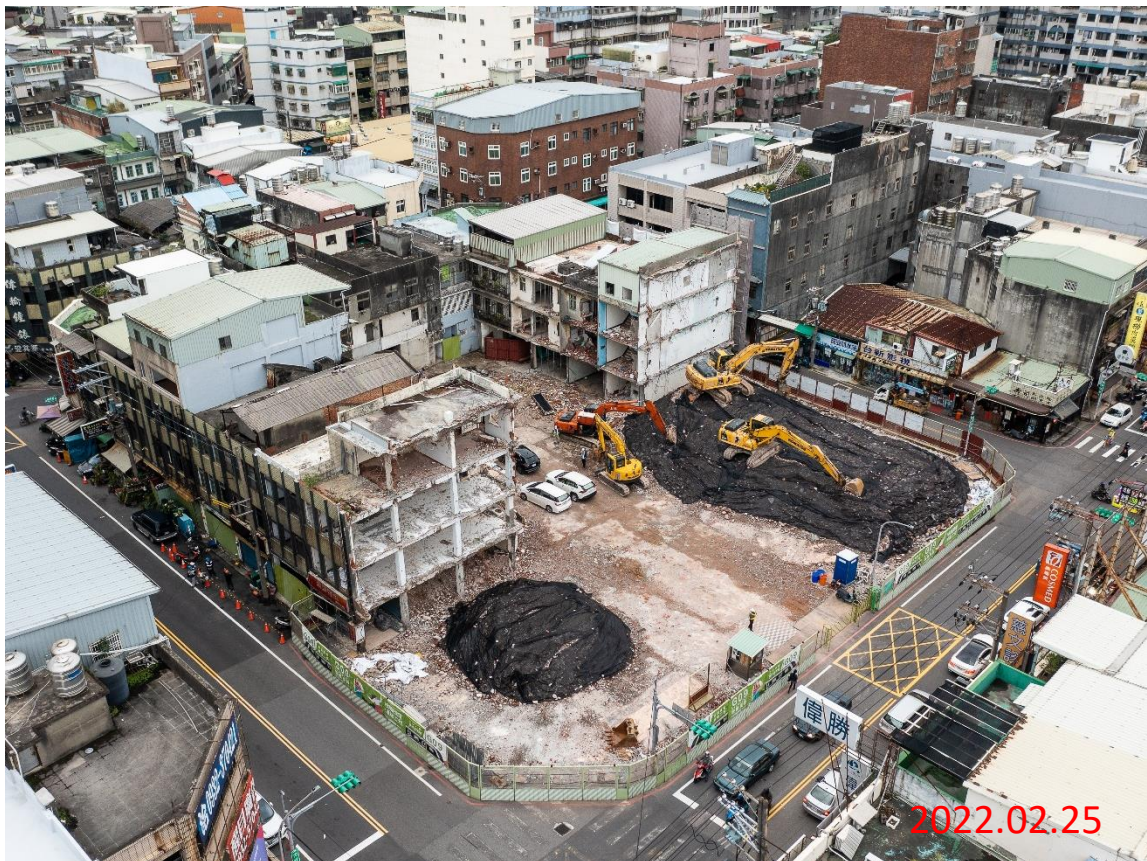
G09 站_建物拆除
