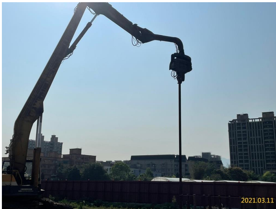
南出土段鋼軌樁打設
