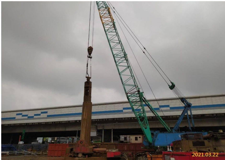
VS5 通風豎井中間柱施作
