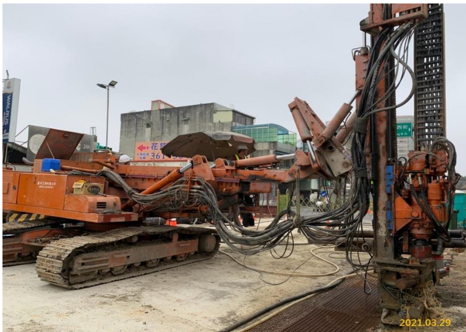
G05 站地盤處理
