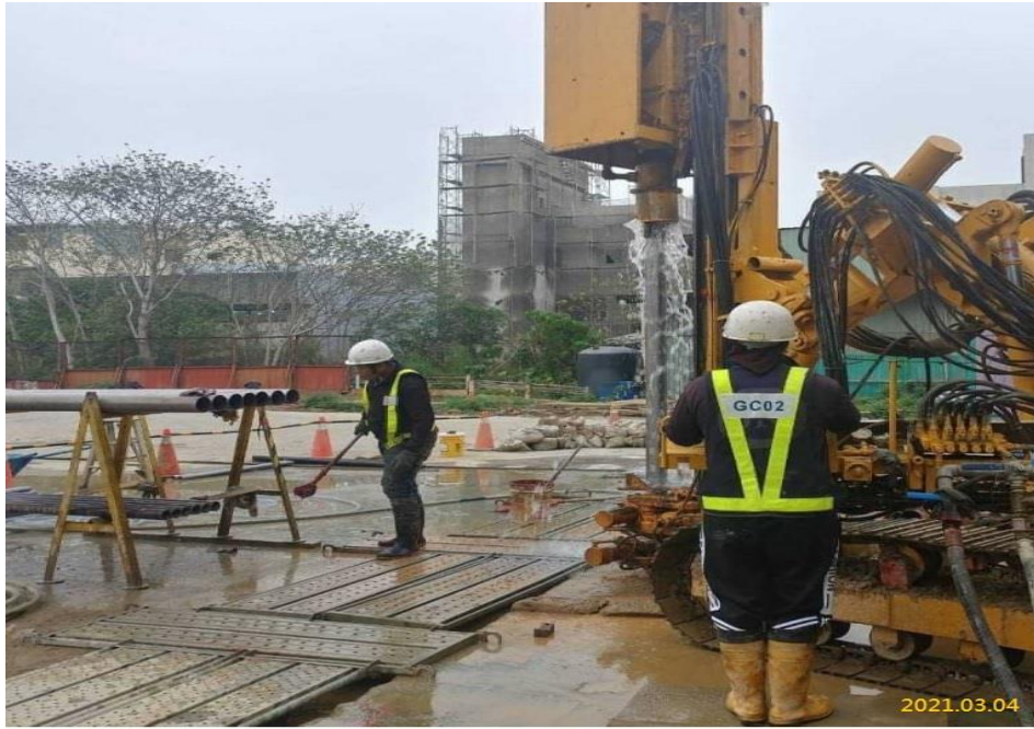
南出土段地盤處理鑽孔施作
