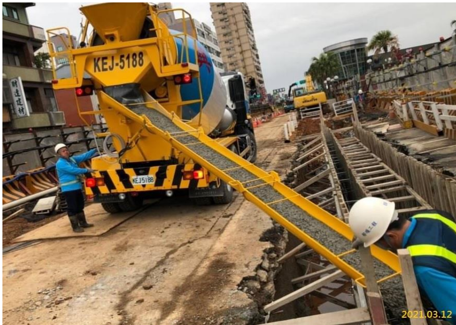
G04 站導溝施作
