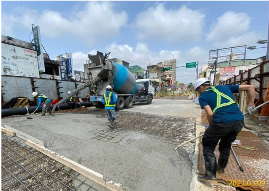
G05 站導溝鋪面施作
