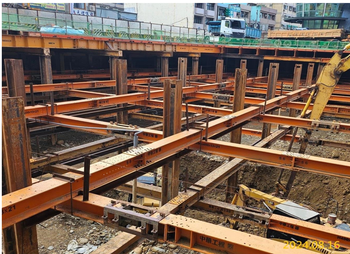
G04 出入口開挖施作
