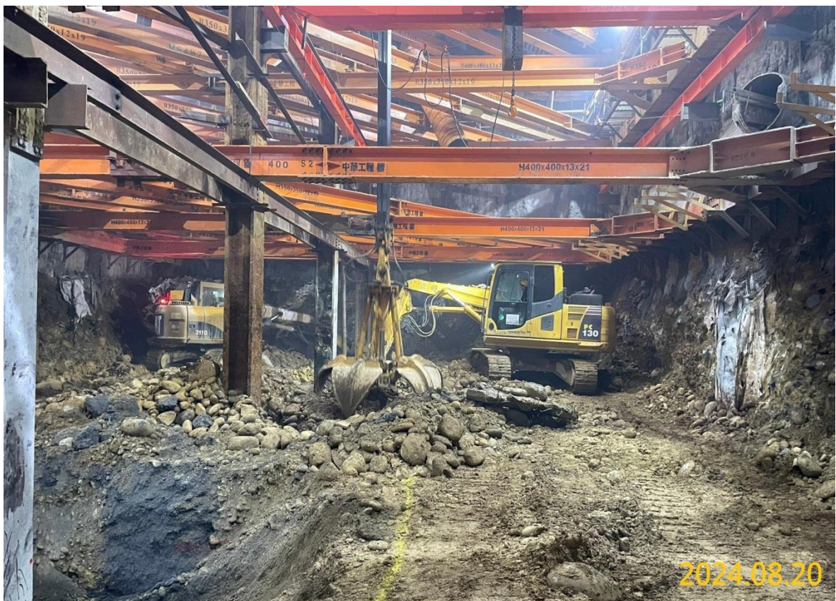
VS4 通風豎井開挖施作
