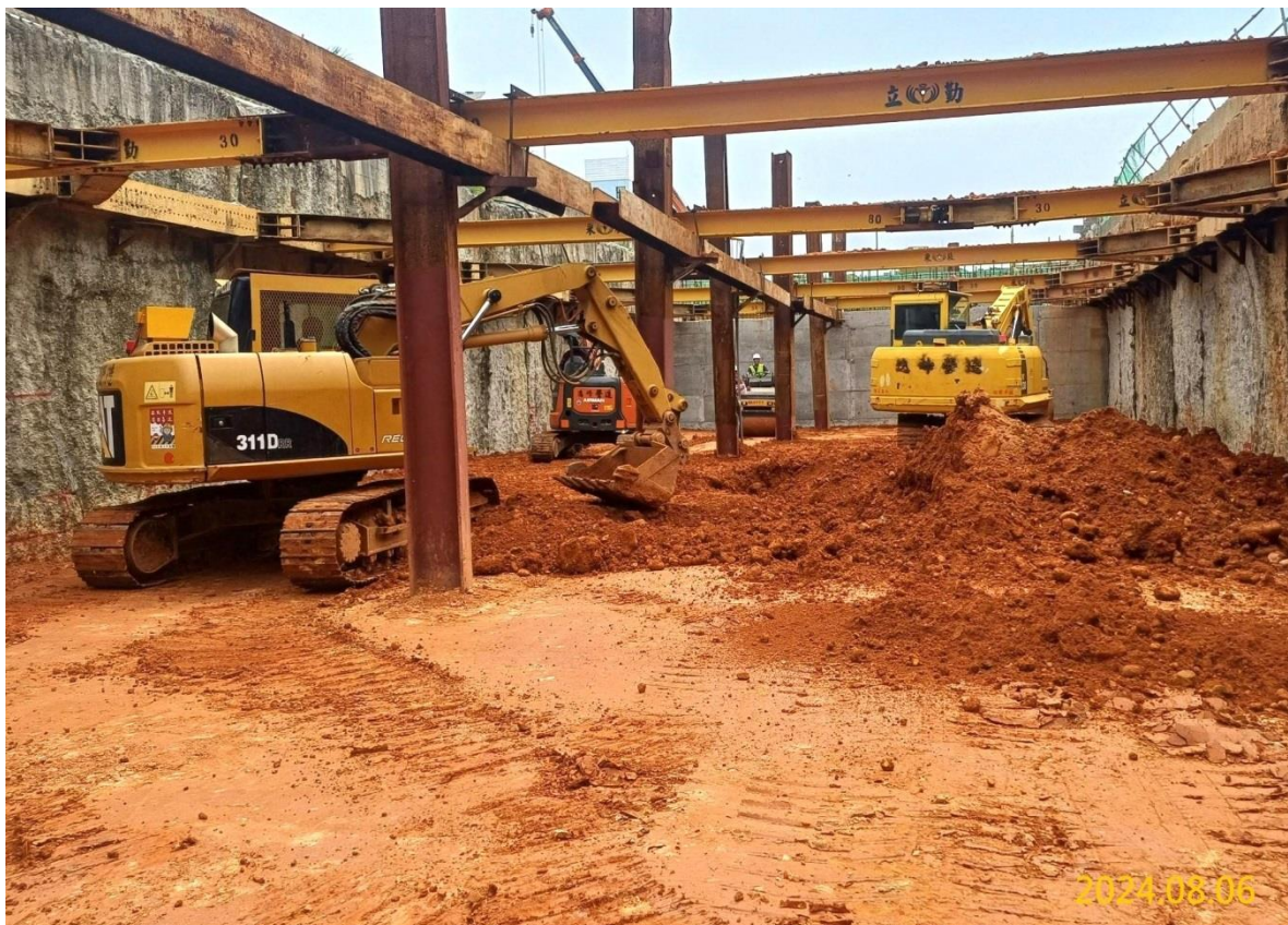
南出土段結構回填
