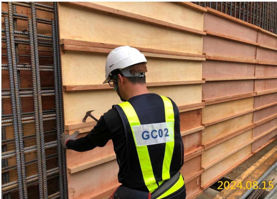
VS6 通風豎井隔間牆施作
