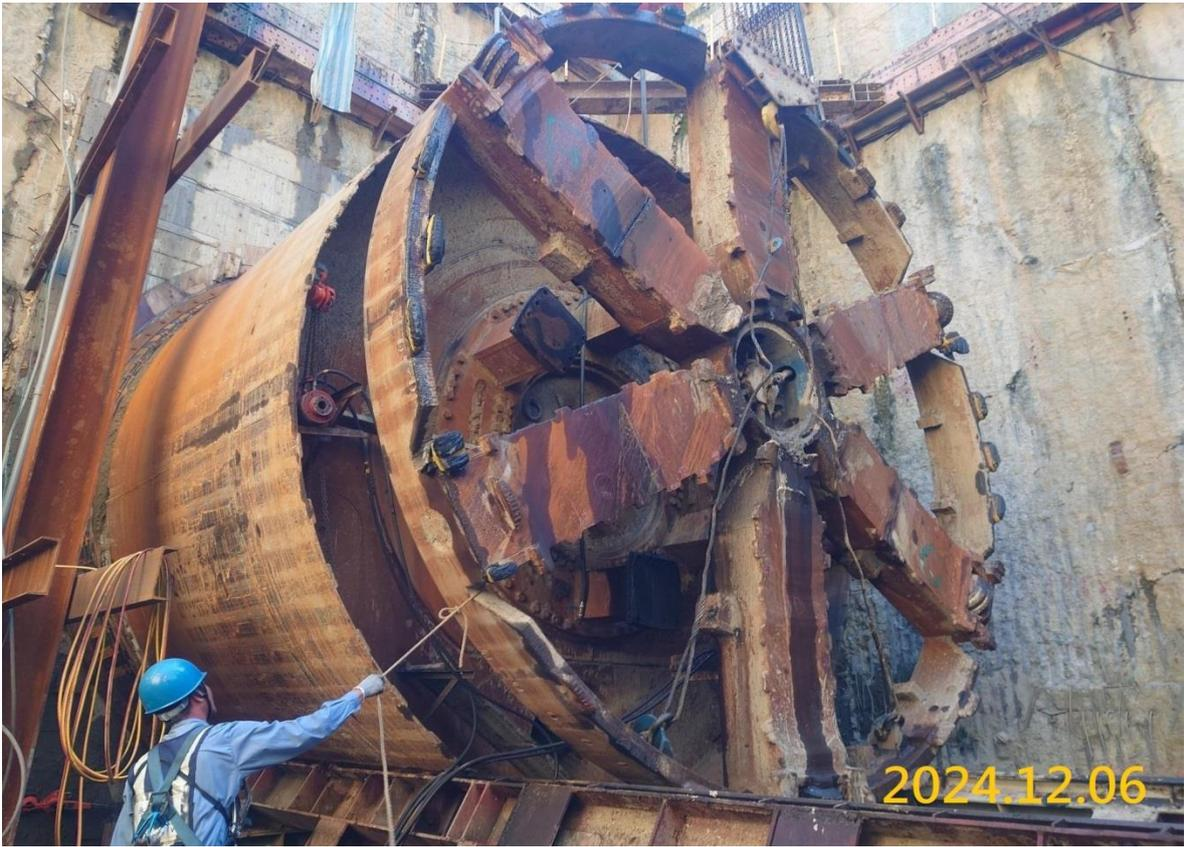
南出土段潛盾機到達刃盤拆除作業
