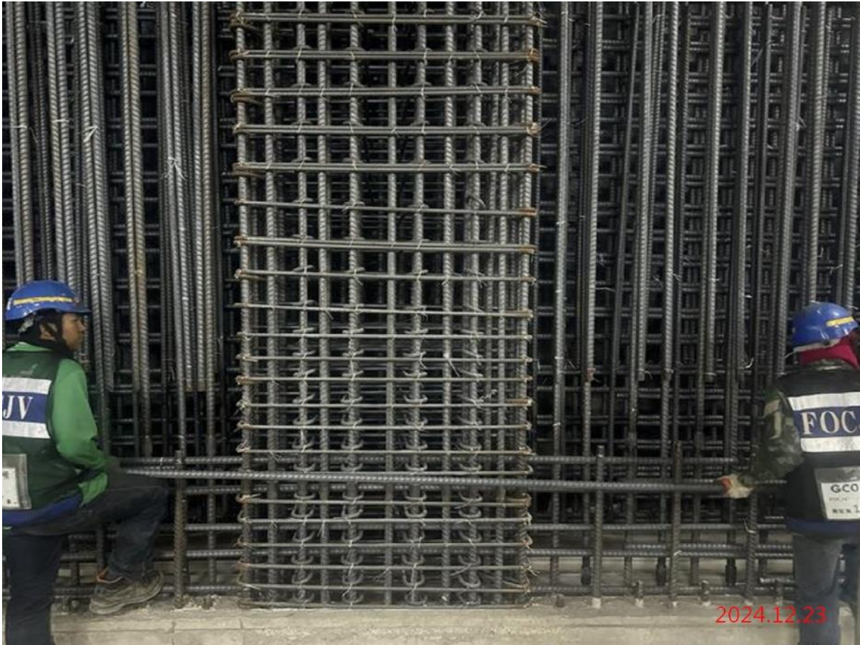
G07_結構 B4F 柱牆鋼筋綁紮
