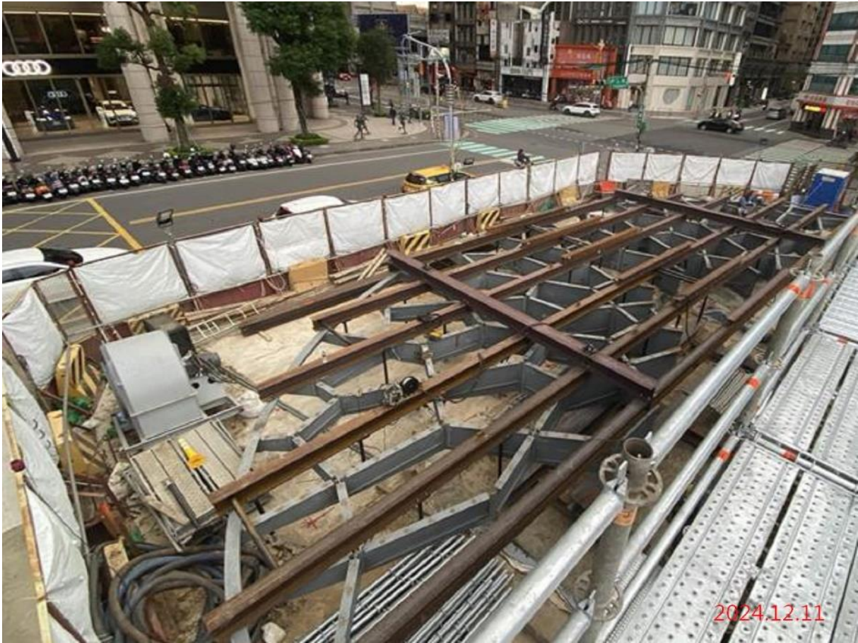
G11_出入口 A 屋頂蜂巢鋼構造地面組立
