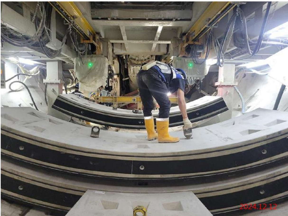
潛盾隧道_中圓上行線掘進(G10~G09)-環片吊裝作業
