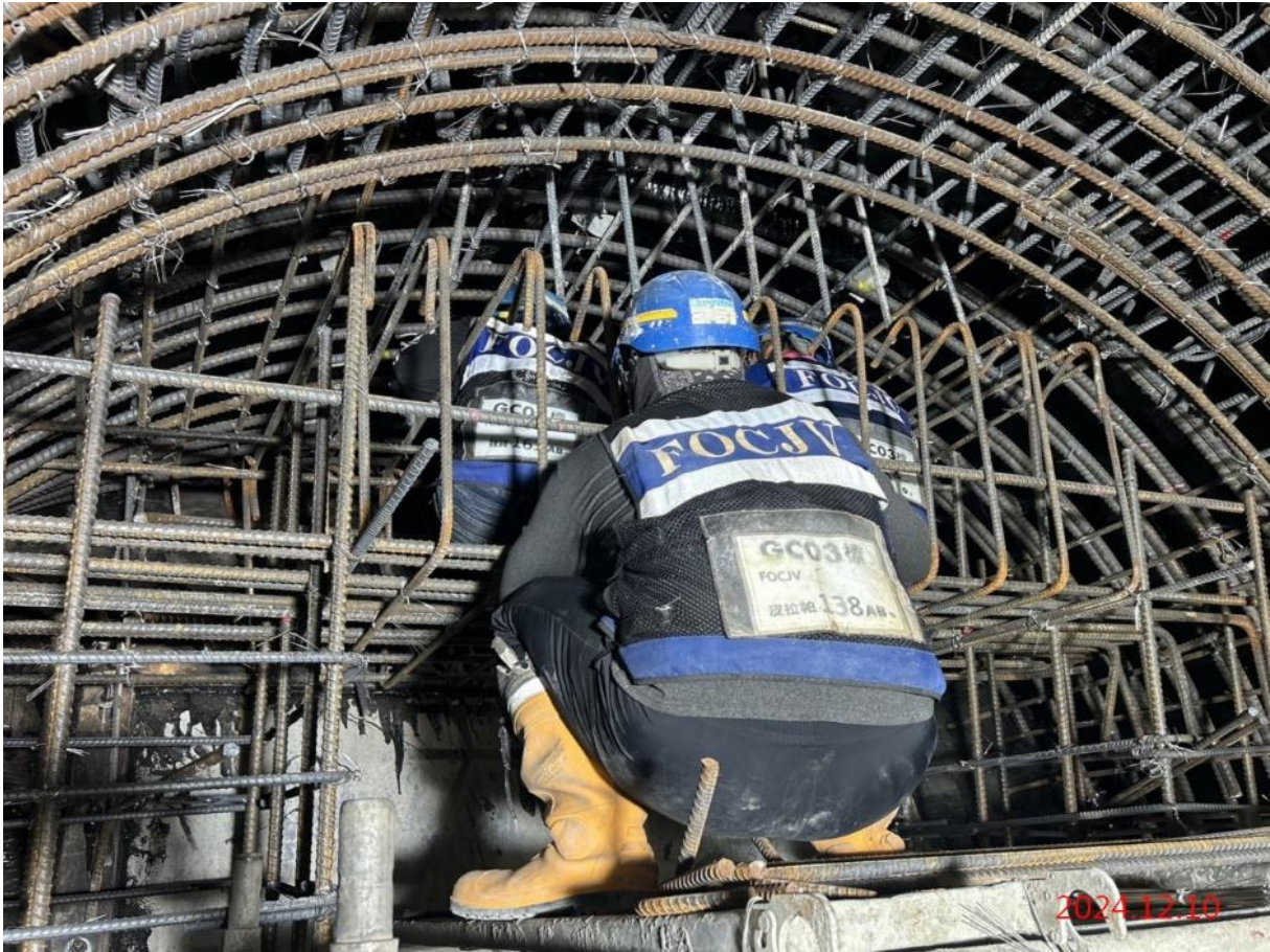
潛盾隧道_小圓 CP6 聯絡通道結構鋼筋綁紮
