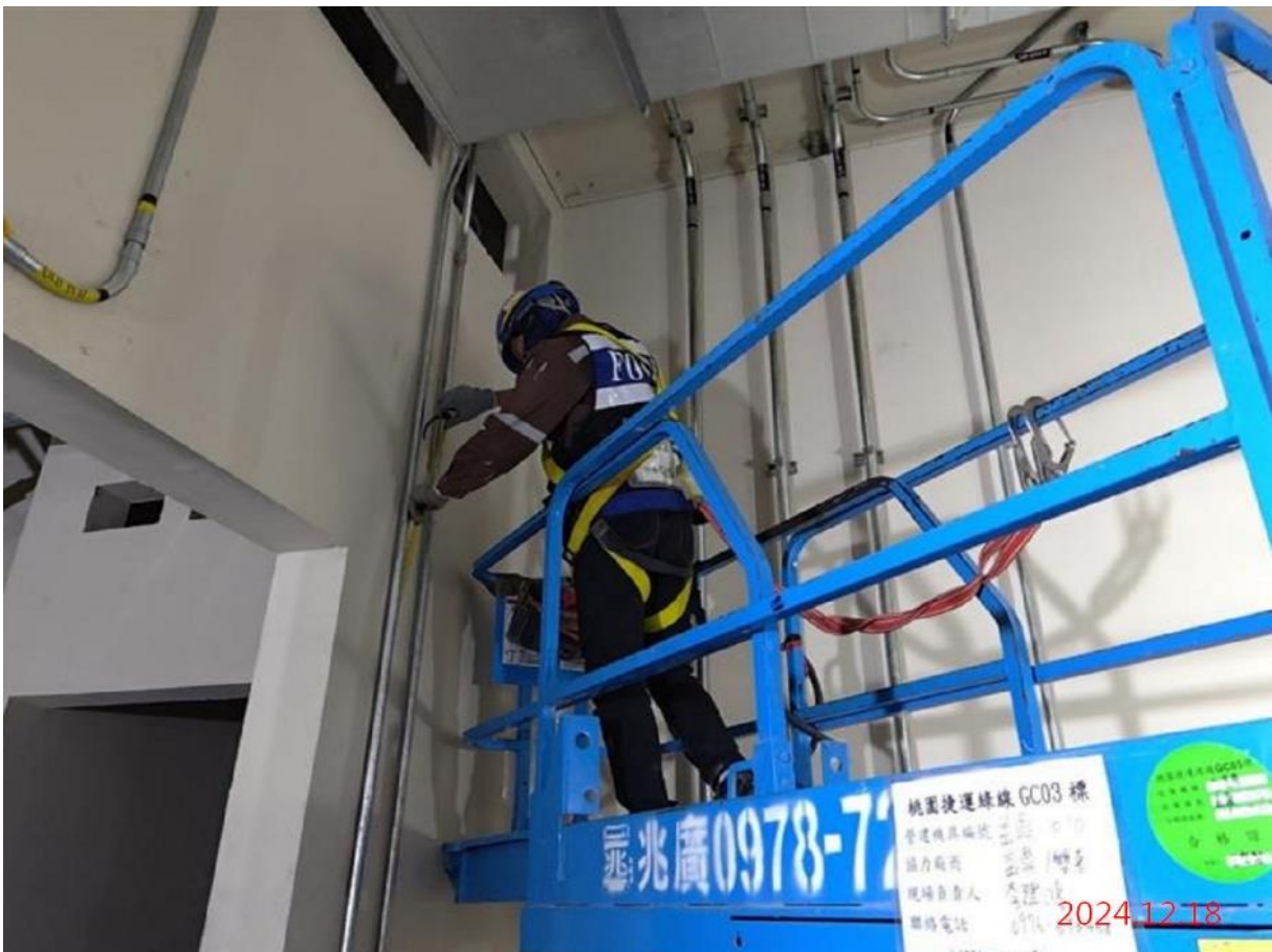
G12_出入口 A 穿堂層電氣系統-電管施作
