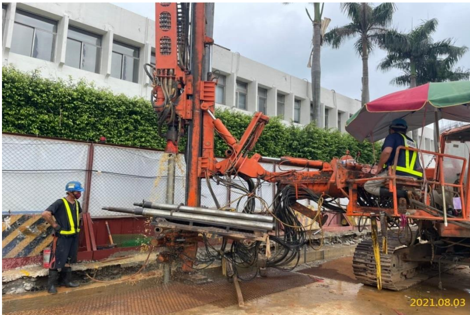
G05 站地盤處理施作
