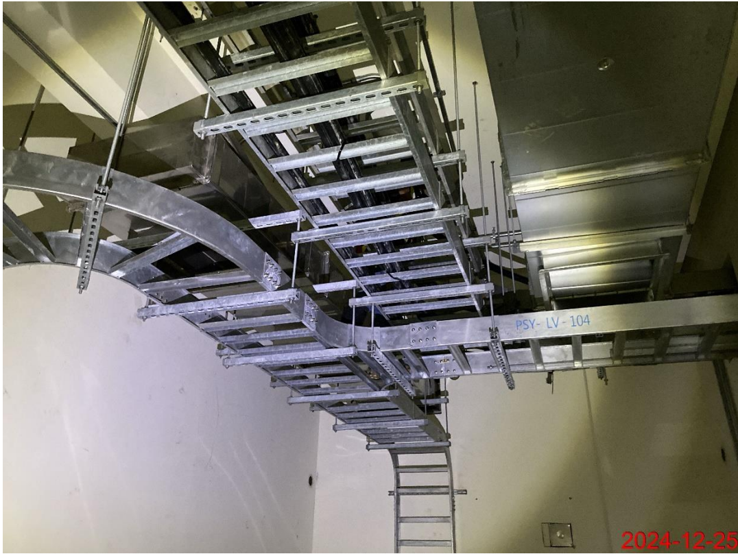
北機廠管理中心 22kV 佈纜作業
