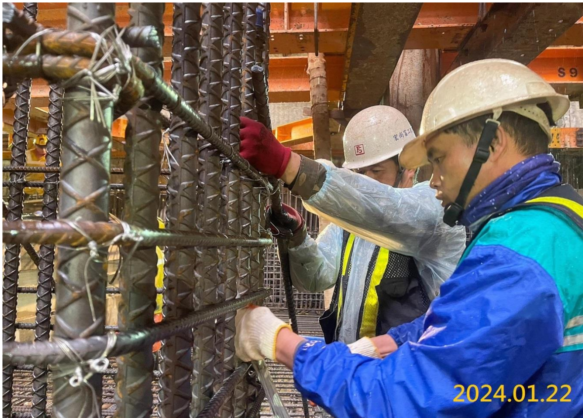
G03 出入口結構體施作
