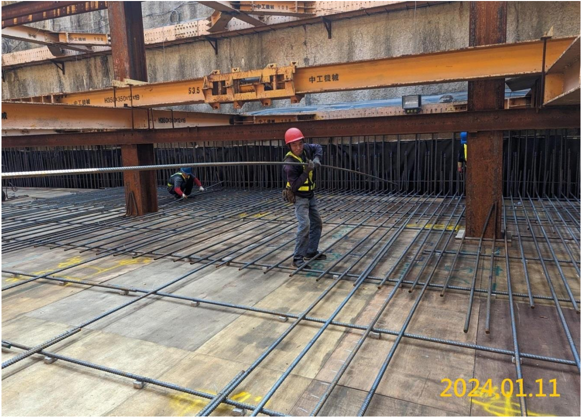
VS6 通風豎井結構施作
