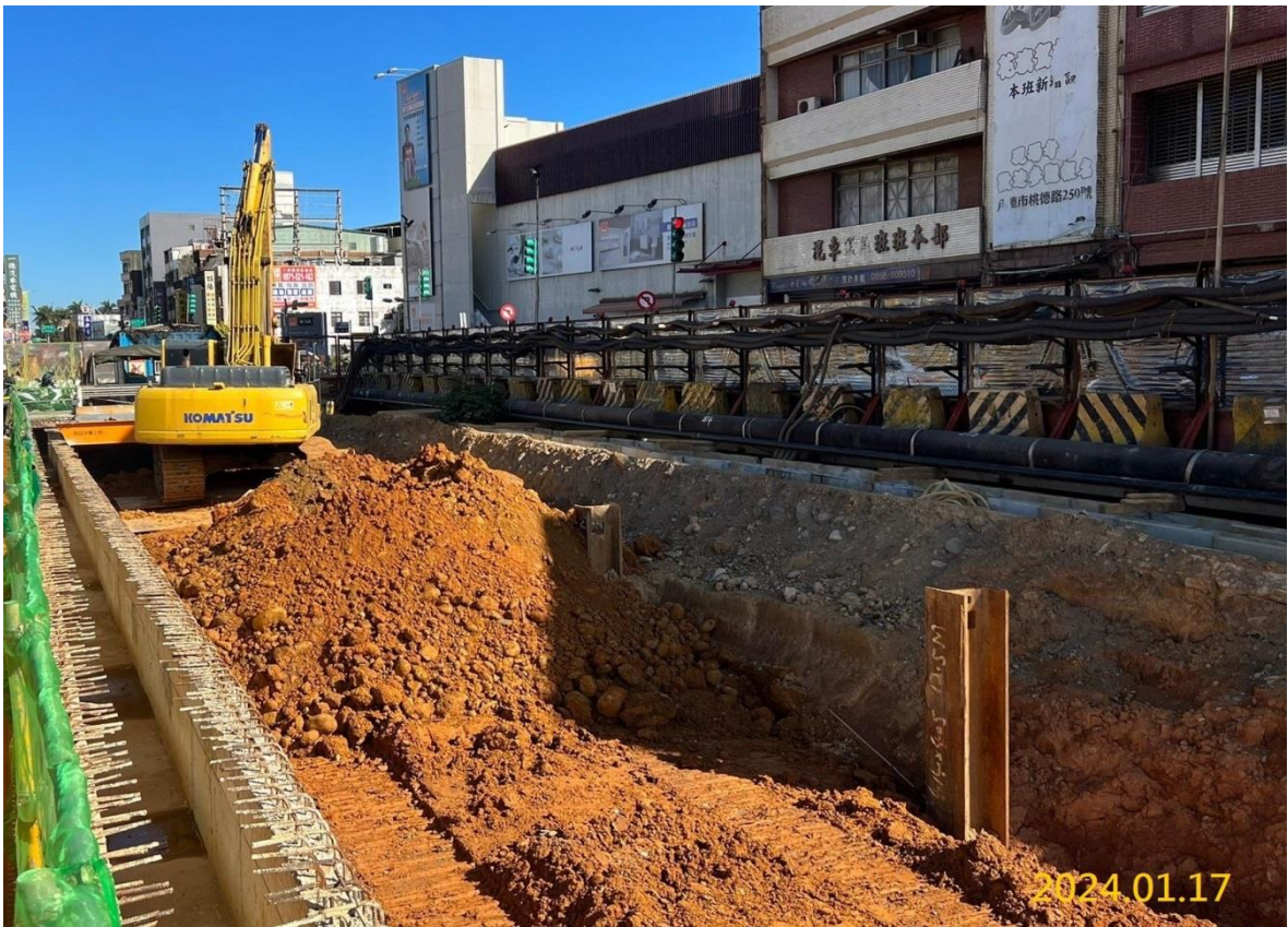
G05 站開挖施作
