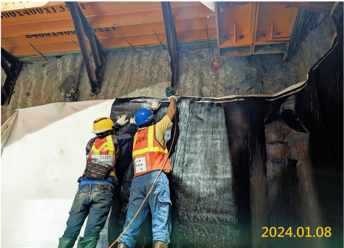
VS5 通風豎井結構防水施作
