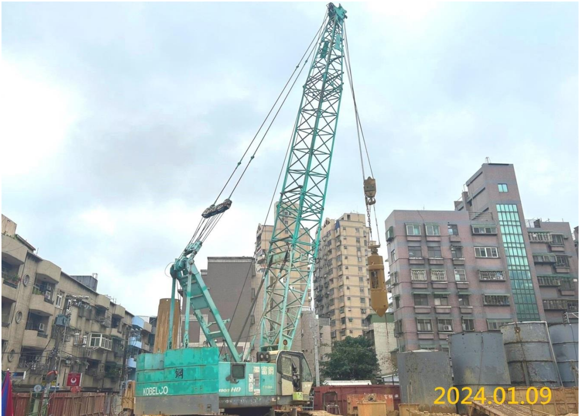
G04 出入口 B 中間柱施作
