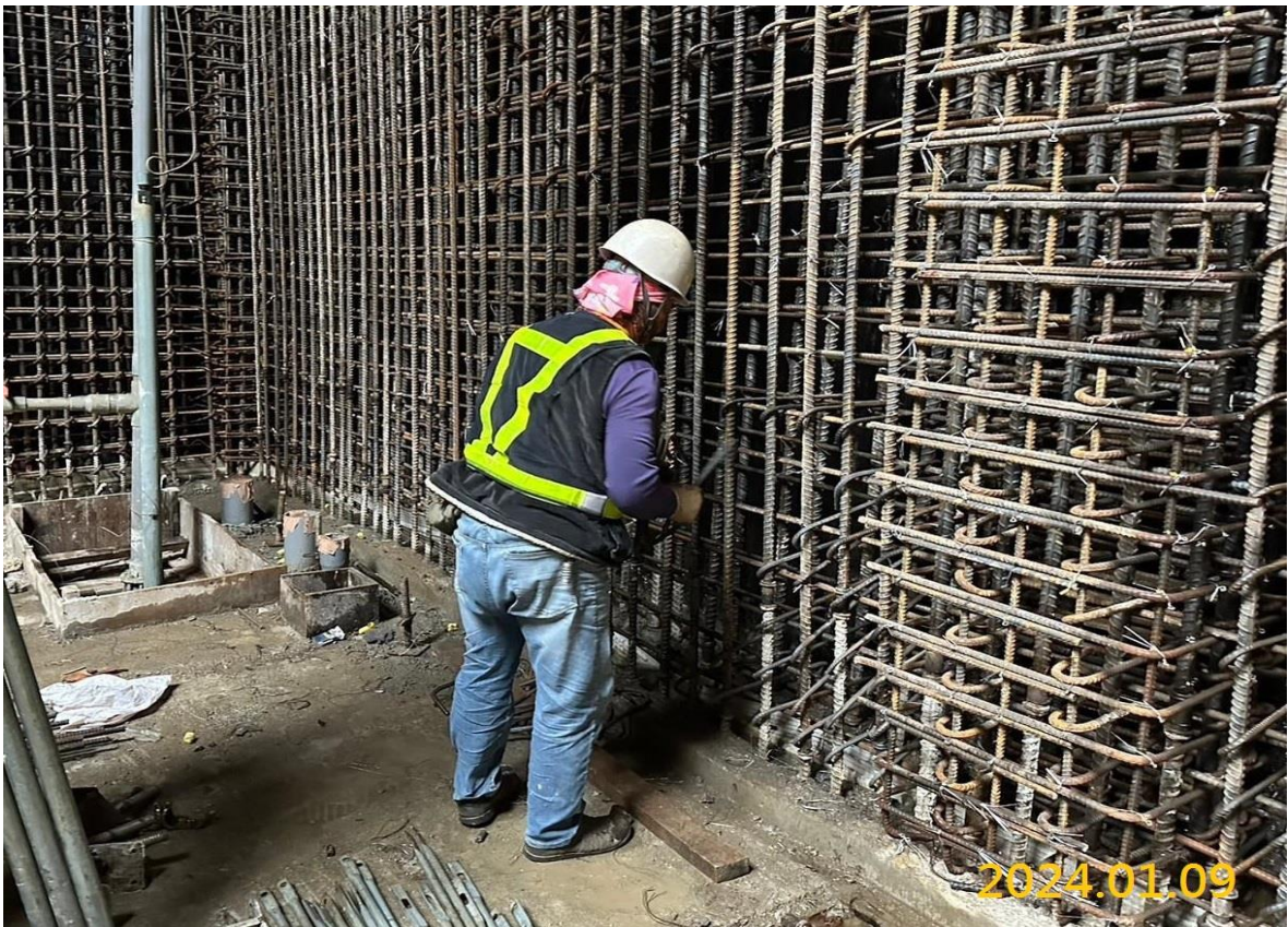
G06 通風井結構體鋼筋綁紮
