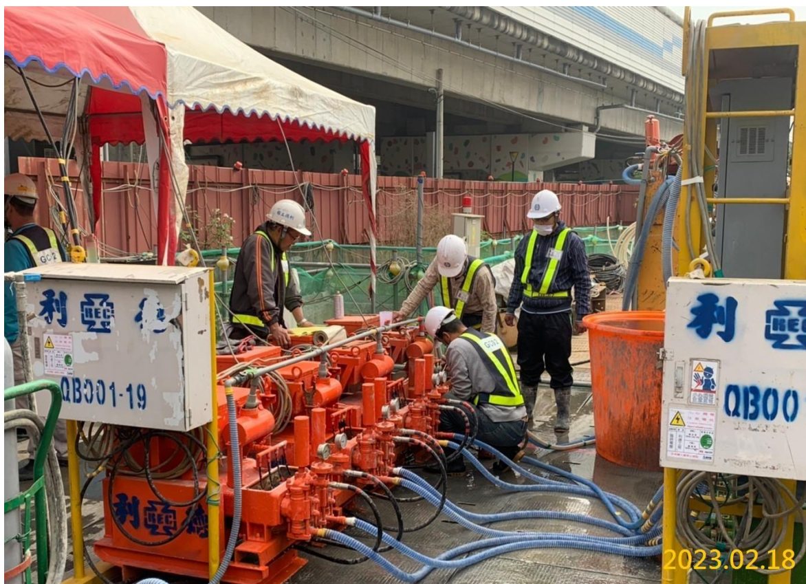
VS5 通風豎井潛盾隧道地盤處理
