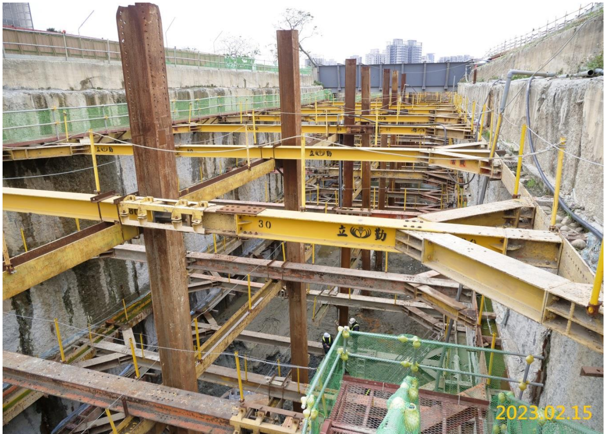
南出土段支撐施作
