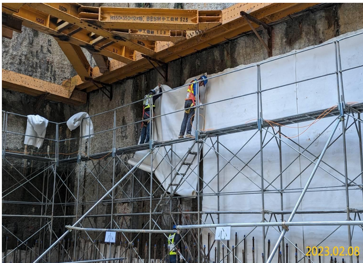
VS6 通風豎井結構體防水膜施作
