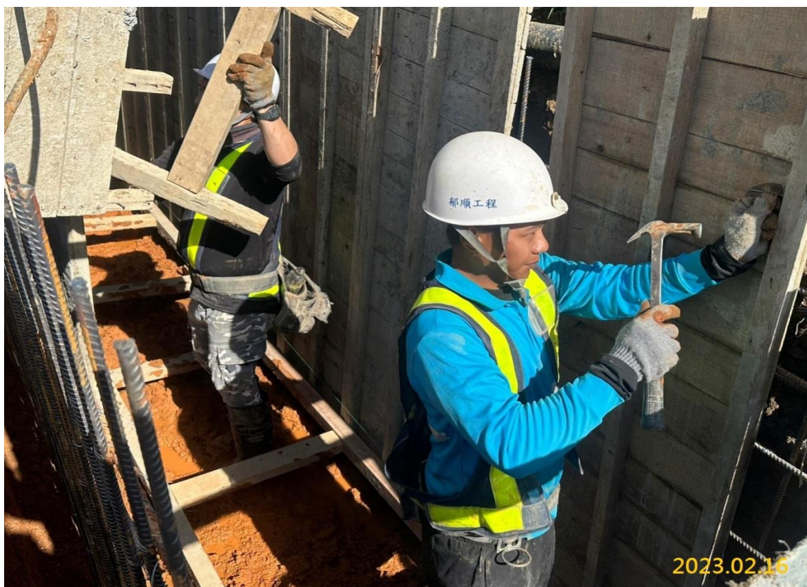
G06 站連續壁導溝施作
