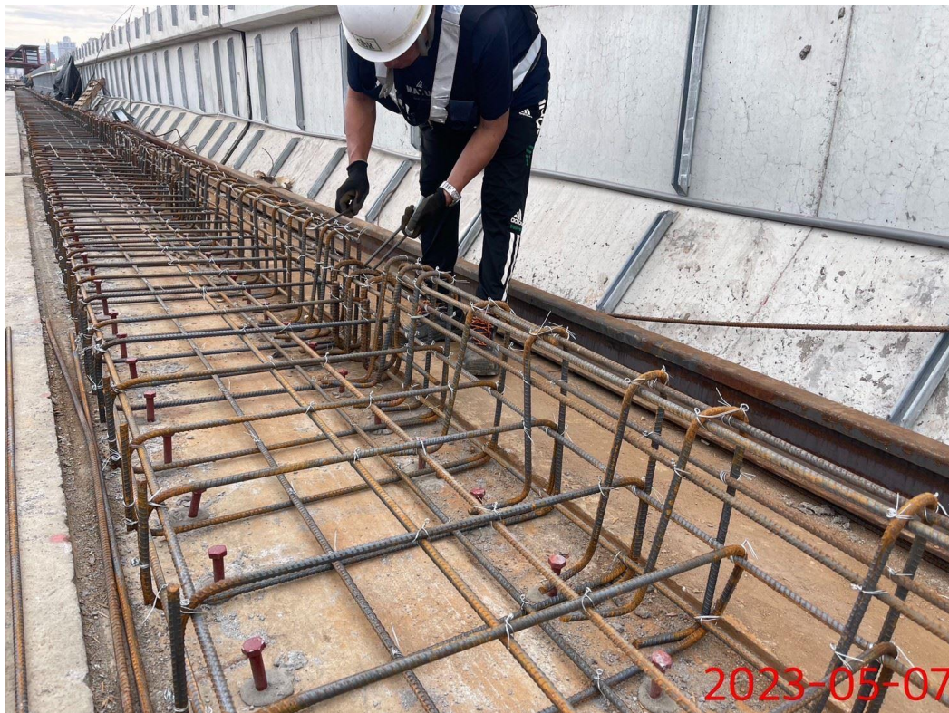
G13~G13a 下行線鋼筋綁紮(D16-D27)
