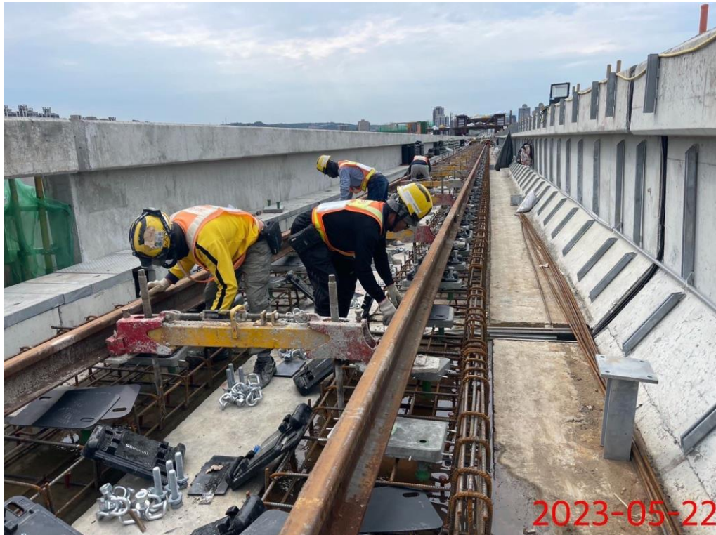
G13~G13a 下行線預鑄基底基鈑佈設及安裝(D16-D27)
