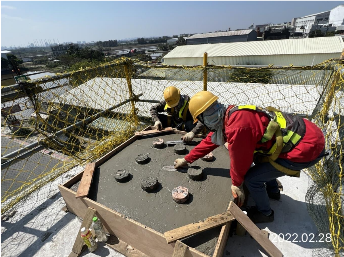
蘆竹蘆興街 帽梁鋼筋綁紮
