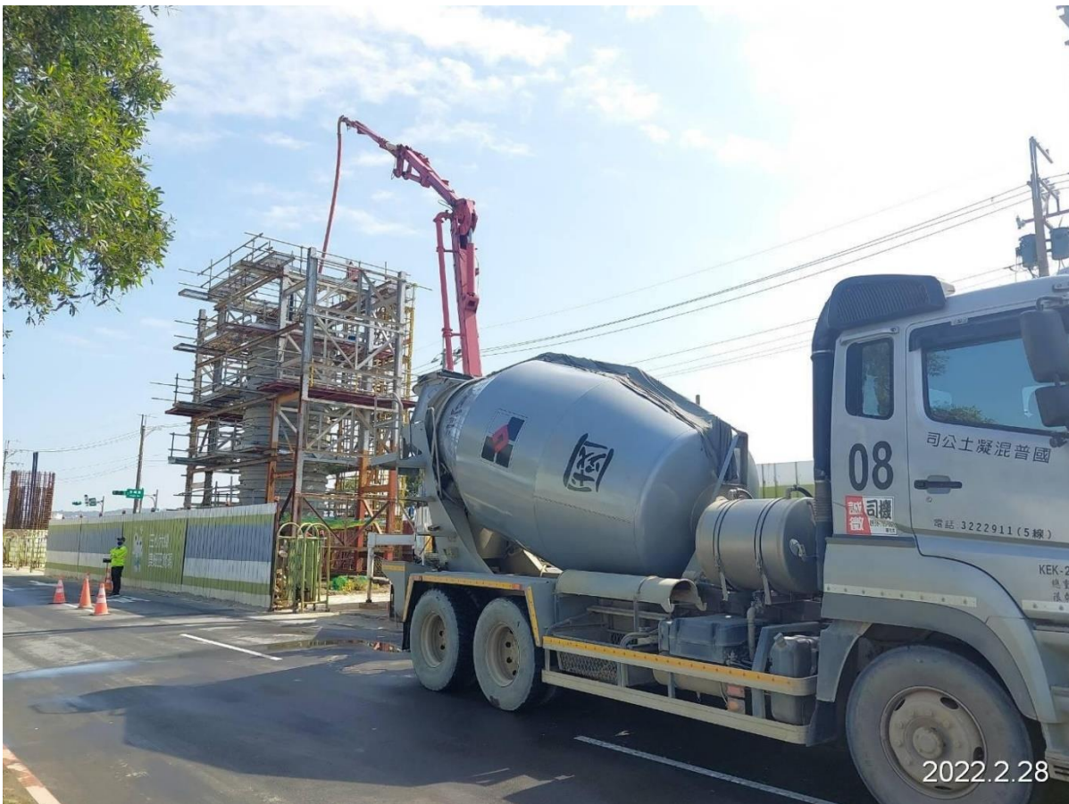
大園坑菓路 墩柱混凝土澆置
