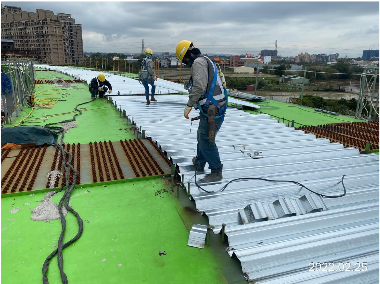
八德新闢道路 鋼承板鋪設
