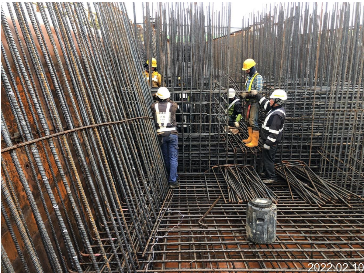
大園坑菓路 場撐箱型梁鋼筋綁紮
