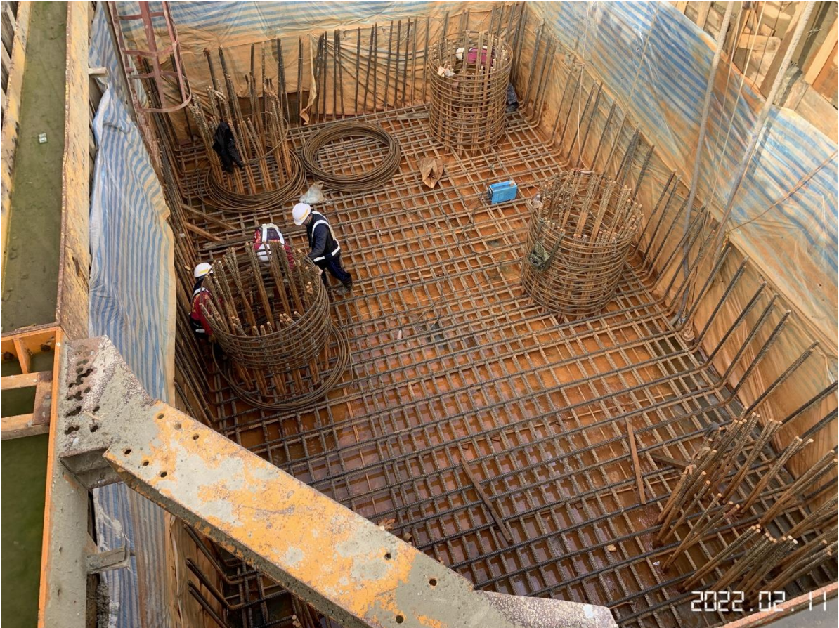
大園坑菓路 樁帽鋼筋綁紮
