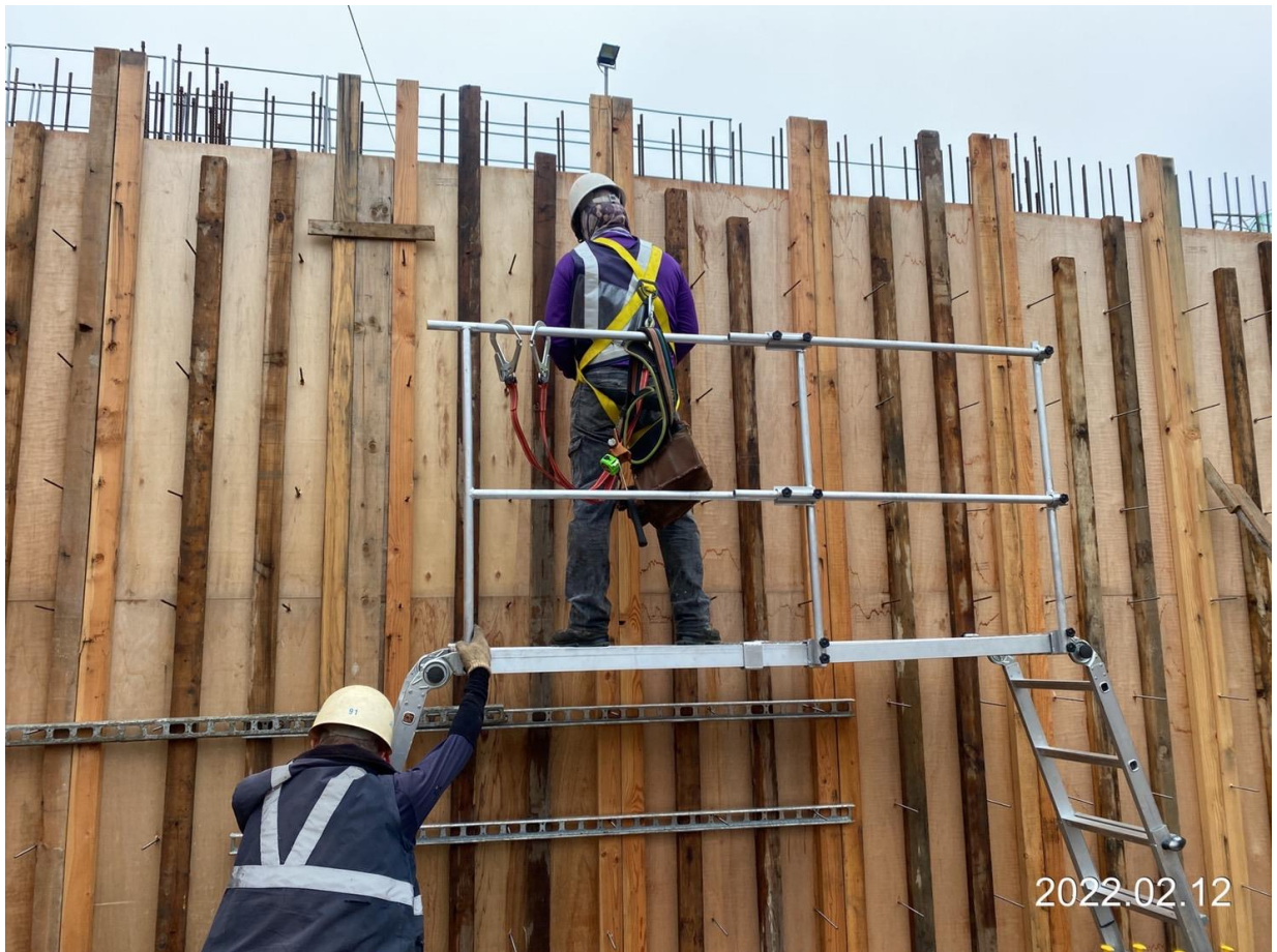
大園坑菓路 G32 車站出入口 2 樓柱牆模板組立
