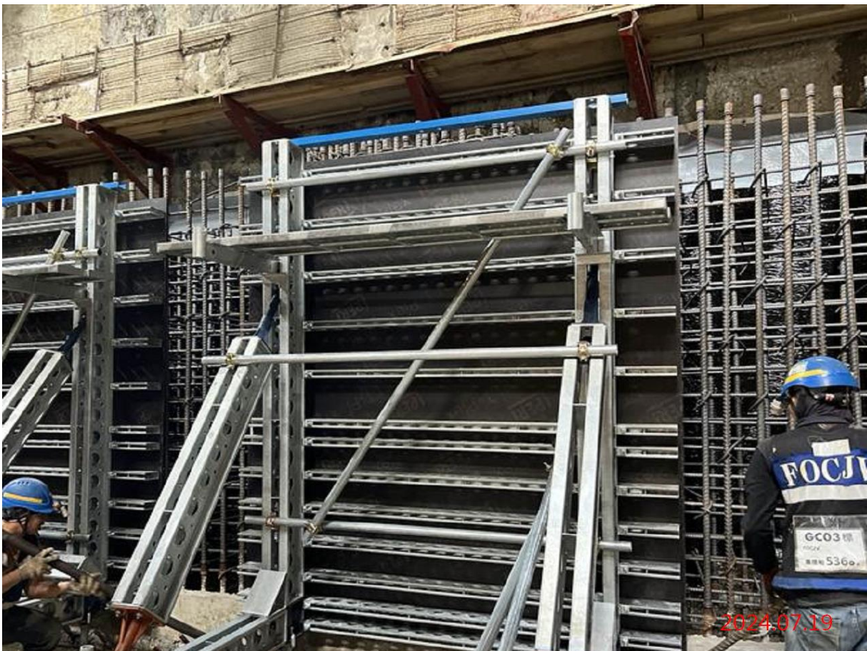
G08_ B4F 站體側牆系統模組立
