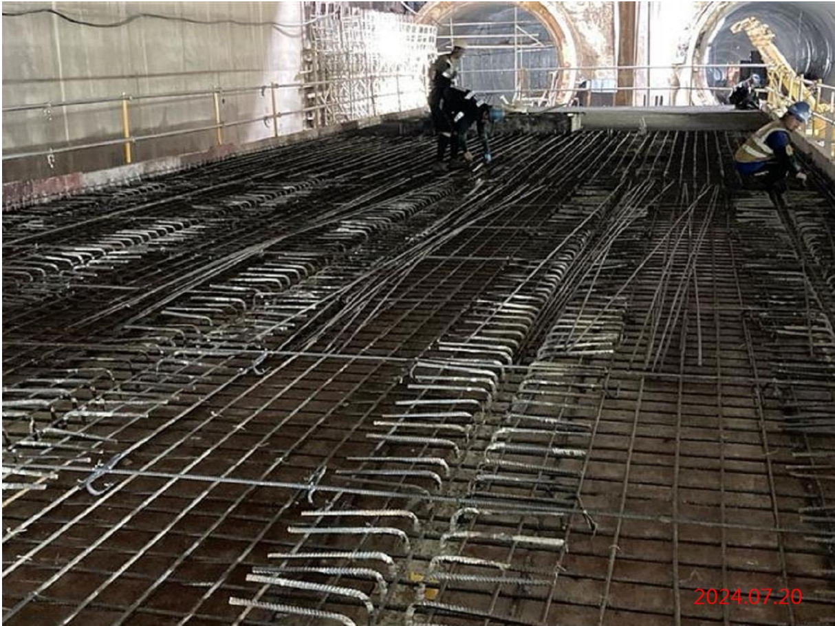
G11_站體軌道層月台版鋼筋施作
