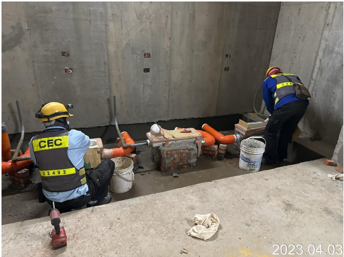
G13 站 3F 蹲便裝設
