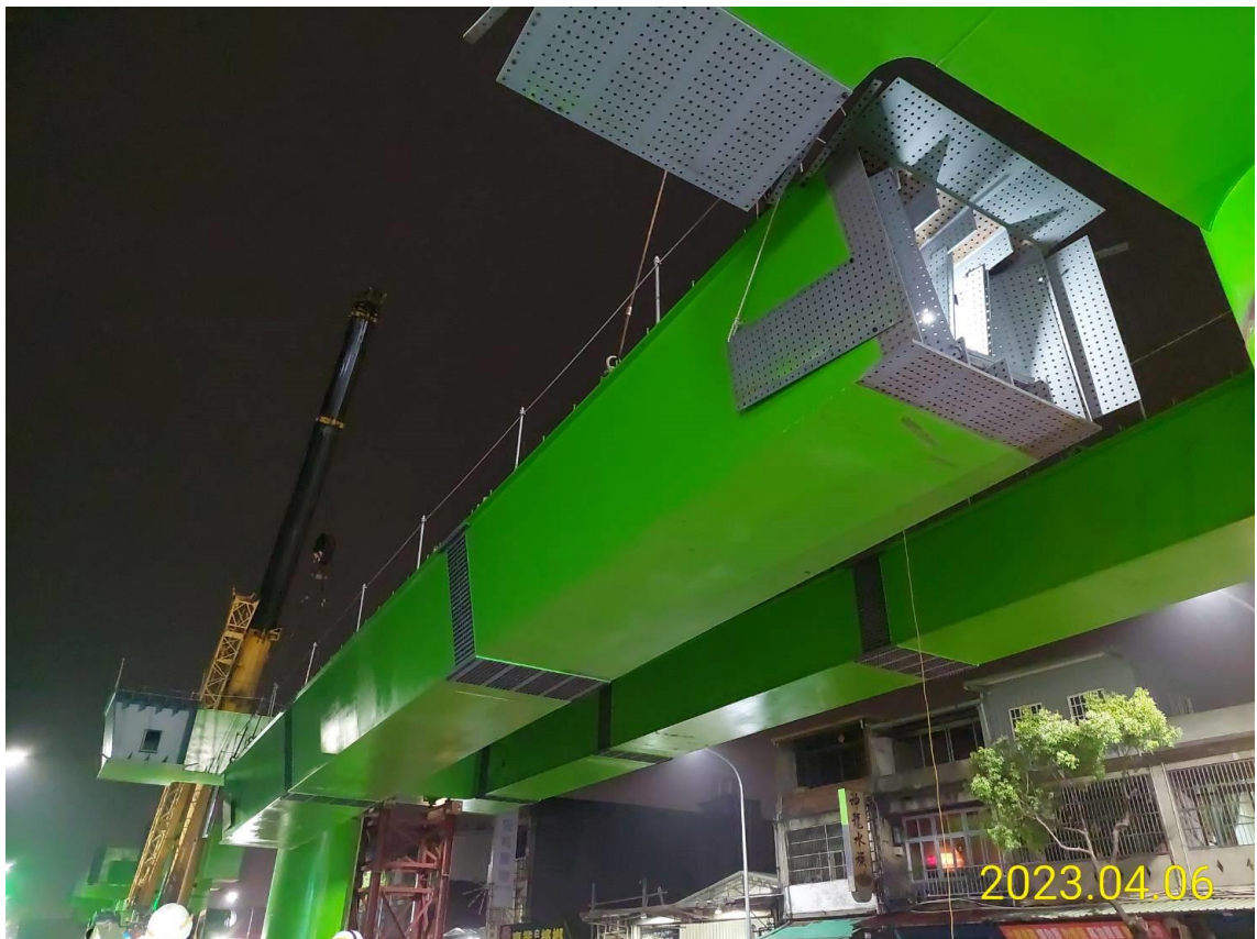
DU13a-14 鋼箱梁吊裝 A11~A13 起吊接合
