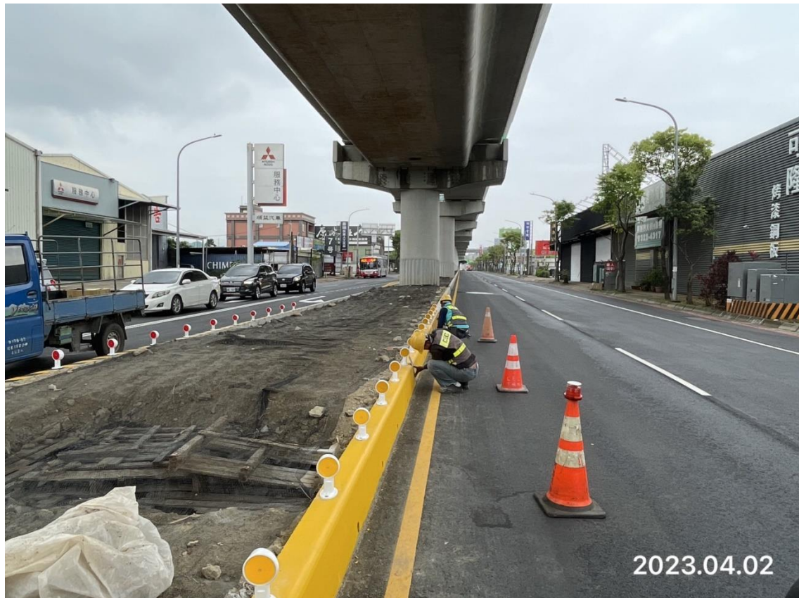
北段_B 工區_道路復舊中央分隔島路緣石(M01, M02)島頭斜線繪製、反光標鈕安裝
