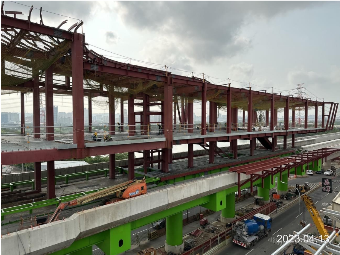
北段_G13a 車站穿堂層填縫及鋼筋綁紮
