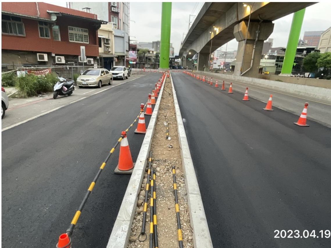
北段_D 工區_樁帽 P13a-28 道路復舊 AC 刨鋪
