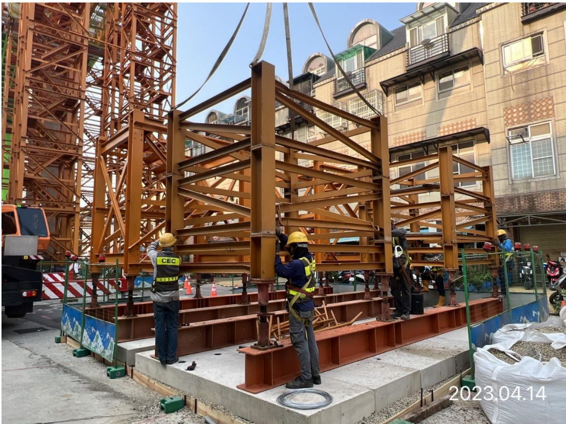
北段上構_DU13a-10 場撐箱型梁支撐架組立
