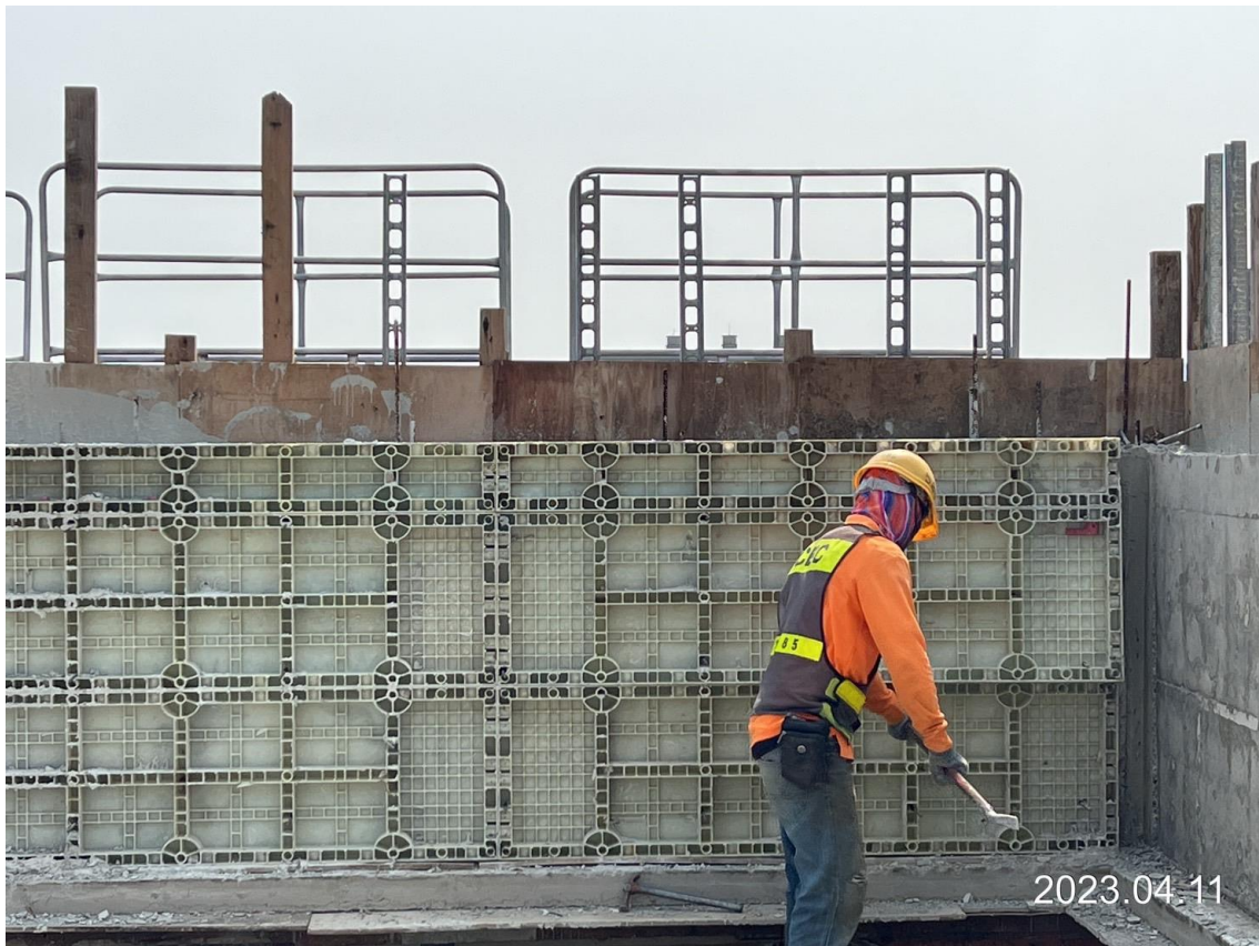
G02 車站出入口屋突層牆面模板組立
