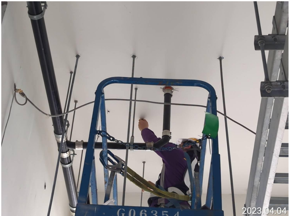
G13 站 2F 電氣管路施作
