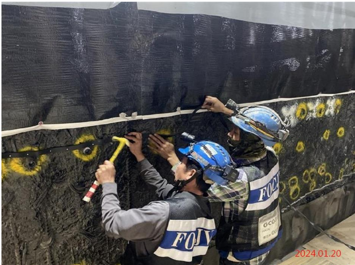
G07_結構 B3F 外牆防水施作
