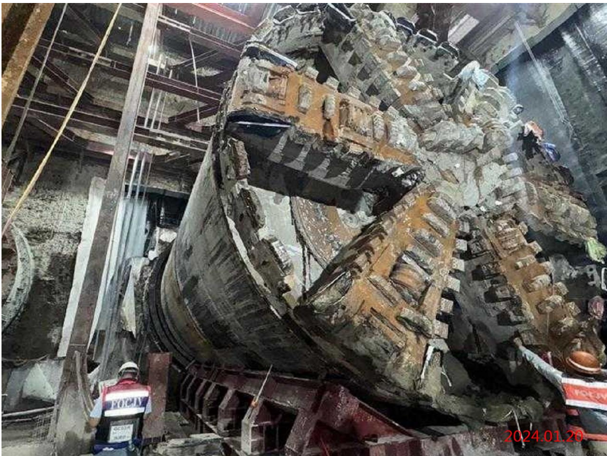
潛盾隧道_小圓潛盾機到達 G11 站拖曳作業
