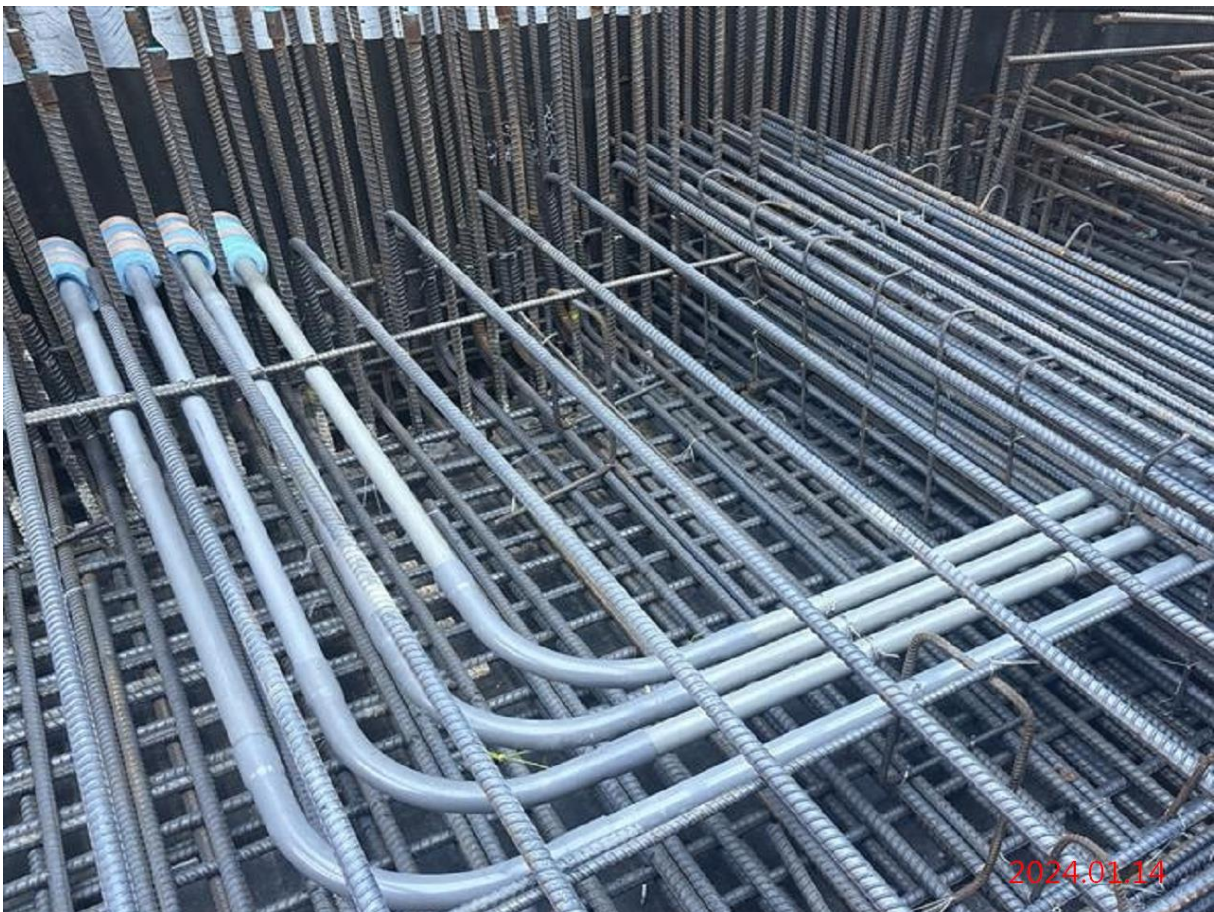
G11_出入口夾層板電扶梯電管預埋
