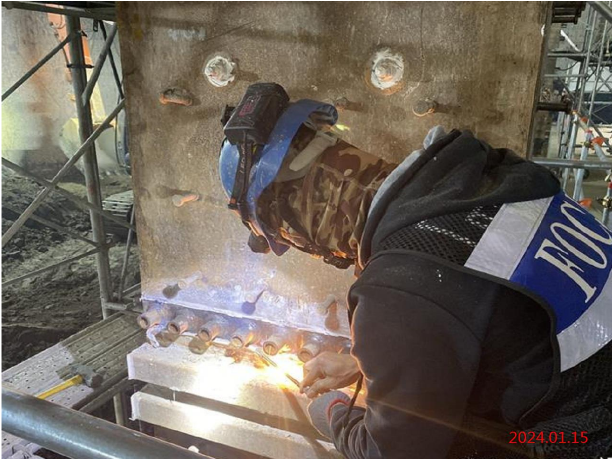
G07_結構 B3F 鋼柱焊接
