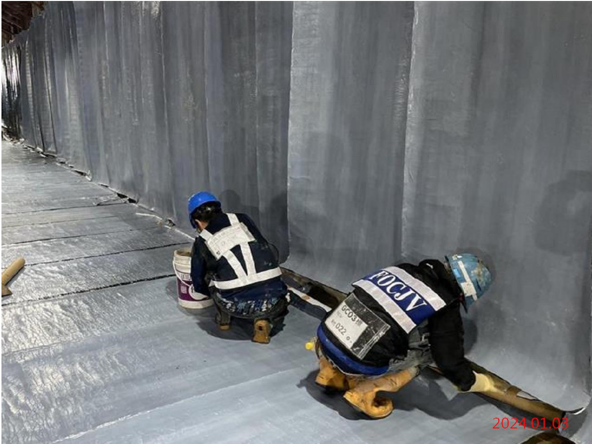
G09_底板及側牆防水膜施作
