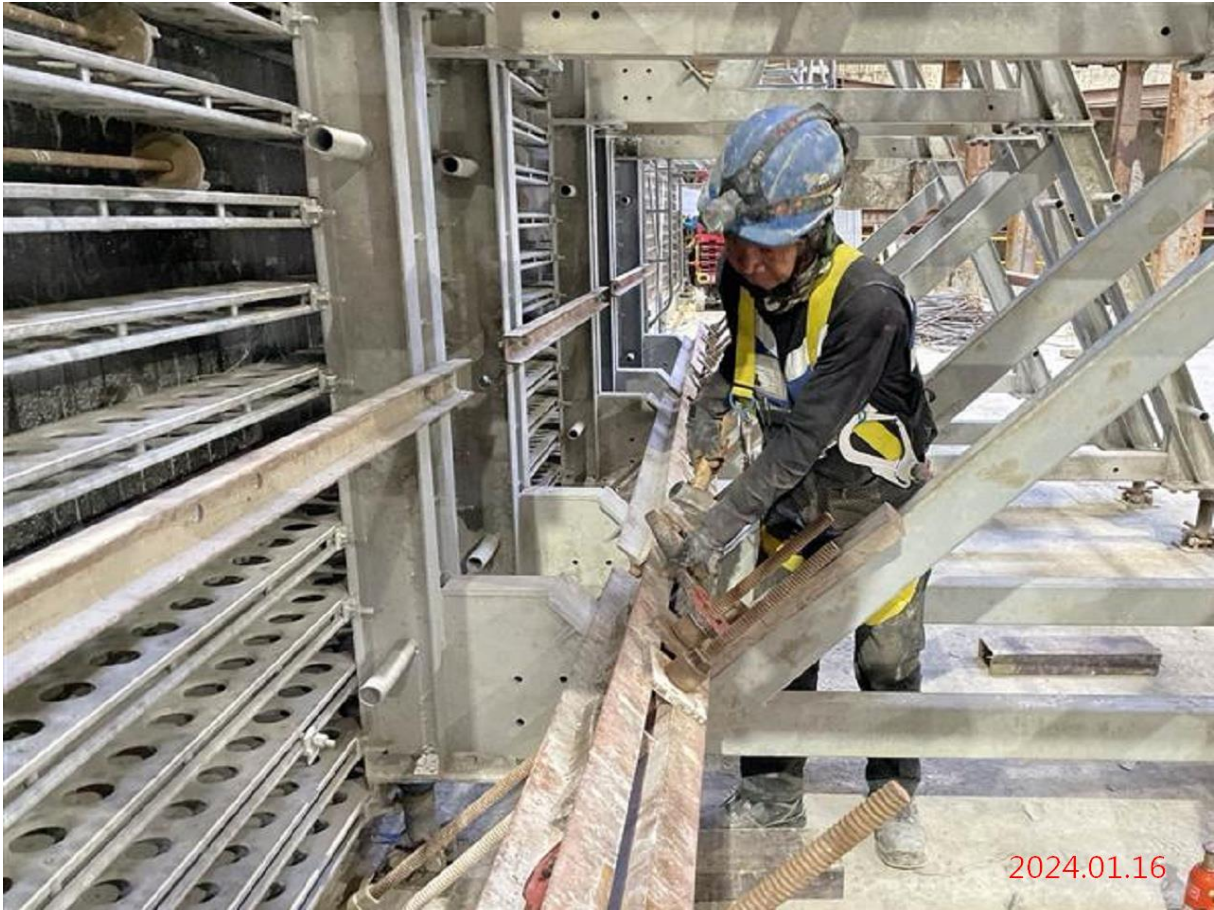
G10_站體軌道層升層牆模板組立
