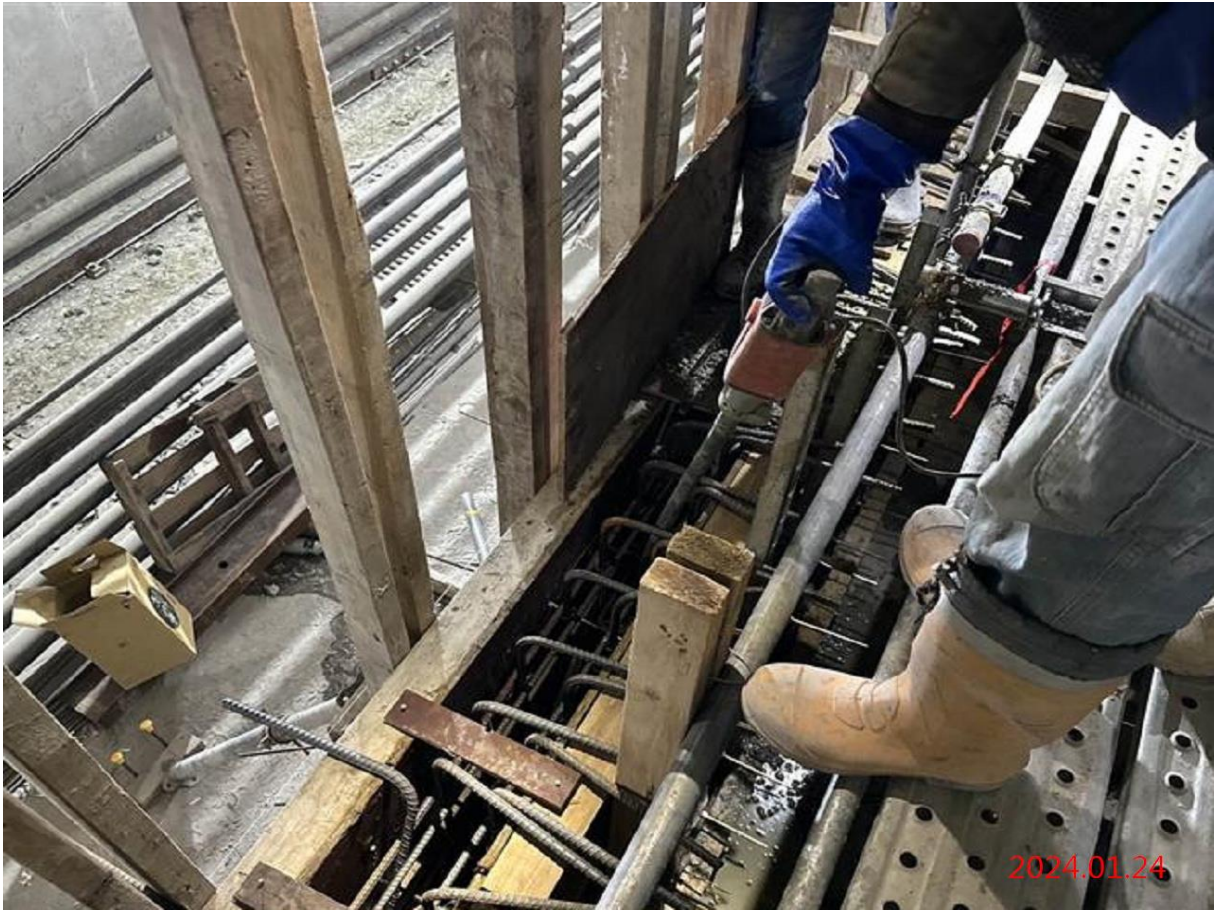
G12_站體月台層撐牆混凝土澆置
