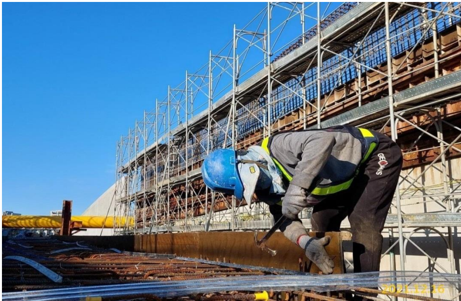
南出土結構體底版施作
