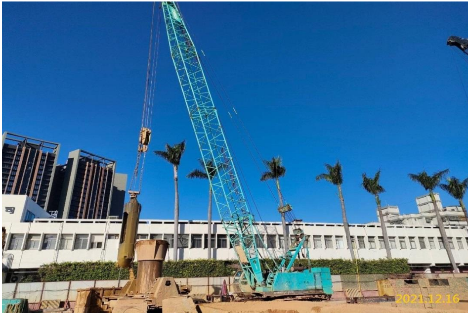
G05 站中間柱施作
