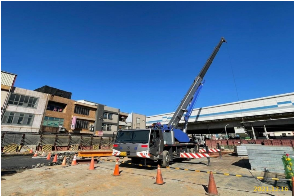
VS5 通風豎井覆蓋支撐系統施作
