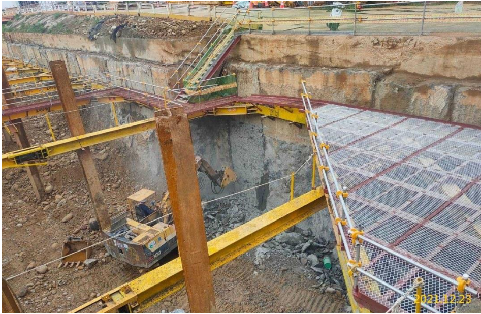
南出土開挖區連續壁壁面修飾作業
