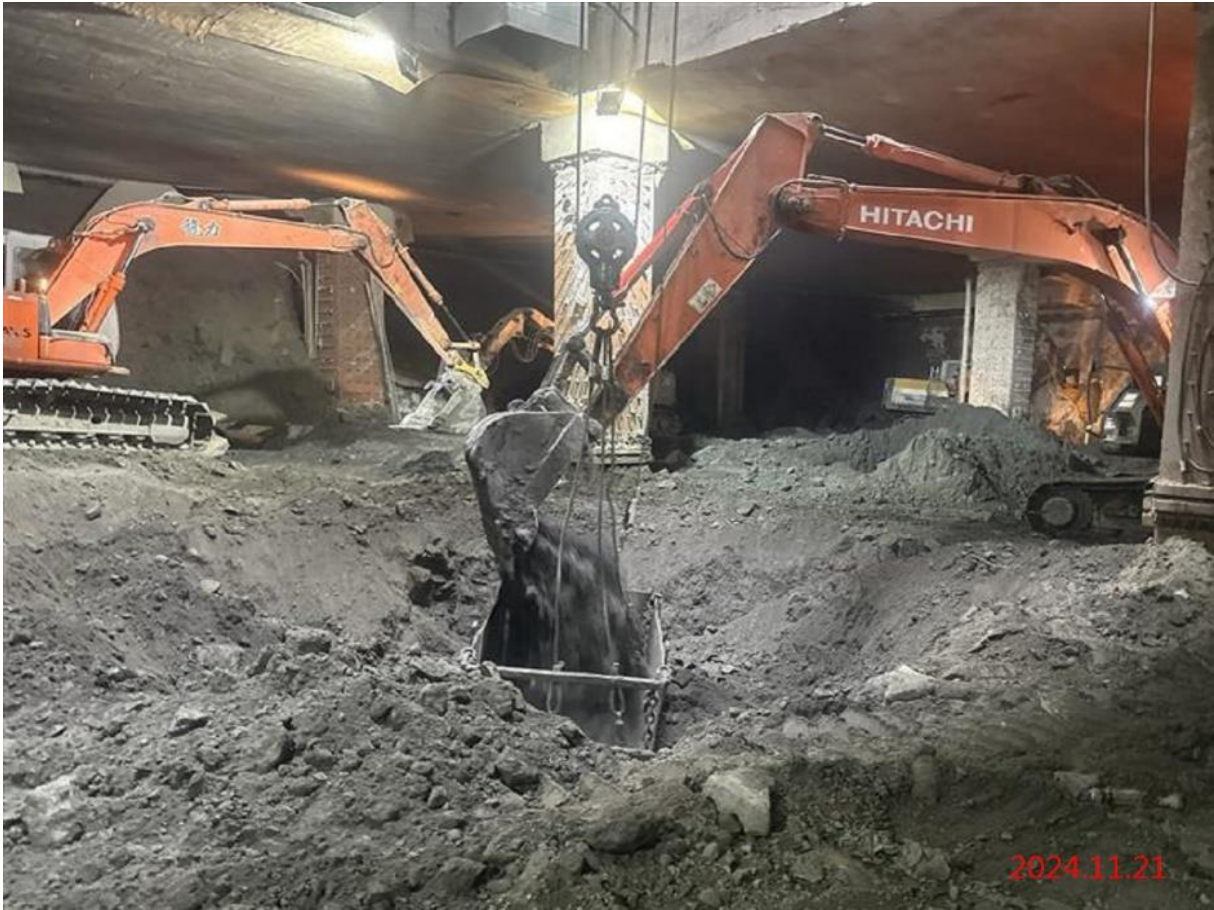
G07_結構 B5F 第六層開挖
