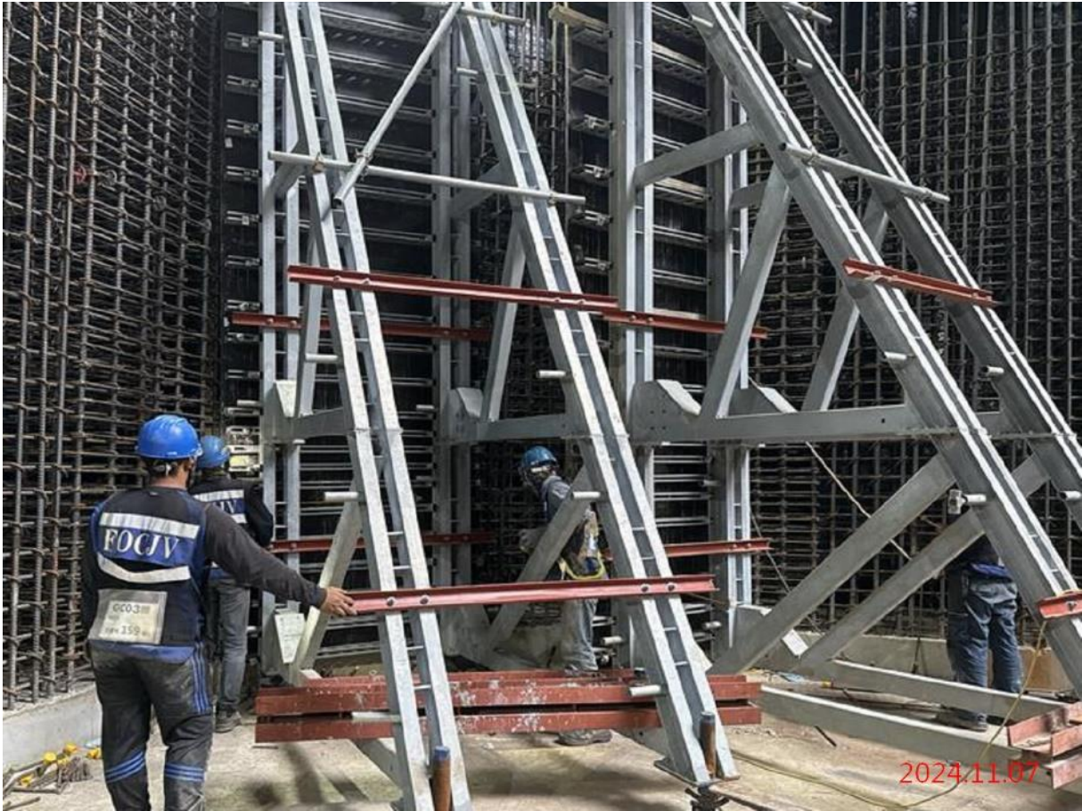
G09_B3F 南側斜面牆系統模板組立
