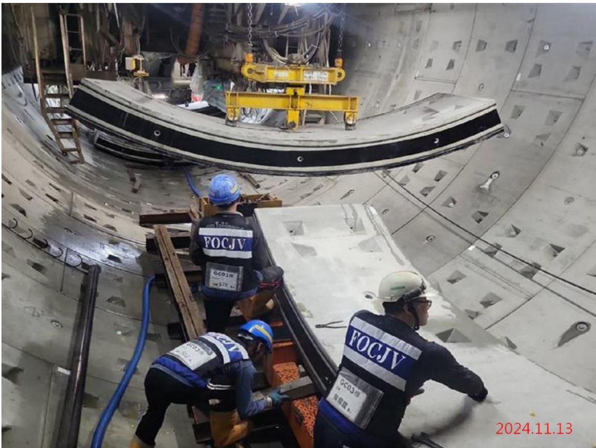
潛盾隧道_中圓下行線掘進(G09-G08)
