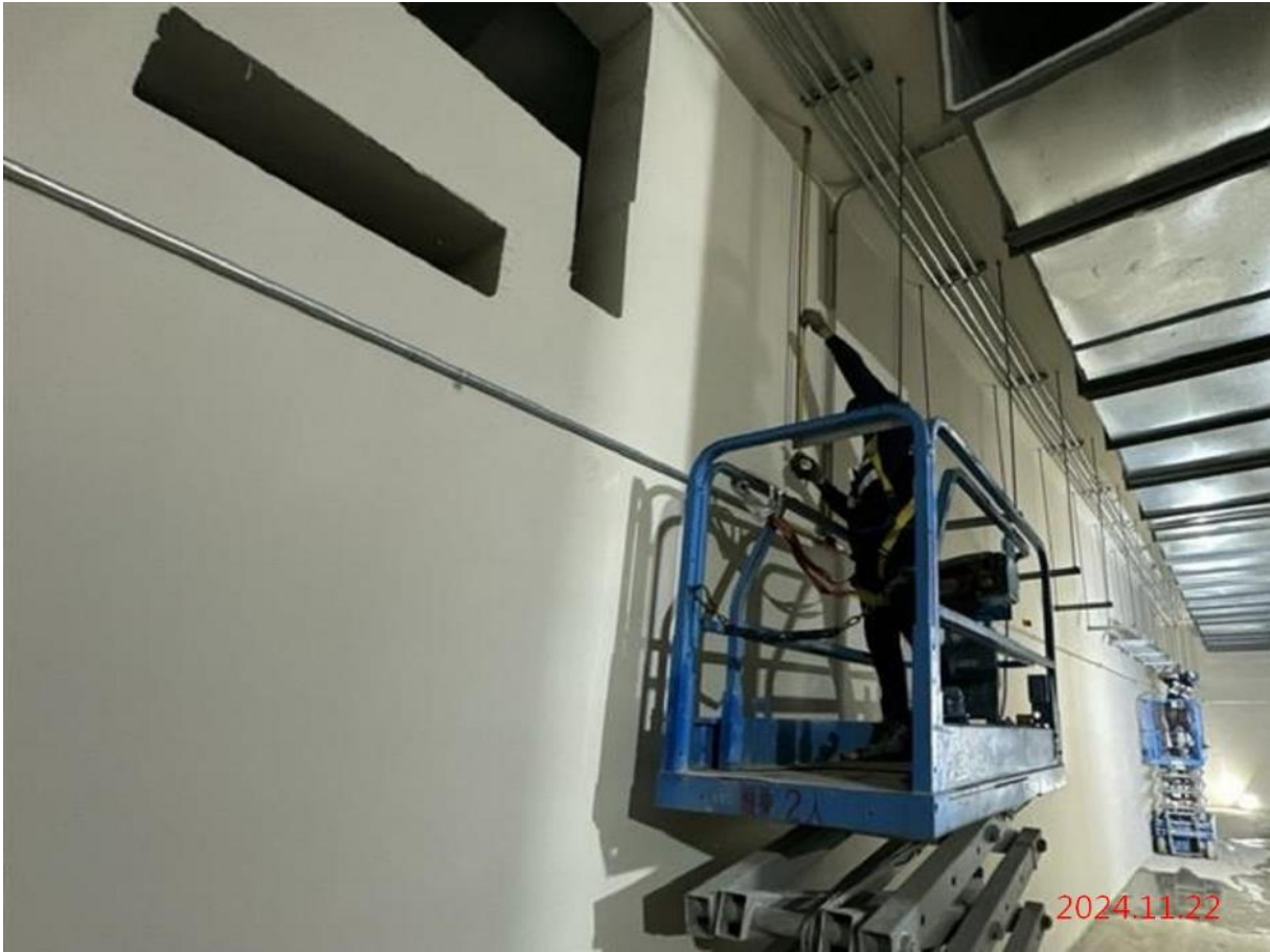
G12_穿堂層北機房區電氣系統-插座配管
