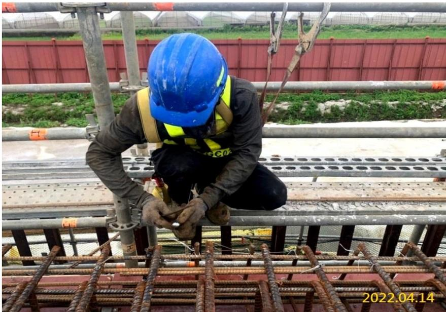
南出土段結構鋼筋綁紮作業
