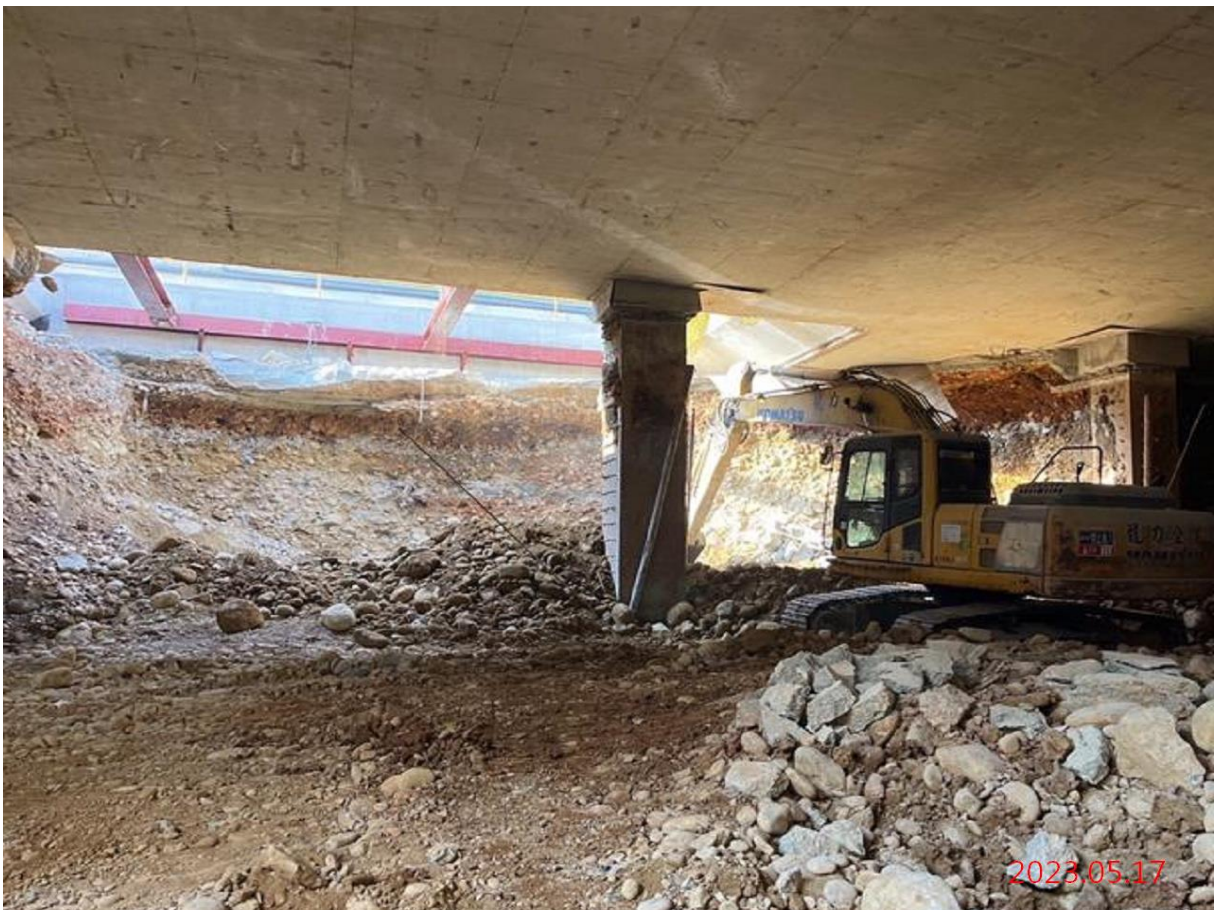
G07 站_站體結構 B1F 第二區開挖
