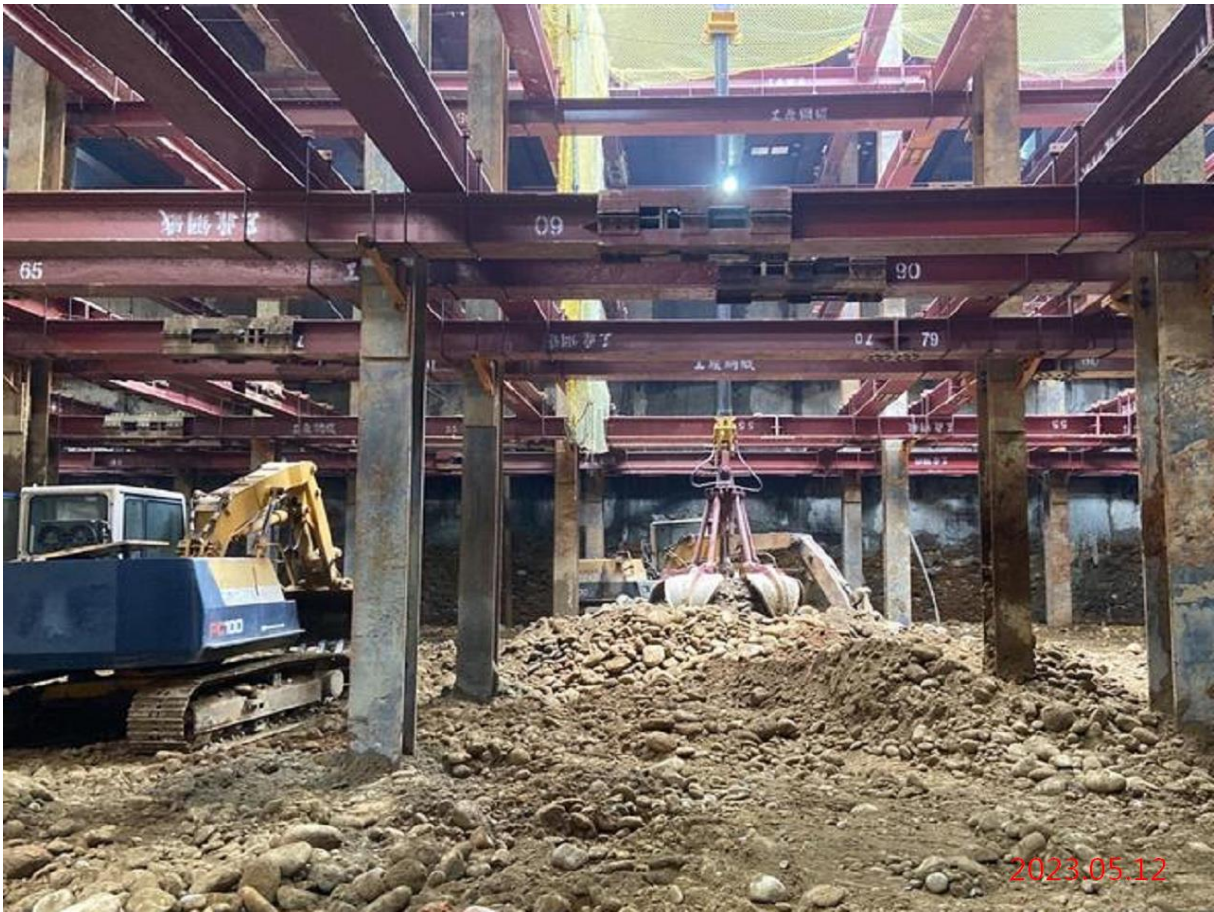
G09 站_第四層開挖
