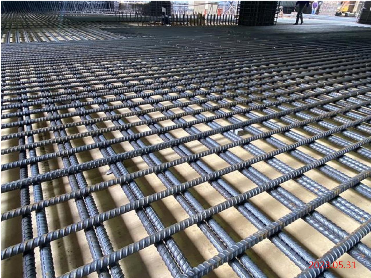
G07 站_站體結構 B1F 第一區下層板鋼筋綁紮
