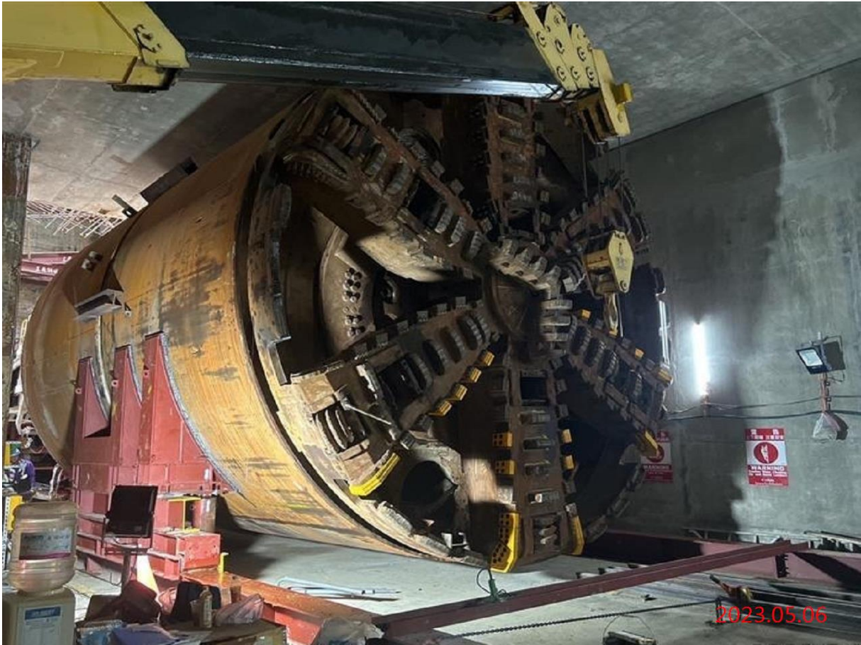
潛盾隧道_小圓上行線 G12 站內拖曳作業
