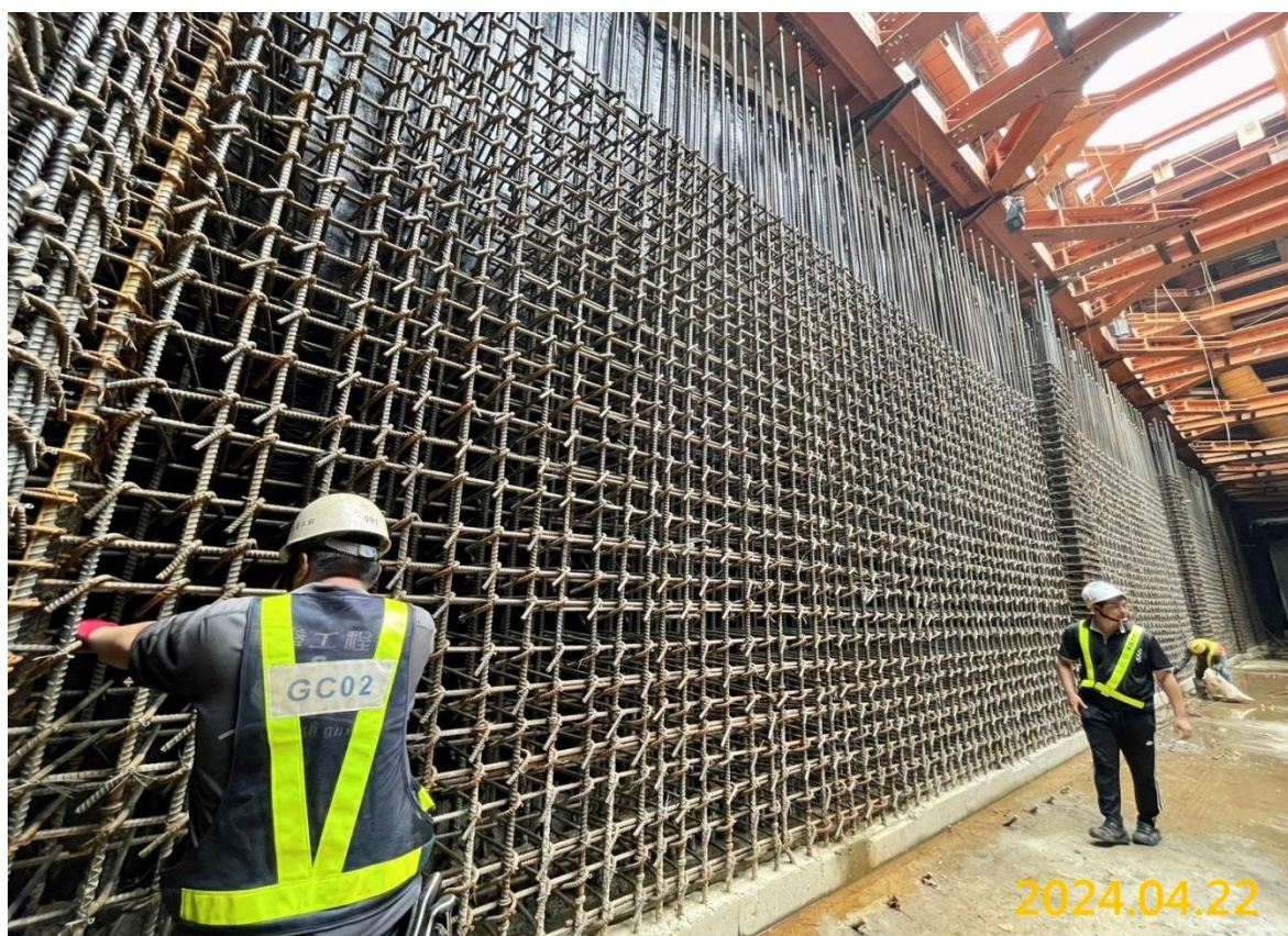
G03 站出入口結構牆身鋼筋綁紮
