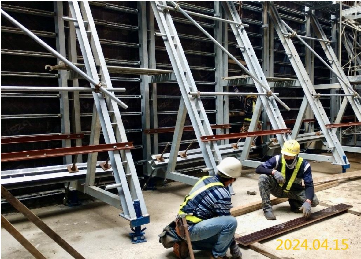
G06 出入口 B 結構體牆身系統模板組立
