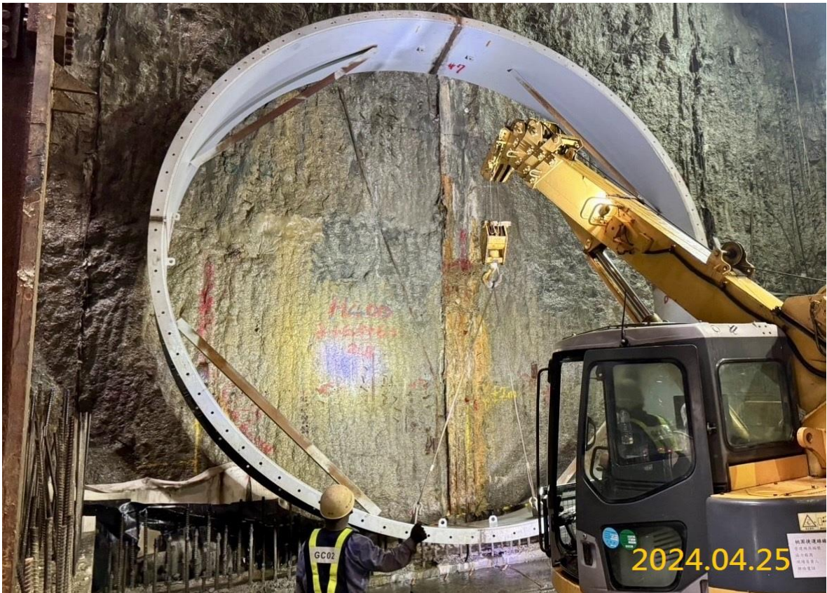
VS5 通風豎井隧道坑口環安裝
