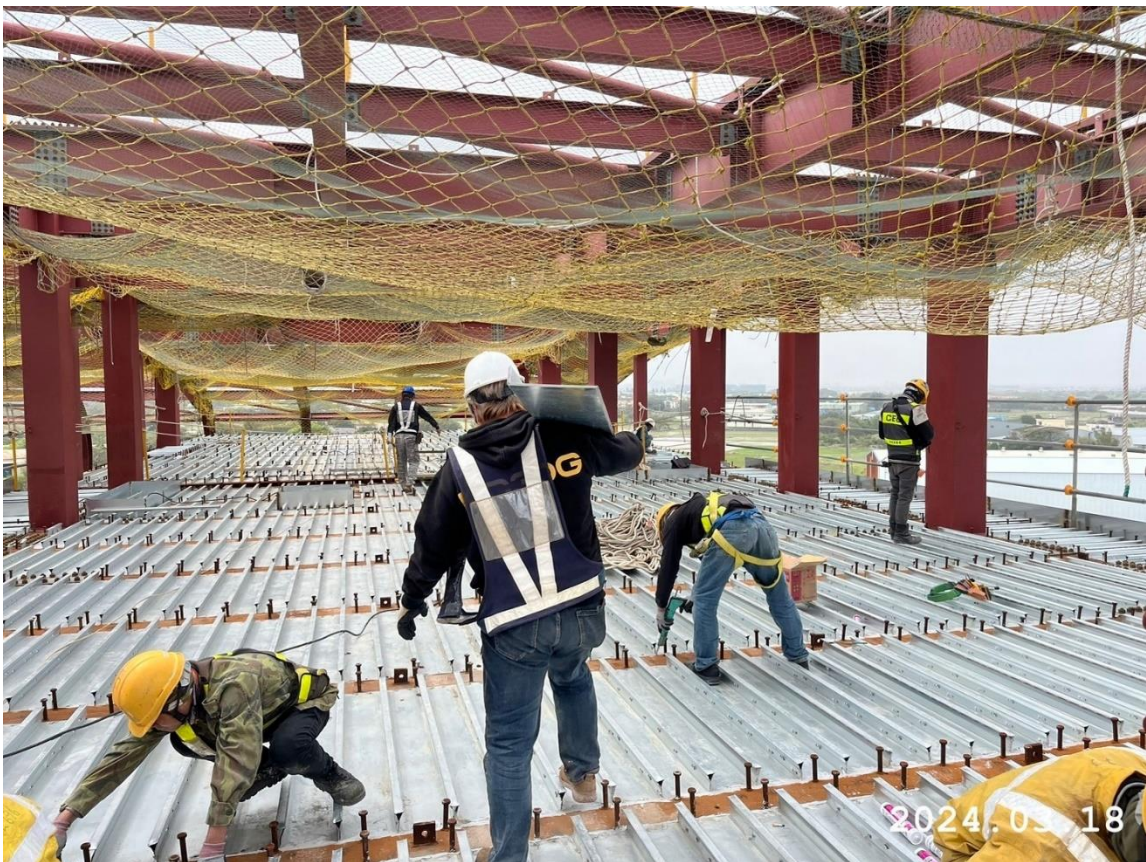
G14 站體鋼承板鋪設
