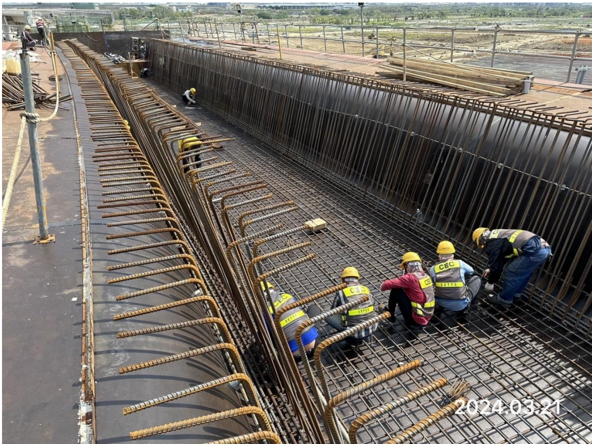
DU31-04 場撐箱梁鋼筋綁紮
