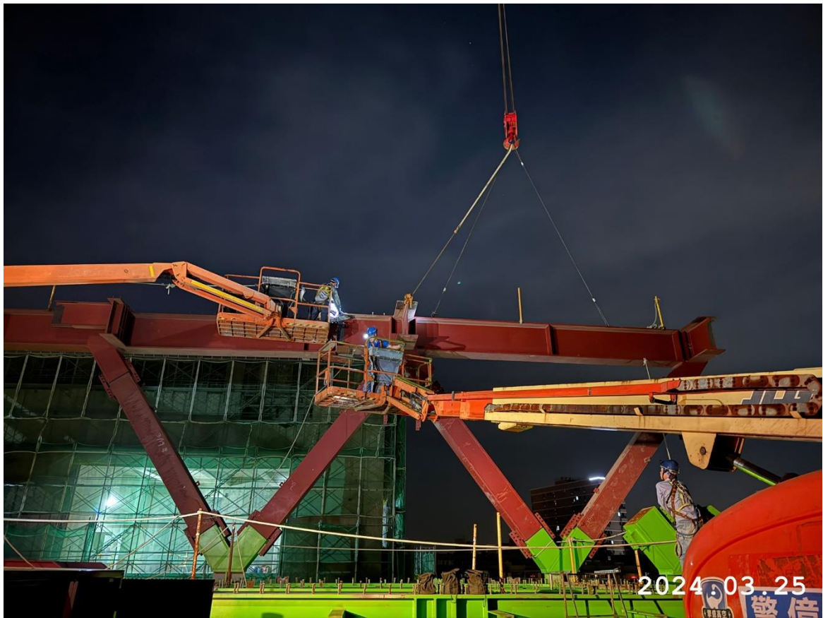
G31 站體吊裝作業
