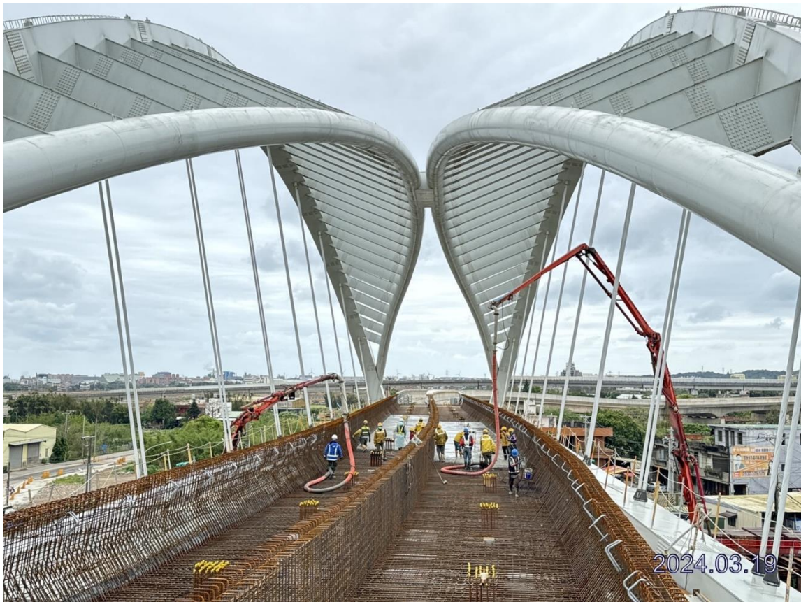
北段上構_DU31-08 拱橋段橋面版澆置
