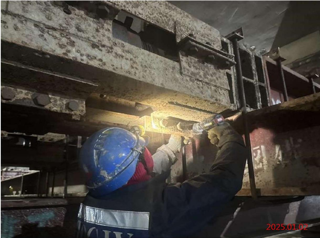
G07\_結構 B5F 擋土支撐鎖固
