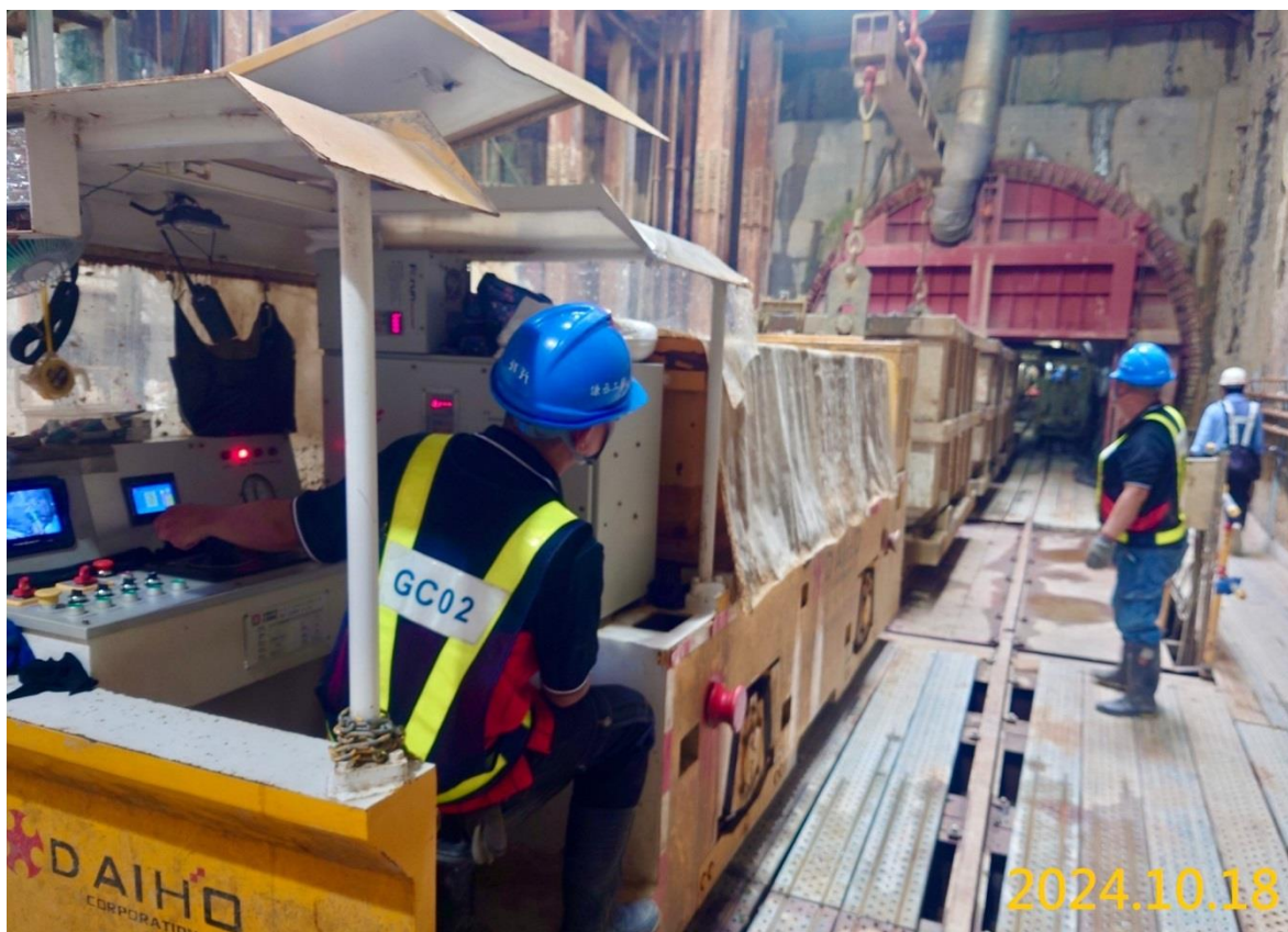
G03 站潛盾隧道掘進施作
