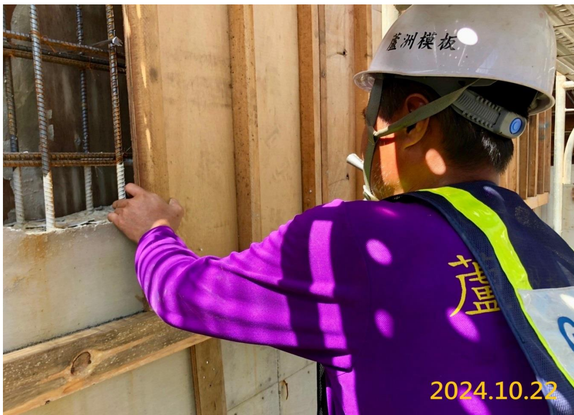
VS6 通風豎井隔間牆施作
