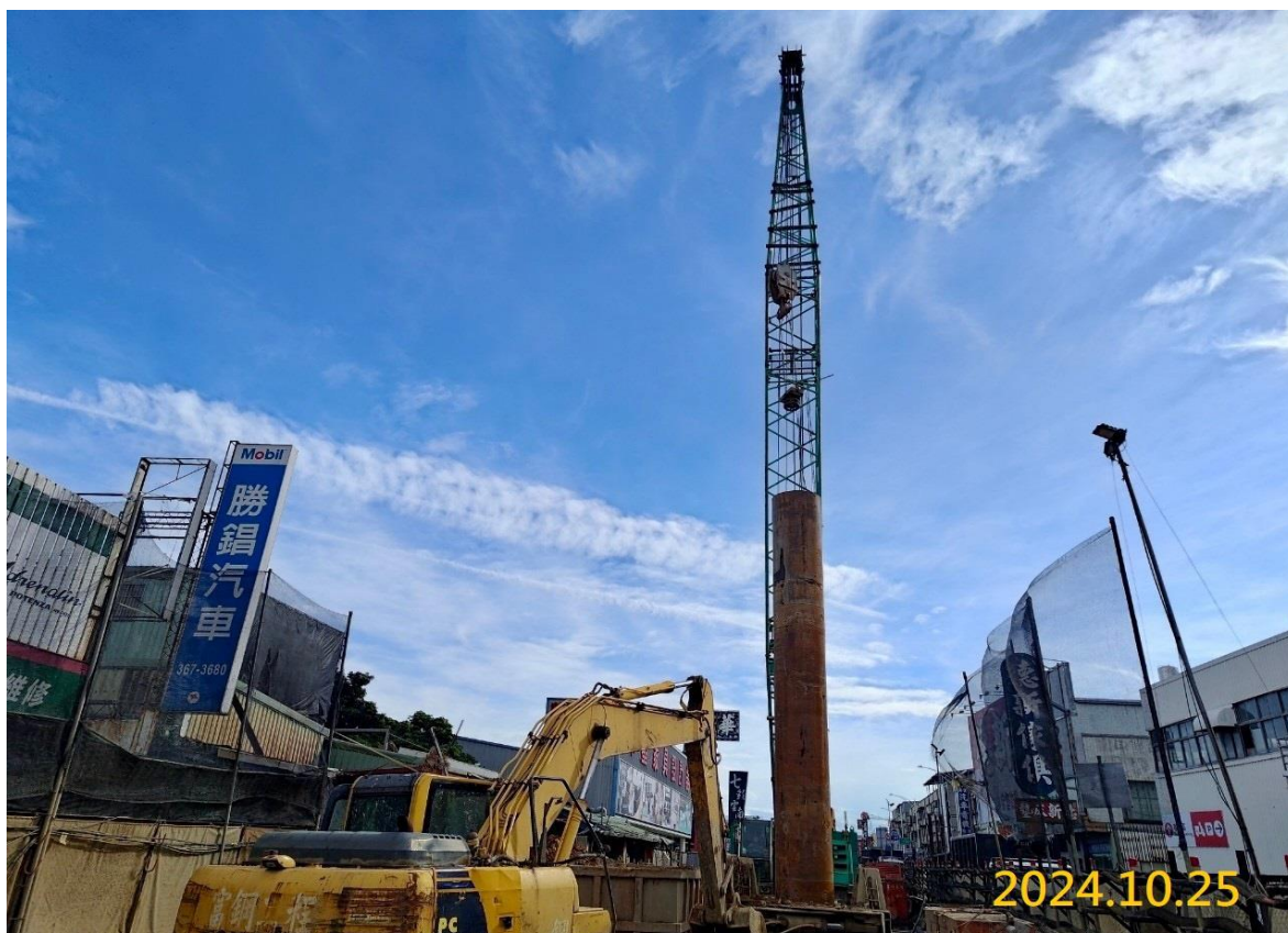
G04 中間柱施作
